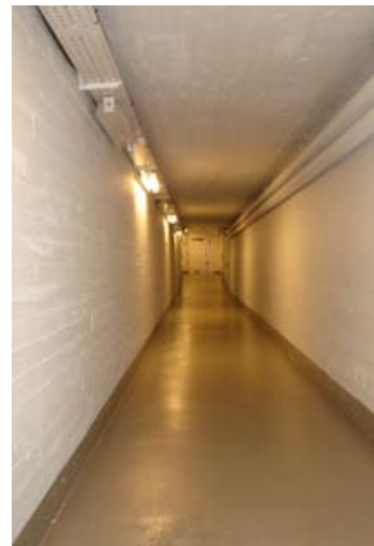
Kuvat: Käsiensuullas laboratorion näytteenotto-wc:ssä Käsihohde alikulkukäytävässä Alikulkukäytävä Suursuon sairaalaan
