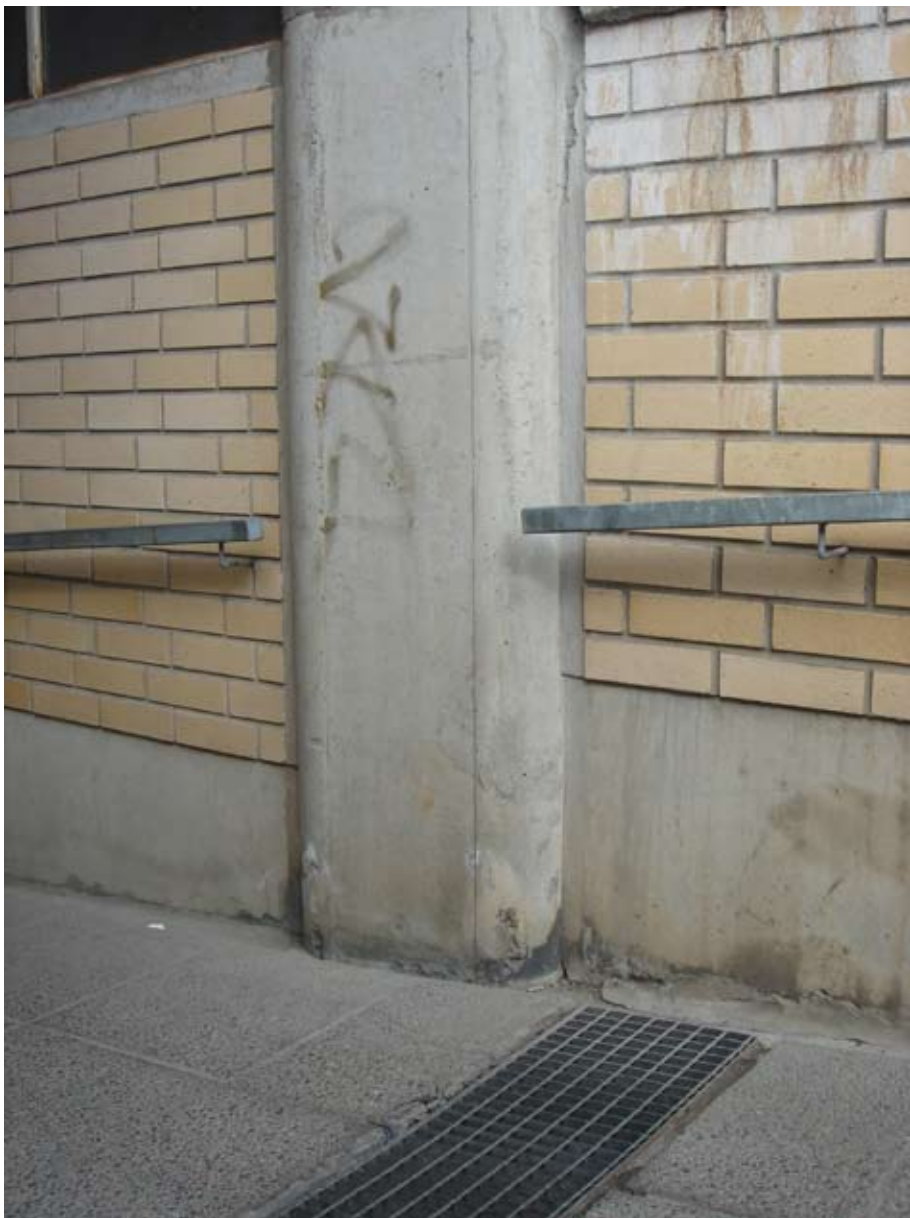
Kuvat: Kulkuväylän luiska on pitkä ja jyrkkä eikä siinä ole lepotasanteita. Käsijohde ei jatku yhtenäisenä koko matkalla.
