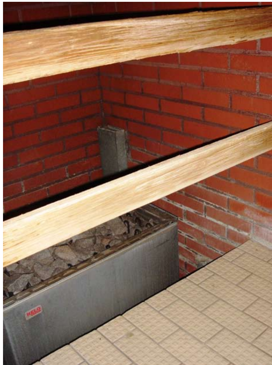
Kuva: Upotetun kiukaan suojaus on puutteellinen.
