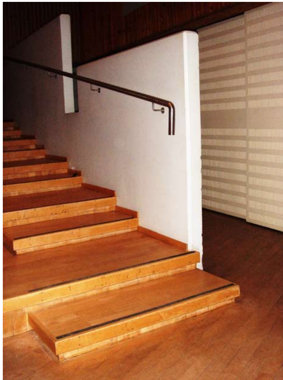
Kuva: Käsojohde loppuu liian aikaisin.
