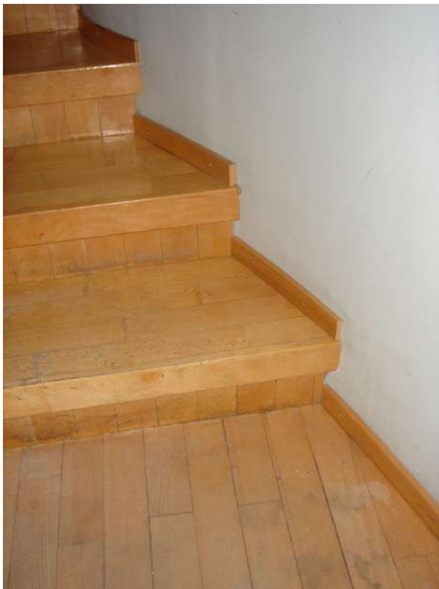
Kuva: Porrasaskelmista puuttuu kontrastiraita.
