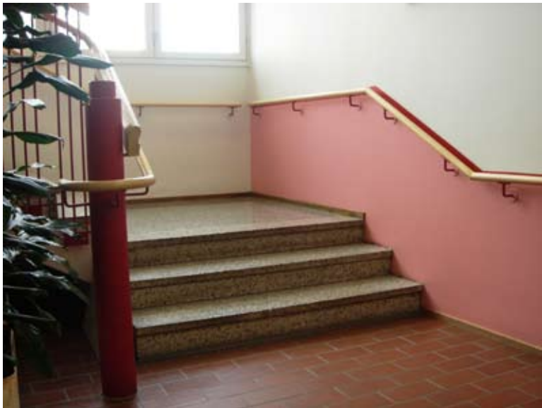
Kuvat: Portaiden askelmista puuttuu kontrastiraita.
