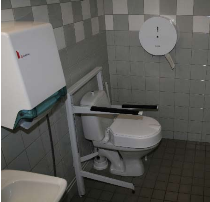
Kuvat: Tukikaiteiden rakenne hankaloittaa käyttöä.
