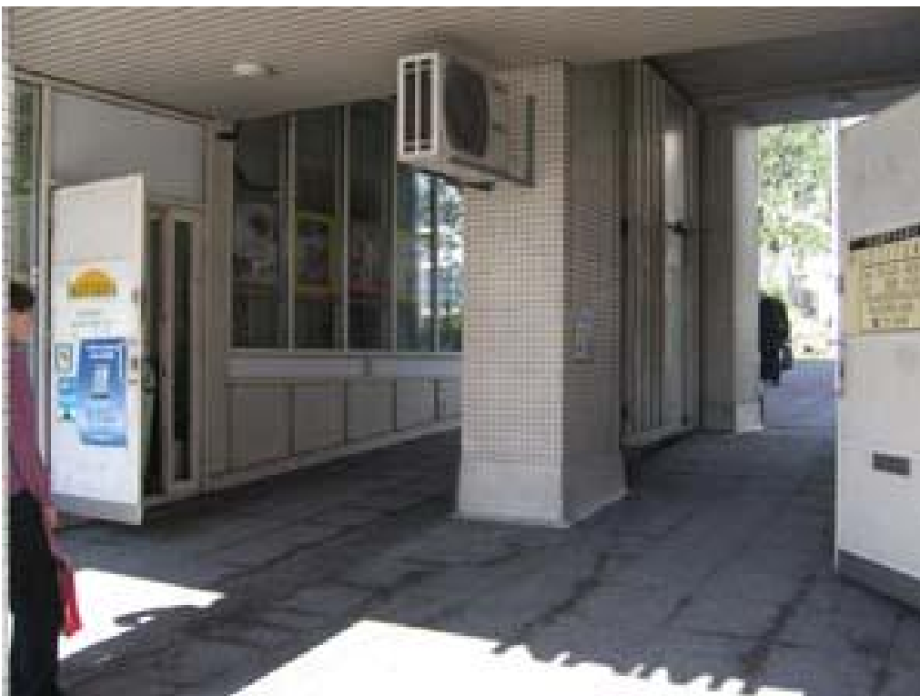
Kuva 3. Luiska sisäpihalle Hämeentien puolelta.
