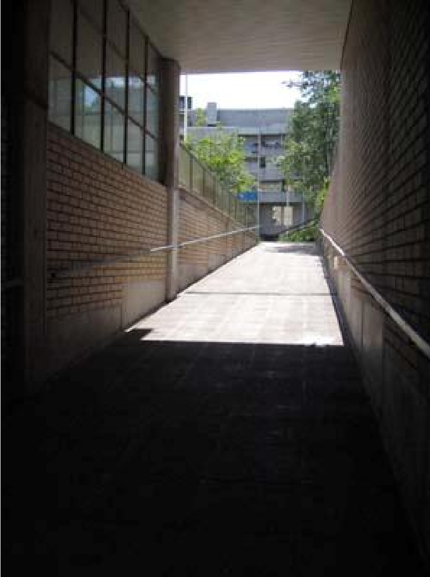
Kuva 4. Luiska sisäpihalle Kinaporinkadun puolelta.
