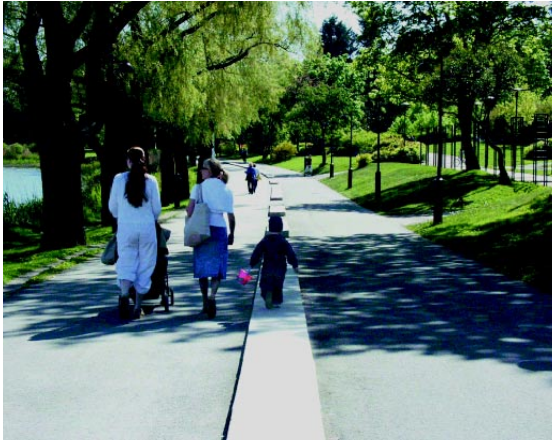
Kuva 7. Länsirannan kevyen liikenteen raitilla pyöräilijät ja jalankulkijat erotetaan toisistaan graniittipaadella. Paatta pidetään rumana ja se aiheuttaa kompastumisen vaaran.
