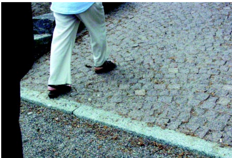
Kuva 10. Yhteydet Helsinginkadun ylittävälle suojateille on päällystetty lohkopintaisilla noppakivillä, jotka pienentävät liukastumisvaaraa, mutta muodostavat varsin epätasaisen kulkupinnan.
