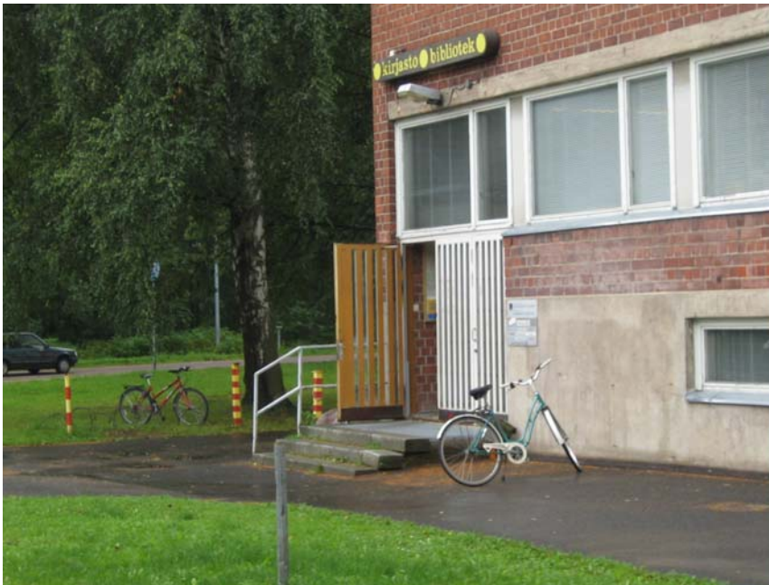
Kuva 42. Roihuvuoren kirjasto on suosittu asukkaiden oleskelu- ja kokoontumistila. Kirjaston sisäänkäynnin rakentaminen esteettömäksi edellyttäisi erittäin suuria muutoksia sisätilojen järjestelyissä.
