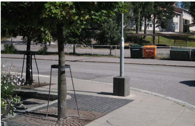
Kuva 18. Eränkävijäntorin kaakkoiskulmassa on valaisinpylväs, joka sijoittuu keskeisesti jalkakäytävälle ja aiheuttaa heikkonäköiselle henkilölle törmäysvaaran. Länsi-Herttoniemen toimenpidekartan kohta 7.
