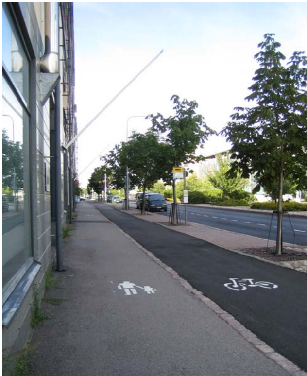
Kuva 25. Herttoniemen kevyen liikenteen väylien päällysteet ovat hyväkuntoisia ja kulkumuodot eroteltu lohkokiviraidoin useilla väylillä.
