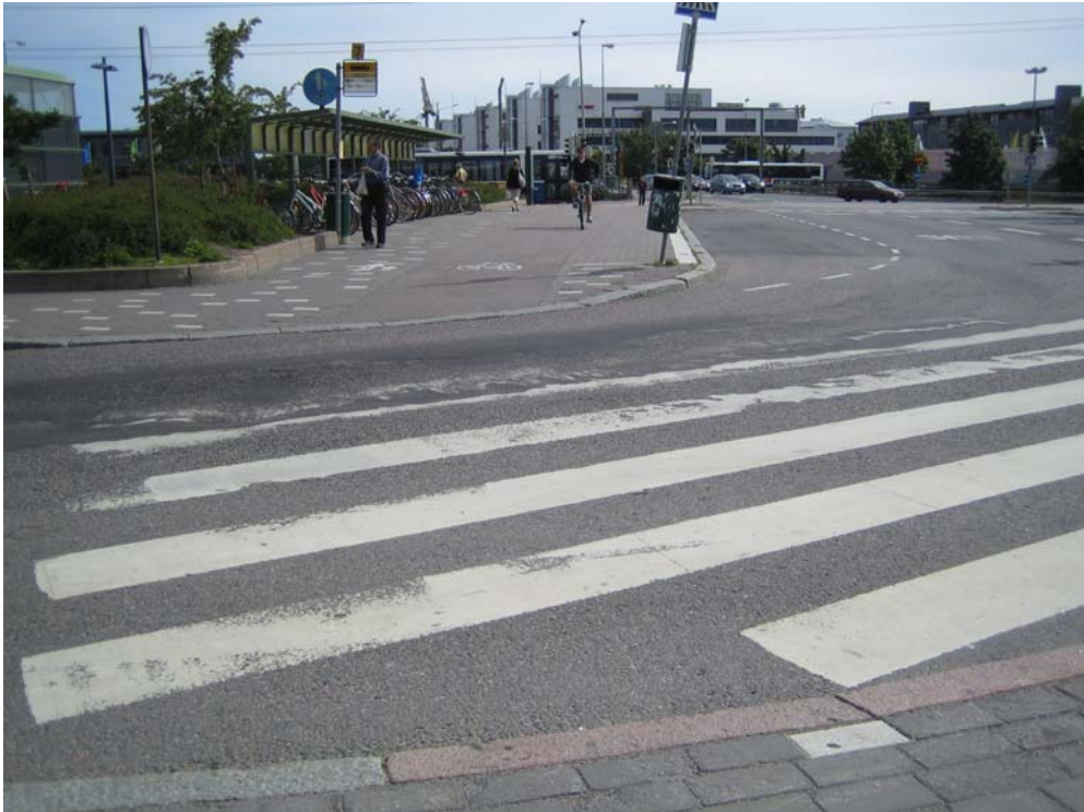
Kuva 11. Herttoniemen metroaseman ympäristön suojatiejärjestelyt ovat osittain sekavia. Metroasemalta Hiihtomäentielle johtavan leveän suojatien maalaus on huonokuntoinen.
