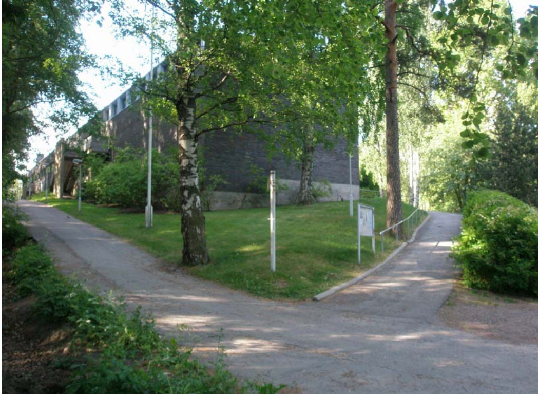
Kuva 20. Pohjois-Herttoniemen seurakuntatalon sisäänkäynnille ja rakennuksessa tilapäisesti toimivalle päiväkodille johtavat reitit ovat jyrkät.
