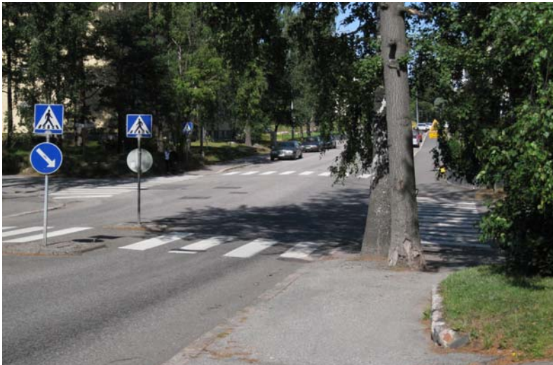
Kuva 17. Hiihtomäentiellä kaksi puunrunkoa aiheuttaa törmäämisvaaran kevyen liikenteen väylällä. Länsi-Herttoniemen toimenpidekartan kohta 4.
