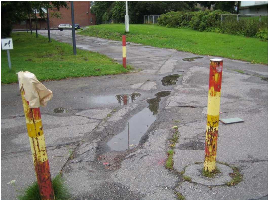
Kuva 35. Roihuvuorentieltä Porolahden koululle johtavan kevyen liikenteen väylän päällyste on erittäin epätasainen. Roihuvuoren toimenpidekartan kohta 8.
