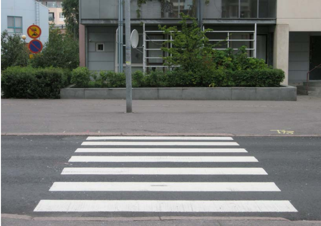
Kuva 31. Laivalahdenkaari 12 kohdalla on valaisinpylväs keskellä suojatielinjaa. Pylväs aiheuttaa törmäysvaaran näkövammaiselle henkilölle. Herttoniemenrannan toimenpidekartan kohta 6.
