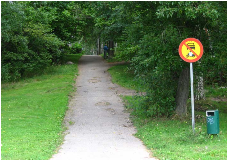
Kuva 40. Satumaanpuistoon johtavan puistotien päällyste on erittäin huonokuntoinen ja reitti hämärä. Roihuvuoren toimenpidekartan kohta 5.
