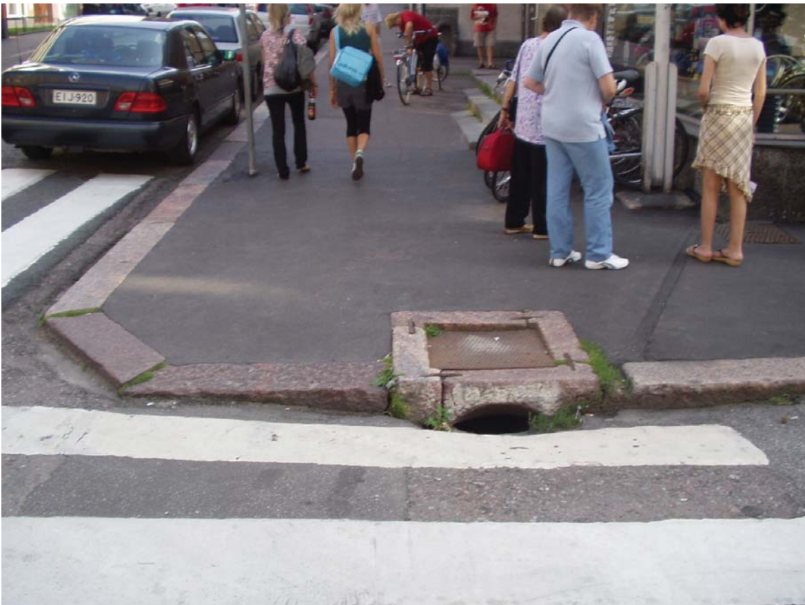
Kuva 20. Kitakaivot nostavat usein reunatukia suojateiden kohdalla.
