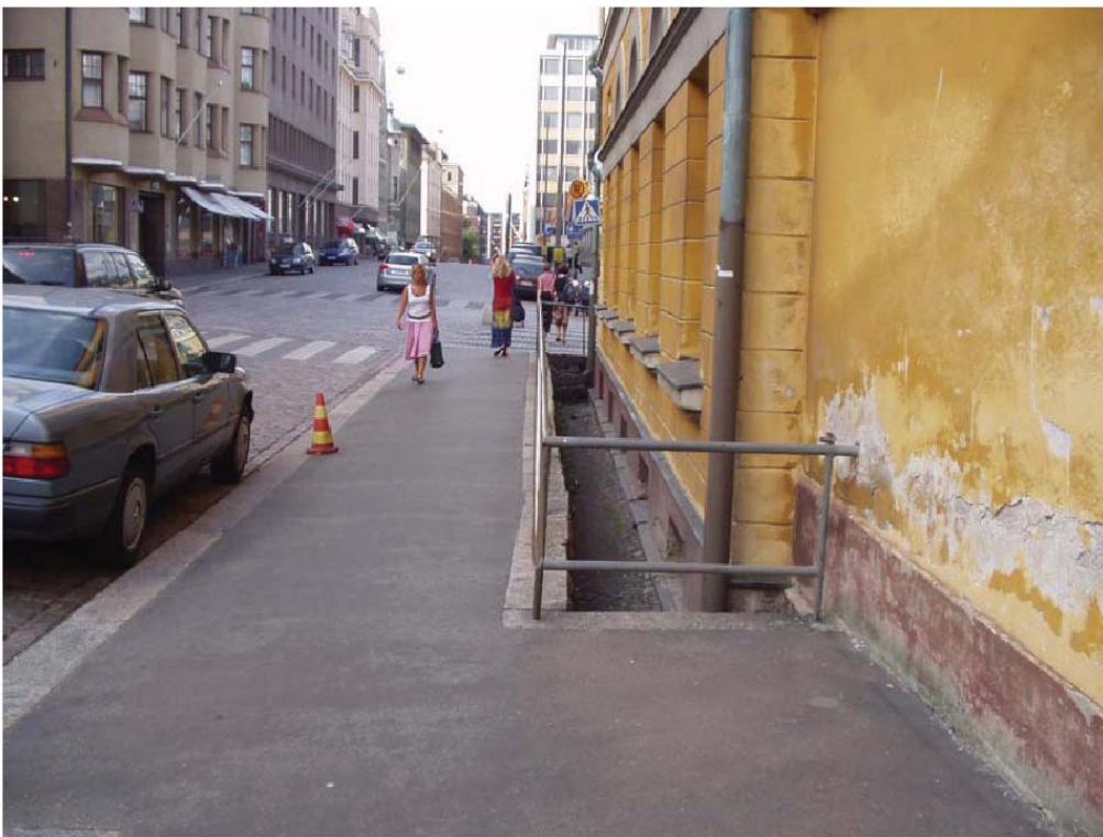
Kuva 30. Valokuvasovituksessa putoamisvaaraa aiheuttavan kiinteistön rakenteen suojakaiteeseen Kasarmikadulla on lisätty alapiena, jonka näkövammaiset voivat tunnistaa kepillä.
