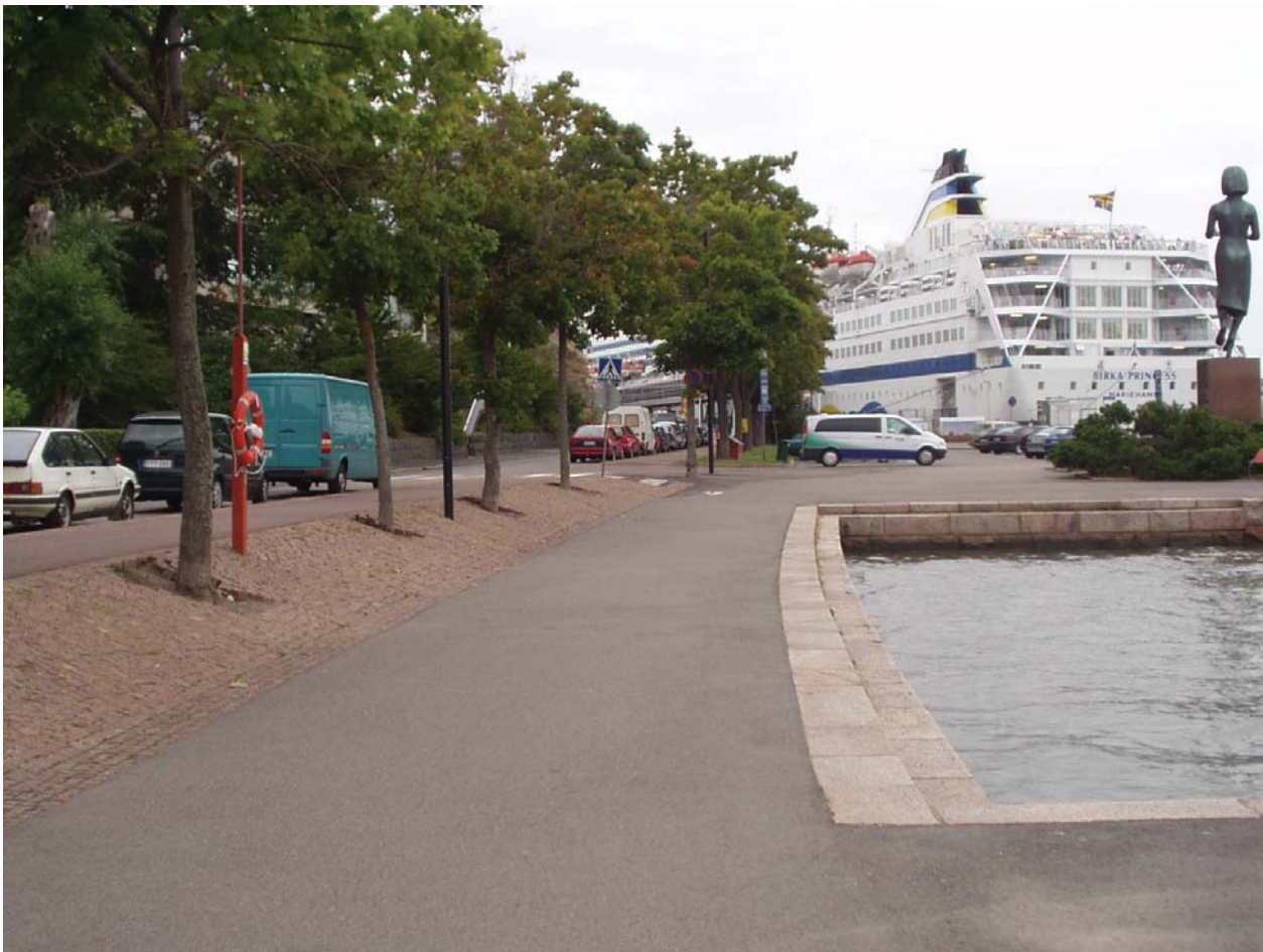
Kuva 12. Rantaraitti on selvästi erotettu ajoradasta ja pyörätiestä, mutta altain reunasta puuttuvat varoittavat vyöhykkeet.
