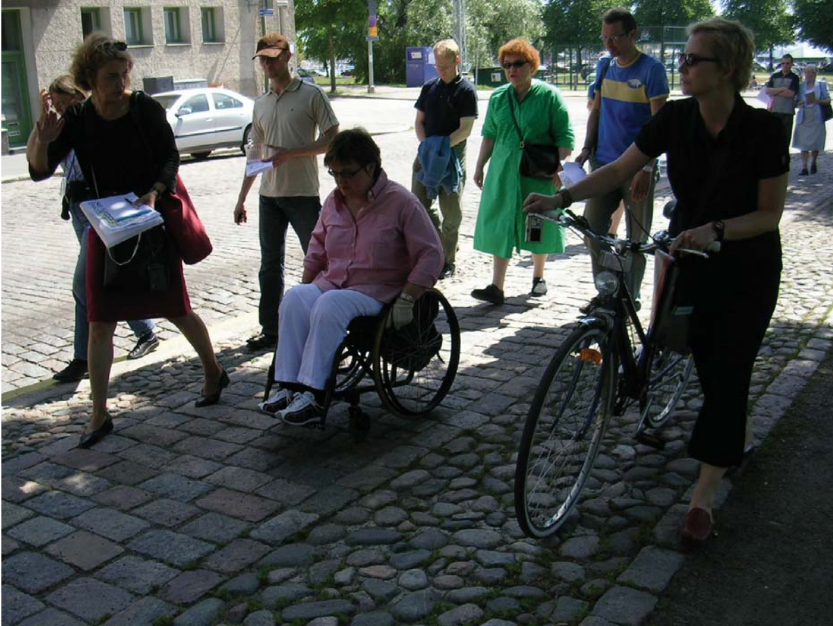
Kuva 5. Laivurinkadun historiallinen kivipäälyste jalkakäytävällä on erittäin epämiellyttävä pyörätuolin käyttäjälle.
