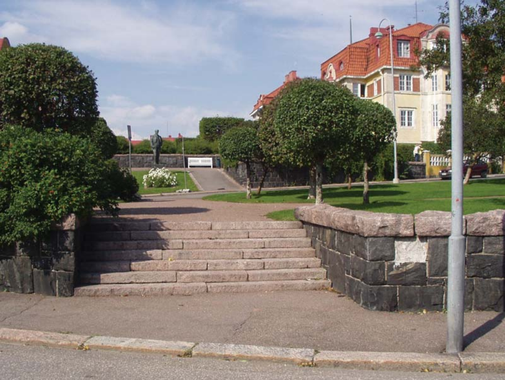
Kuva 21. Reunatuet ovat usein korkeita puistokäytävien kohdalla ja vanhoista kiviportaista puuttuvat kaitteet.
