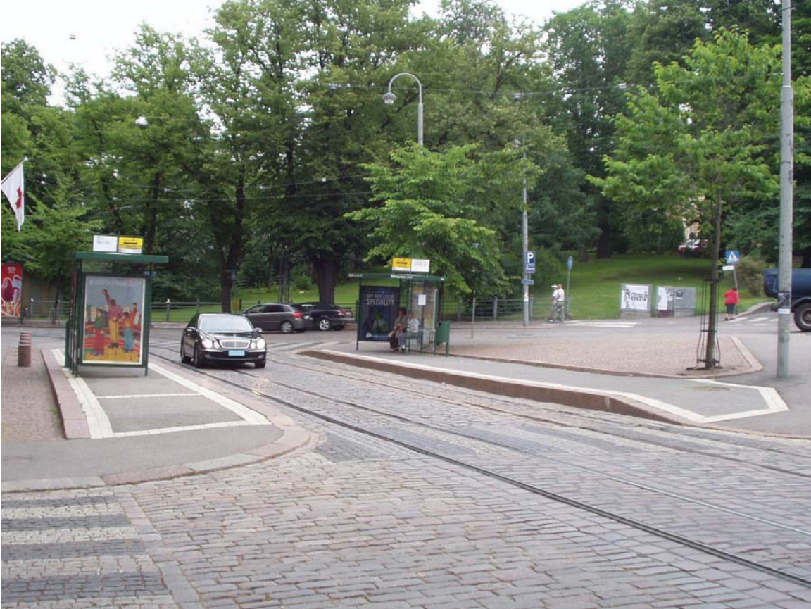
Kuva 10. Kaikki Tehtaankadun raitiotiepysäkit on korotettu ja merkitty asianmukaisin reunamerkin- noin.
