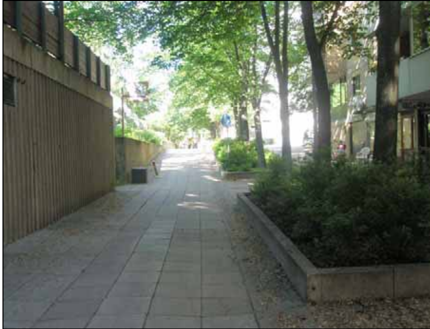
Kuva 40. Resiinakujan betonilaatoitus on epätasainen ja paikoin vaurioitunut ja se tulee korjata, Itä-Pasilan toimenpidekartan kohta 5.
