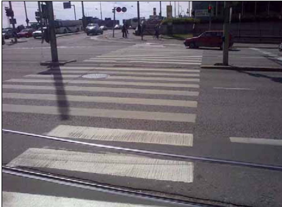
Kuva 25. Pasilan aseman edustan risteysalueen suojatiejärjestelyt eivät täytä esteettömyyden erikoistason vaatimuksia.
