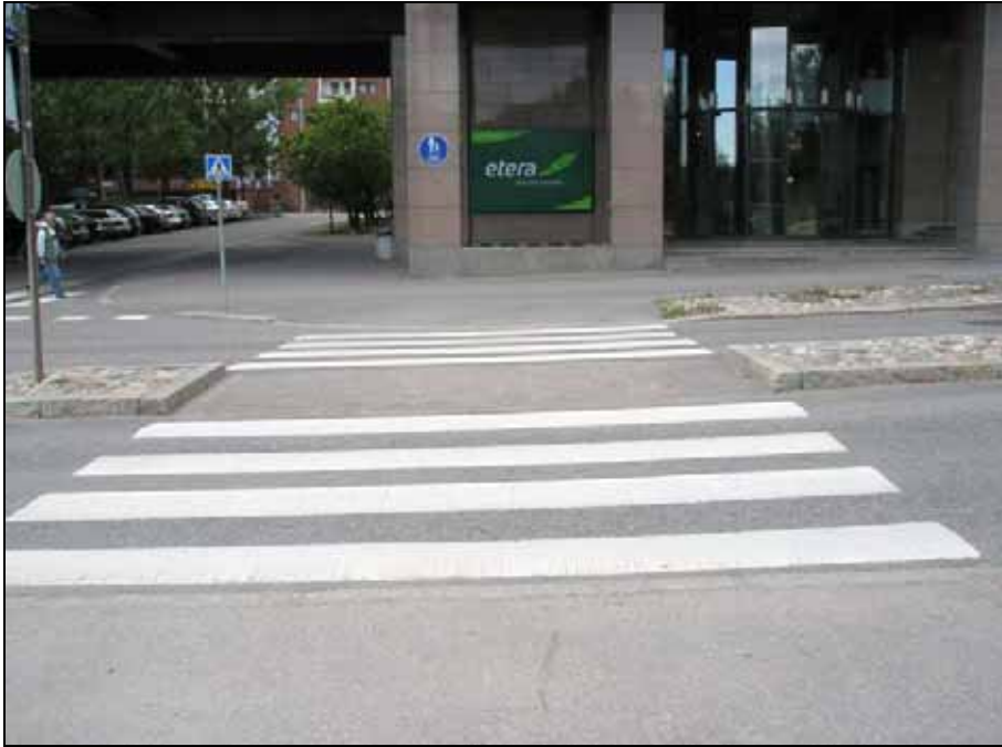
Kuva 9. Pasilankadun varrella on suojateissä liian matalia reunatukia sekä reunatuettoimia keskisaarekkeita.
