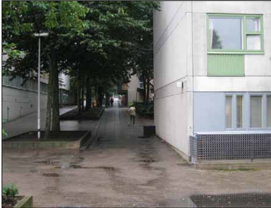
Kuva 44. Pasilan toimintakeskuksen Resiinakujan itäpään kulmalle tulee lisätä samanlainen graniittikuutio kuin rakennuksen toisessa kulmassa on sekä asentaa kuution ympärille 600 mm leveä varoitusalue, Itä-Pasilan toimenpidekartan kohta 9.
