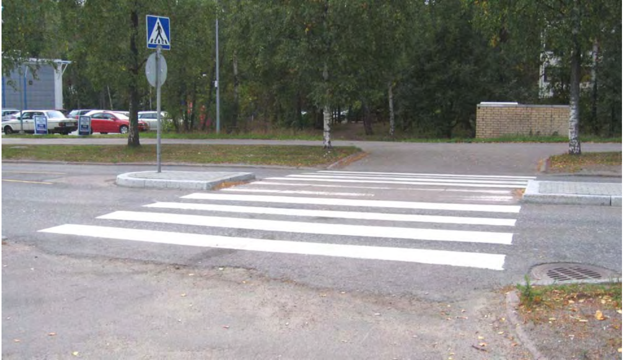
Kuva 6. Suojatiestä puuttuu reunakivet, keskikoroketta ei ole korotettu ja suojatiemerkintöjen jatkuminen keskisaarekkeen kohdalla vaikeuttaa sen hahmottamista.
