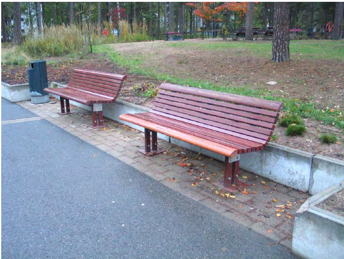
Kuva 4. Levähdyspaikat on merkitty hyvin kontrastimateriaalivyöhykkeellä ja pyörätuoli mahtuu penkkien väliin, vain käsinojat puuttuvat.
