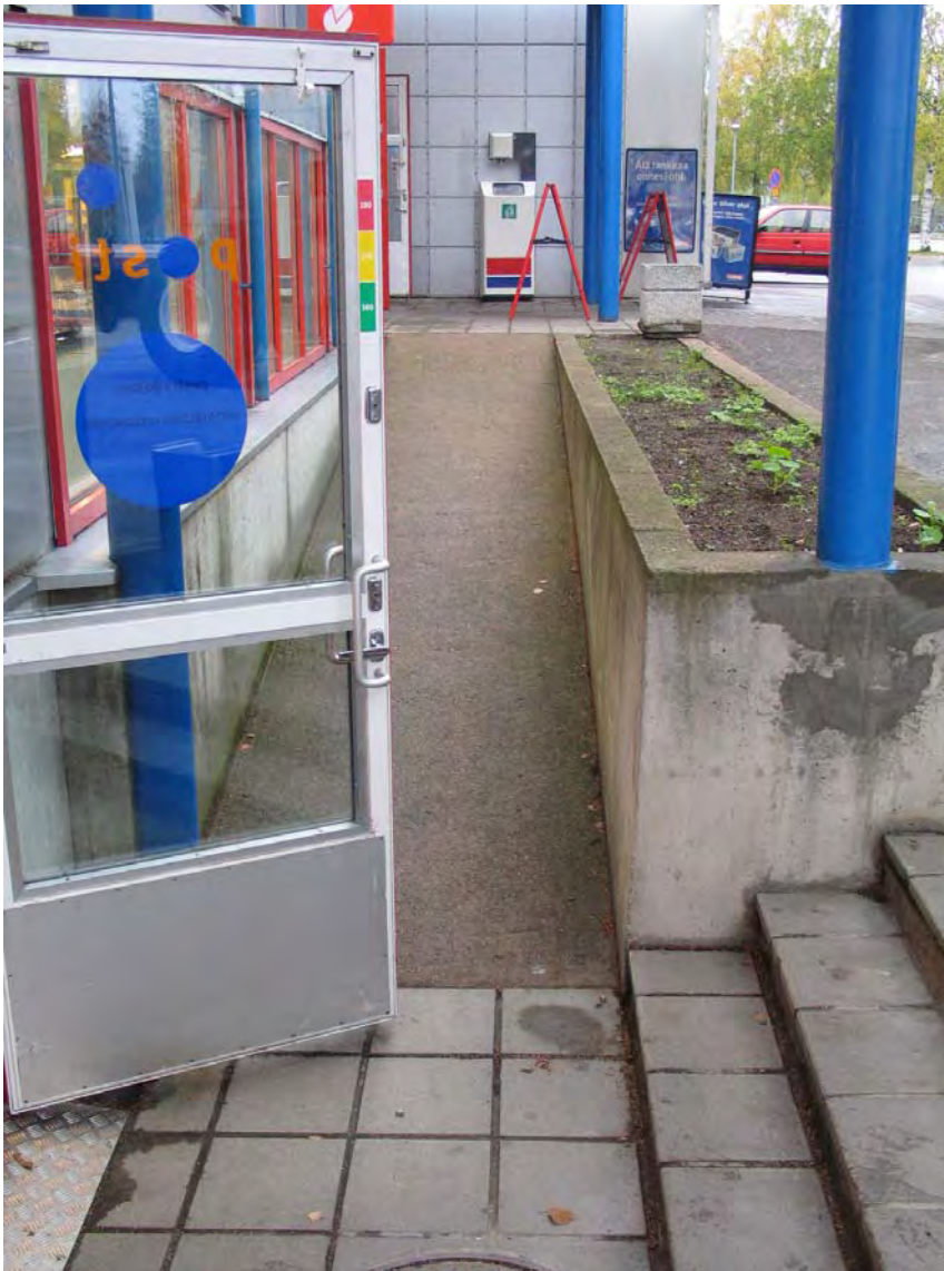
Kuva 9. Oven avautuminen luiskan eteen estää pyörätuolin käyttäjän tai lastenvaunujen kanssa liikkuvan pääsyn postiin.
