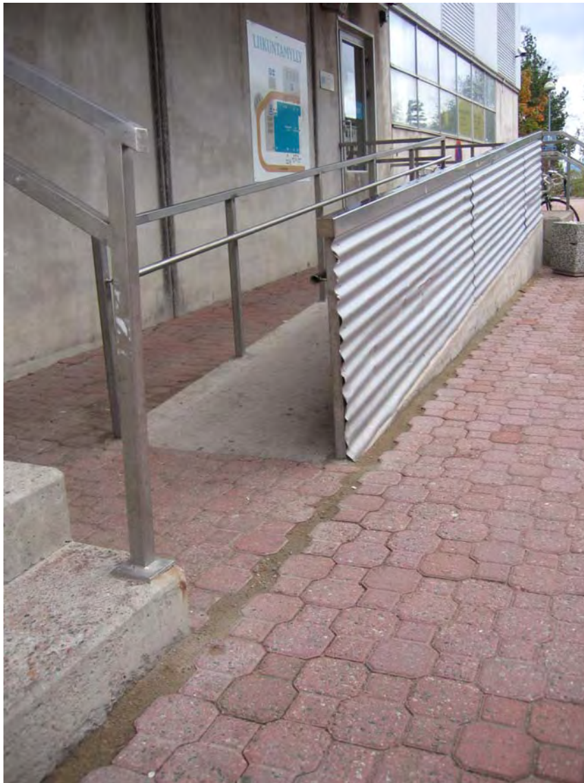
Kuva 10. Liikuntamyllyn pääsisäänkäynnin luiska on liian kapea eikä alhaalla ole riittävästi tilaa lastenvaunujen tai pyörätuolin kääntämiseen.
