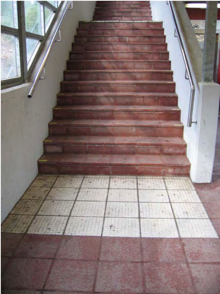
Kuva 14. Kontrastimateriaalivyöhykkeen ansiosta portaiden tasanteet on helppo hahmottaa. Toisen käsijohteen pää aiheuttaa kuitenkin kiinnitakertumisvaaran eikä portaissa ole kontrastiraitoja askelmien reunoissa.
