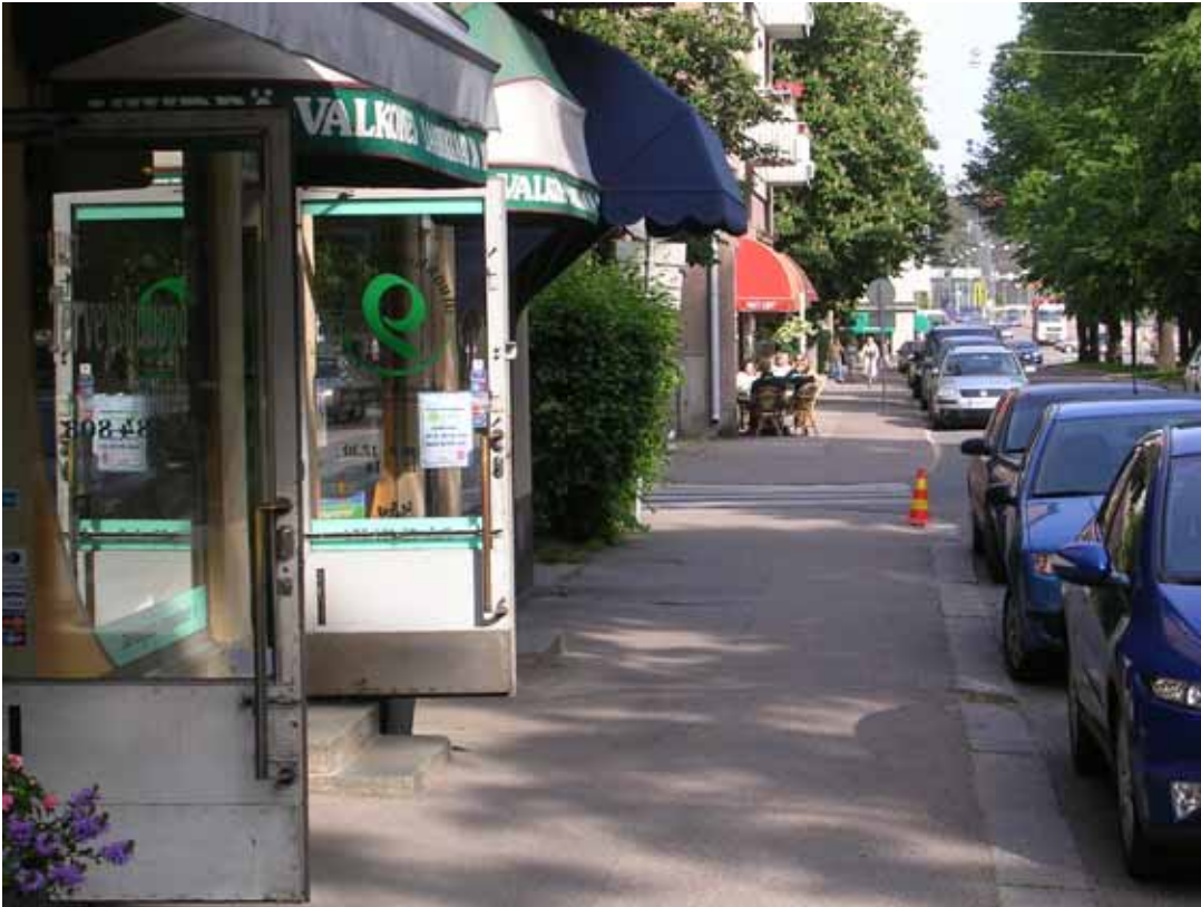
Kuva 11. Munkkiniemen puistotien jalkakäytävälle työntyy useissa kohdin sisäänkäyntien portaita, jotka yhdessä avattujen ovien kanssa ovat vaarallisia heikkonäköisille ja sokeille. Sisäänkäyntejä ei saa parannettua esteettömiksi.
