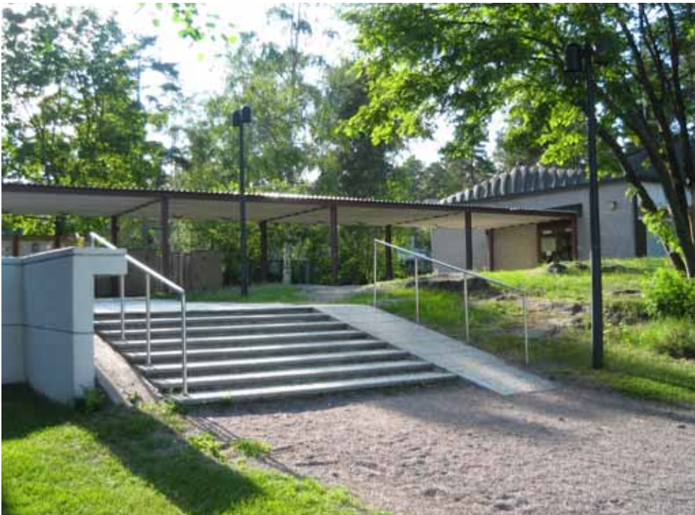
Kuva 36. Munkkivuoren kirkon portaaseen lisätään käsijohde portaan ja luiskan väliin. Munkkivuoren toimenpidekartan kohta 2. Puistoväylän päällystäminen kivituhkalla on rakennusviraston ylläpitotoimenpide. Munkkivuoren toimenpidekartan kohta 7.
