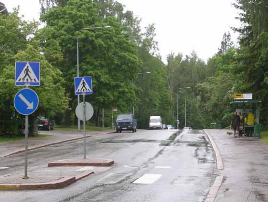
Kuva 21. Ulvilantien suojatiejärjestelyt keskisaarekkeineen ja madallettuine reunatukineen ovat esteettömyydeltään tyydyttäviä.
