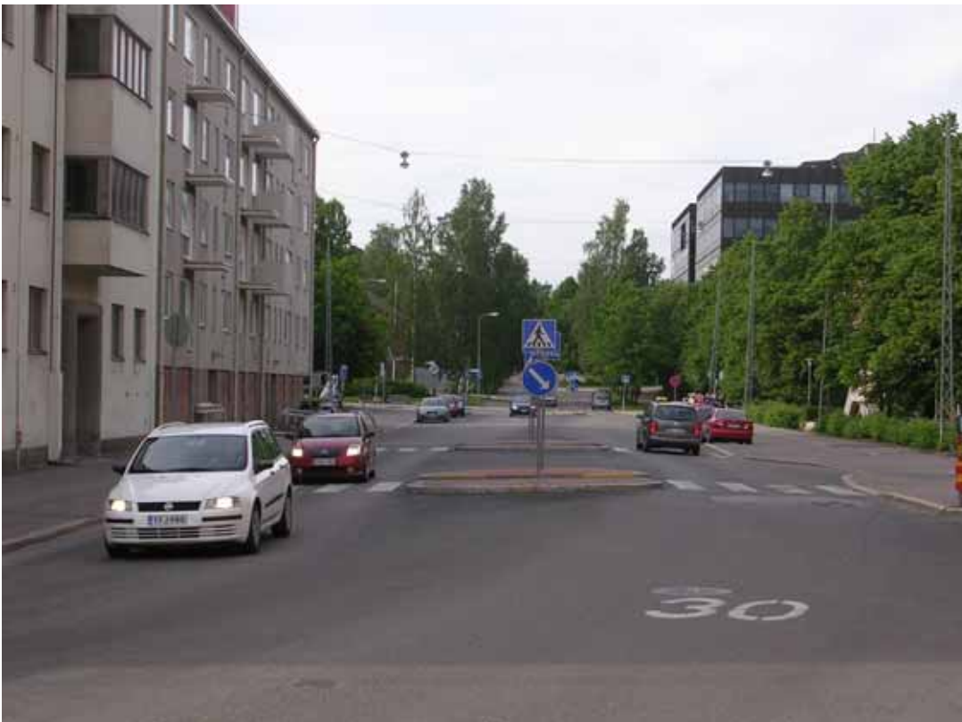
Kuva 12. Laajalahdentietä suojatiejärjestelyineen on viime vuosina parannettu. Riittävän leveät jalkakäytävät ja uusitut suojatiejärjestelyt keskisaarekkeineen ovat tyydyttäviä esteettömyydeltään.
