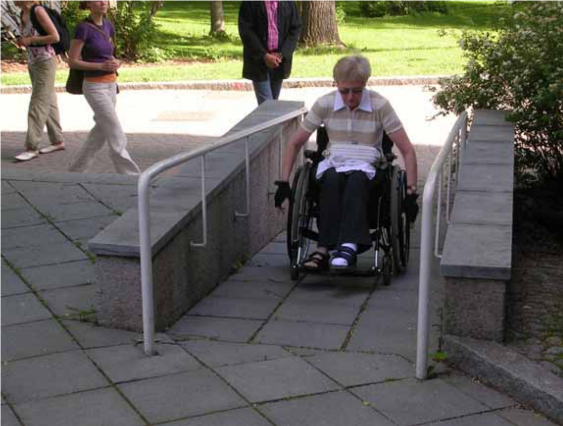
Kuva 29. Munkkiniemen kirkon edustan luiskaa pystyvät omatoimisesti käyttämään vain ne, joilla on erittäin hyvät käsivoimat. Munkkiniemen toimenpidekartan kohta 7.
