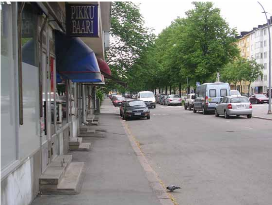
Kuva 14. Sisäänkäyntien portaat kaventavat jalkakäytäviä ja aiheuttavat kompastumisvaaran heikkonäköisille ja sokeille Huopalahdentiellä. Sisäänkäyntien parantaminen esteettömiksi vaatisi laajoja muutoksia kadulla.
