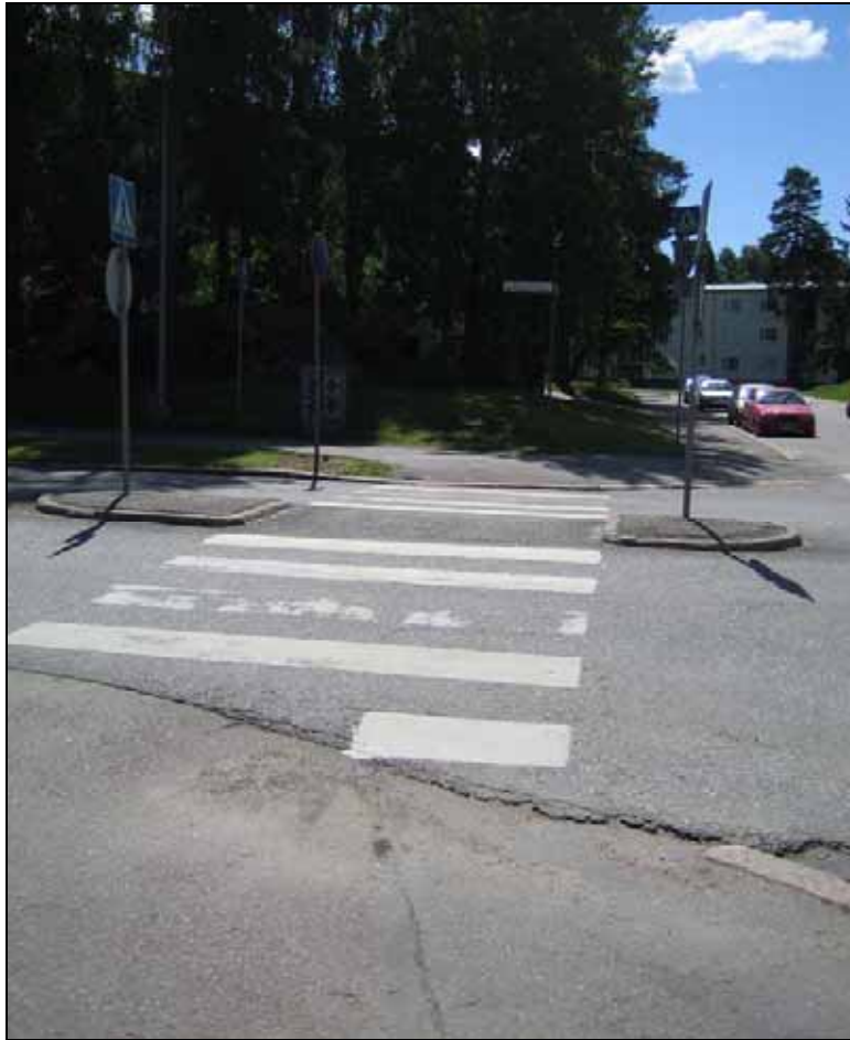
Kuva 8. Mellunmäentiellä on useita suojateitä, joissa ei ole reunatukia. Väylällä on myös useita syvyydeltään alle kaksi metriä suojatiesaarekkeita.
