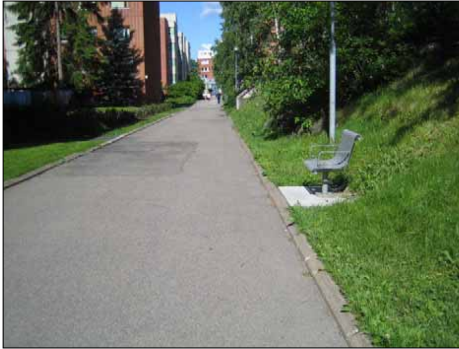
Kuva 10. Mellunmäen alueelle on asennettu uusia, yhden hengen istuimia. Kuvan istuin on sijoitettu reunatuen taakse, jolloin pyörätuolilla ei pääse istuimen lähelle.
