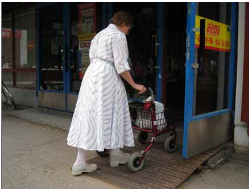
Kuva 23. Ostarin sisäänkäynnit, joissa on korkeita kynnyksiä tai luiskia, tulee parantaa SuRaKu-ohjekortin 4 (julkiset piha-alueet) erikoistason ratkaisun mukaisesti, toimenpidekartan kohta 8.
