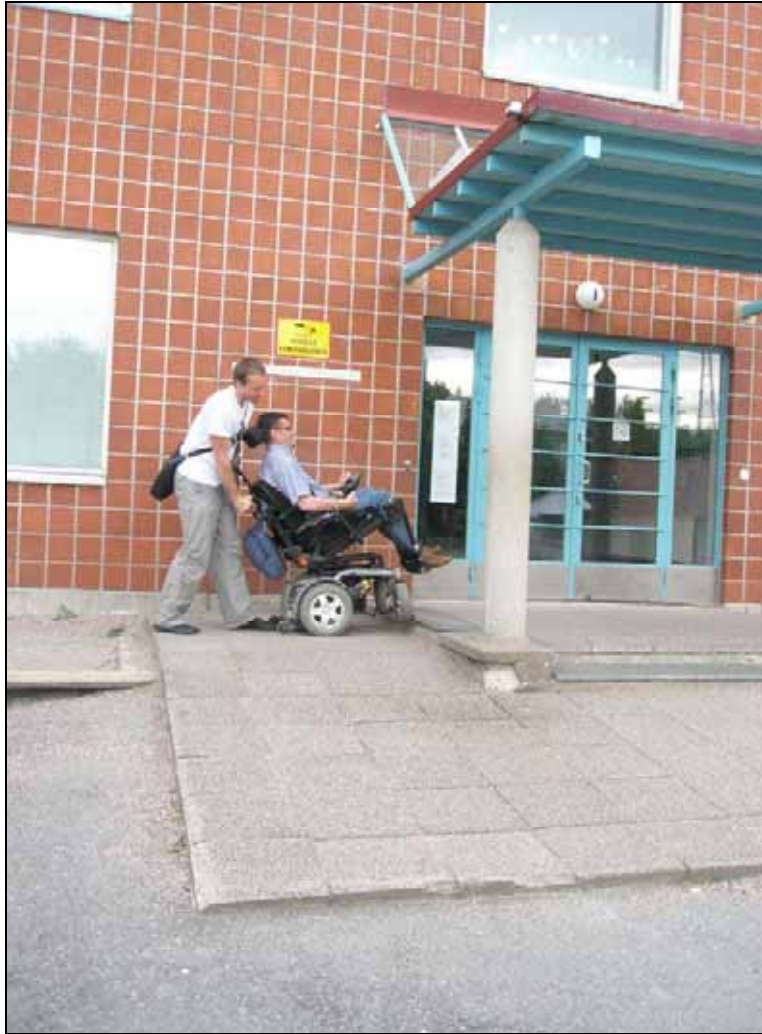
Kuva 13. Korttelitalon toimitilojen sisäänkäynneissä on korkeita kynnyksiä ja epätasaisia luiskia.
