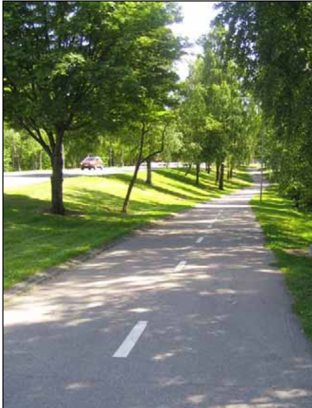
Kuva 19. Asukaspuisto Luoston kohdalta Mellunmäen keskukseen päin johtavalle jyrkälle väyläosuudelle Mellunmäentiestä tulee asentaa toiselle puolelle väylää käsijohde 900 mm korkeudelle, toimenpidekartan kohta 4.
