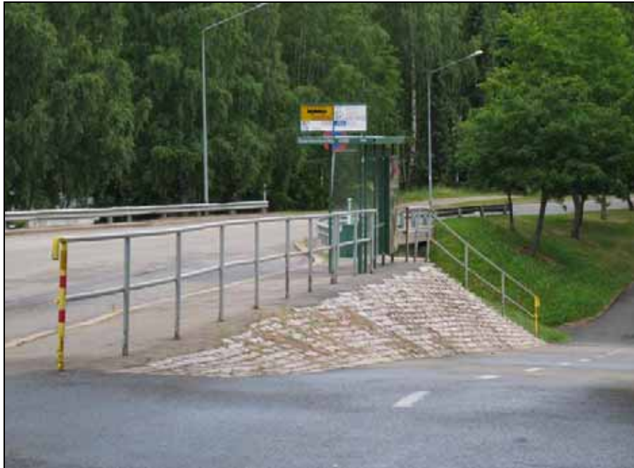
Kuva 25. Mellunmäentien sivukalteva pysäkkialue tulee parantaa Helsingin kaupungin katualueita koskevan tyyppipiirustuksen 29263/9 perustason ratkaisun mukaisesti. Pysäkkialueeseen liittyvä porras tulee parantaa SuRaKu-ohjekortin 3 (tasoterot) perustason ratkaisun mukaisesti, toimenpidekartan kohta 10.
