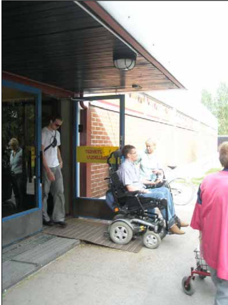
Kuva 12. Mellunmäen ostarin sisäänkäynneissä on korkeita kynnyksiä ja huonoja luiskajärjestelyjä.
