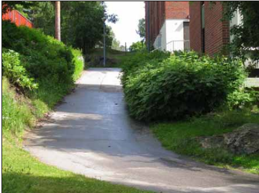
Kuva 18. Kiilopäänpolun jyrkälle väyläosuudelle tulee asentaa toiselle puolelle väylää käsijohde 900 mm korkeudelle, toimenpidekartan kohta 4.
