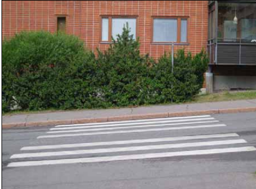
Kuva 22. Saariselänkujan ja Ounasvaarankujan suojatiet, joissa on korkeat reunatuet, tulee rakentaa uudelleen Helsingin kaupungin katualueita koskevan tyyppipiirustuksen 29263/1 perustason ratkaisun mukaisesti, toimenpidekartan kohta 7.
