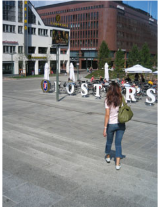
Kuvat 45 - 48. Vähitellen madaltuvat portaat ovat vaarallisia ja ne on vaikea havaita ylätasanteelta ilman varoittavaa aluetta tai reunamerkintää. Näkövammaisten ohjaavia raitoja ei ole jatkettu Narinkkatorilla julkisen liikenteen terminaalien sisäänkäynneille, mutta Puistotorin puolella ne jatkuvat pääsisäänkäynneille
