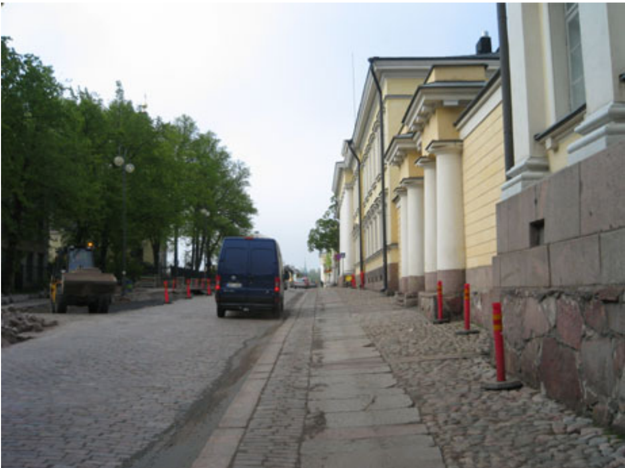
Kuva 35. Unioninkadun suuret korkeuserot ja vanhat luonnonkivipäällysteet tekevät kadun paikoin erittäin vaikeakulkuseksi.
