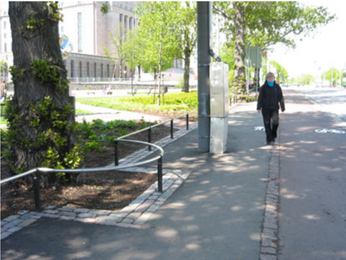
Kuva 27. Jalkakäytävälle tuleva suojakaide on sijoitettu tunnistettavalle varoitusalueelle, mutta keskellä jalkakäytävää olevaa pylvästä ei ole merkitty varoittavalla pintamateriaalilla.
