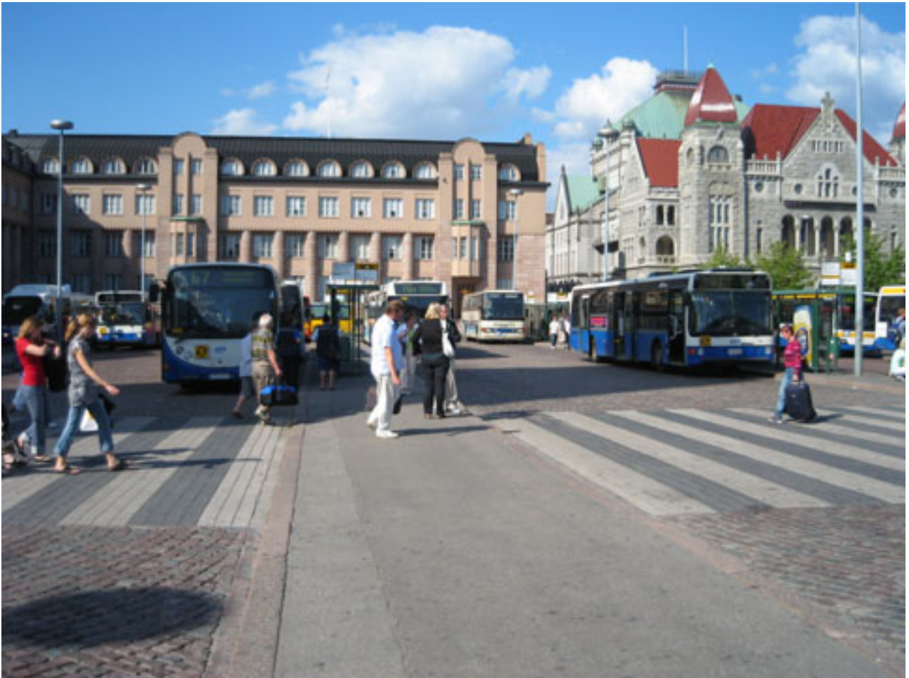
Kuva 40. Rautatientorin terminaalialueelle johtavalla suojatiellä laiturikorokkeiden reunatuet ovat liian korkeita ja ilman viisteitä.
