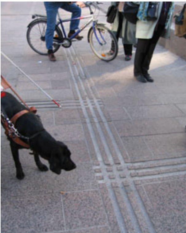
Kuvat 17-18. Ohjausraitojen epälooginen sijoitus ja ohjauksen puute toiminnallisesti merkittäviin kohteisiin, kuten terminaalien sisäänkäynneille sekä varoittavien alueiden vaikea tunnistettavuus estävät opasraitojen tehokkaan käytön Kampissa.
