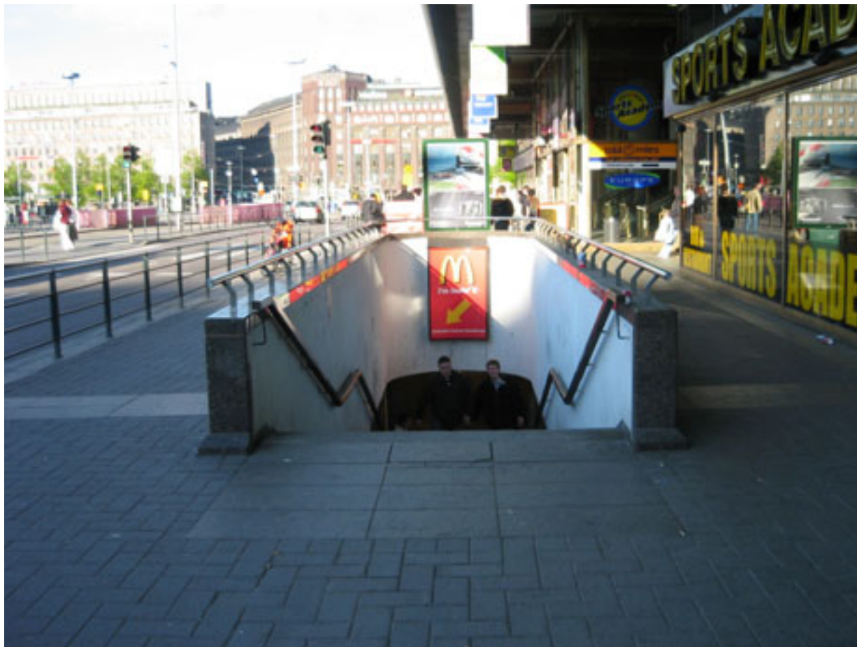
Kuva 32. Kaivokadun jalankulkutunneleiden sisäänkäynnit sijoittuvat keskelle jalkakäytävää aiheuttaen törmäys- ja putoamisvaaraa. Portaiden yläpäästä puuttuvat varoittavat materiaalit.
