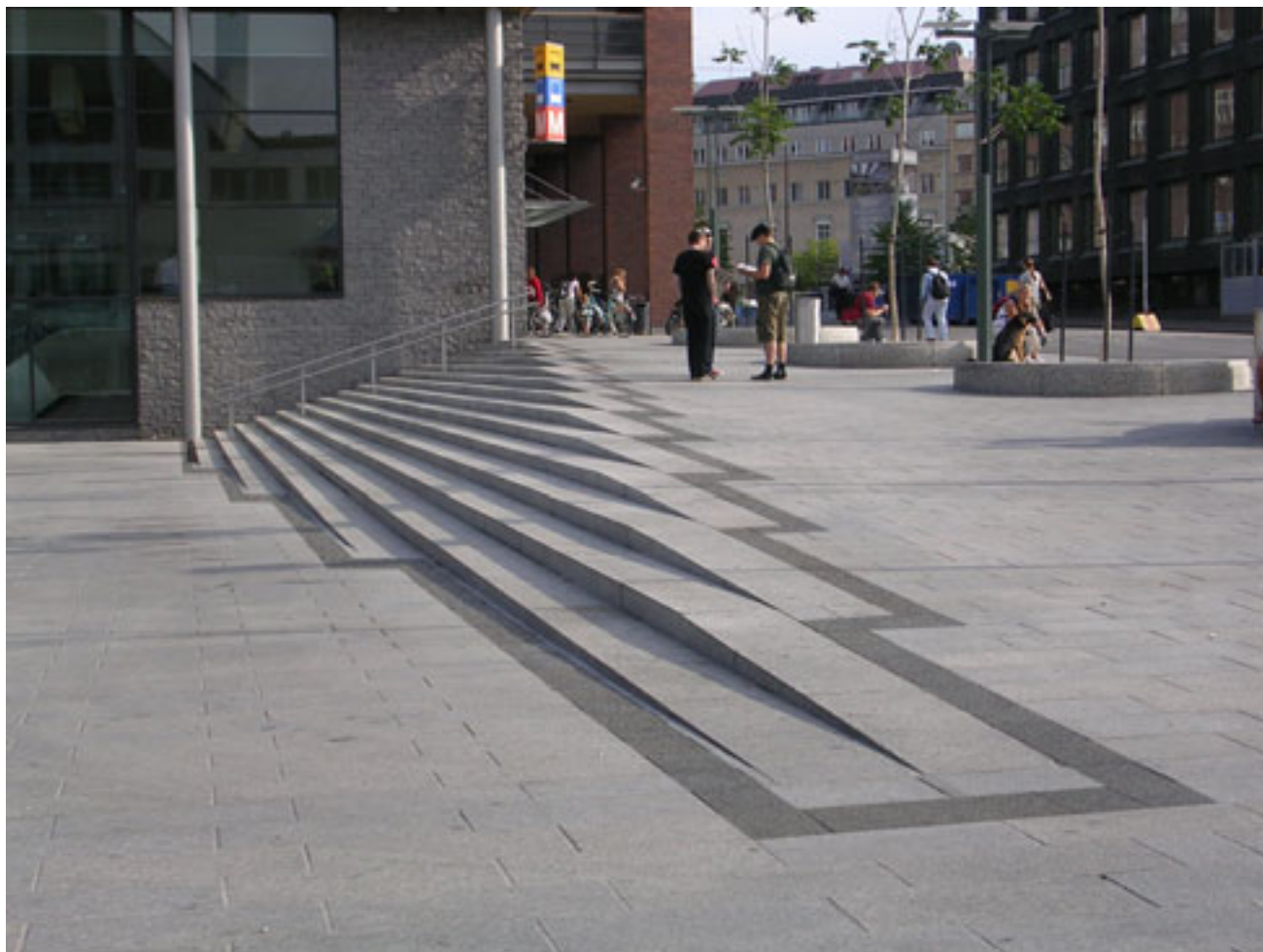
Kuva 57. Kuvasovitukseen on lisätty varoittava kontrastiraita vaikeasti hahmotettavien ja vaarallisten portaiden ympäristöille niiden havaittavuuden parantamiseksi. Myös käsijohteet helpottaisivat portaidenhavaittavuutta.
