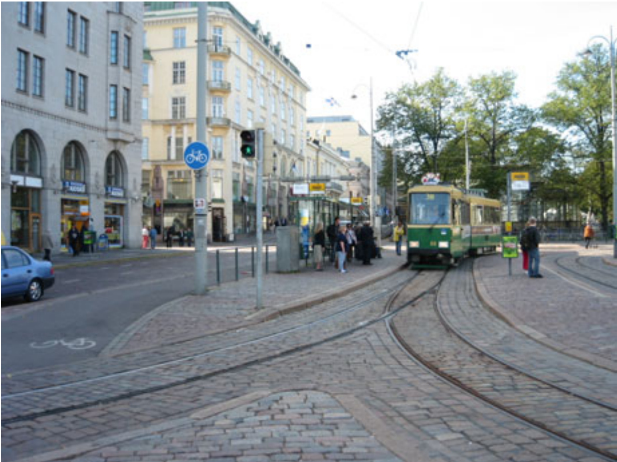
Kuva 38. Raitiotiekisko- ja pyörätiejärjestelyt vaikeuttavat raitiotiepysäkillä pääsyä ja suojateiden hahmottamista. Vanhat luonnonkiveykset ovat epämiellyttäviä erityisesti pyörätuolin käyttäjälle.
