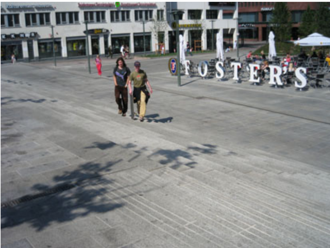
Kuva 51. Ilman reunamerkintää olevat portaat näkyvät huonosti etenkin, jos niissä on lämmitysurat, jotka vaikeuttavat entisestään portaiden reunan havaitsemista.
