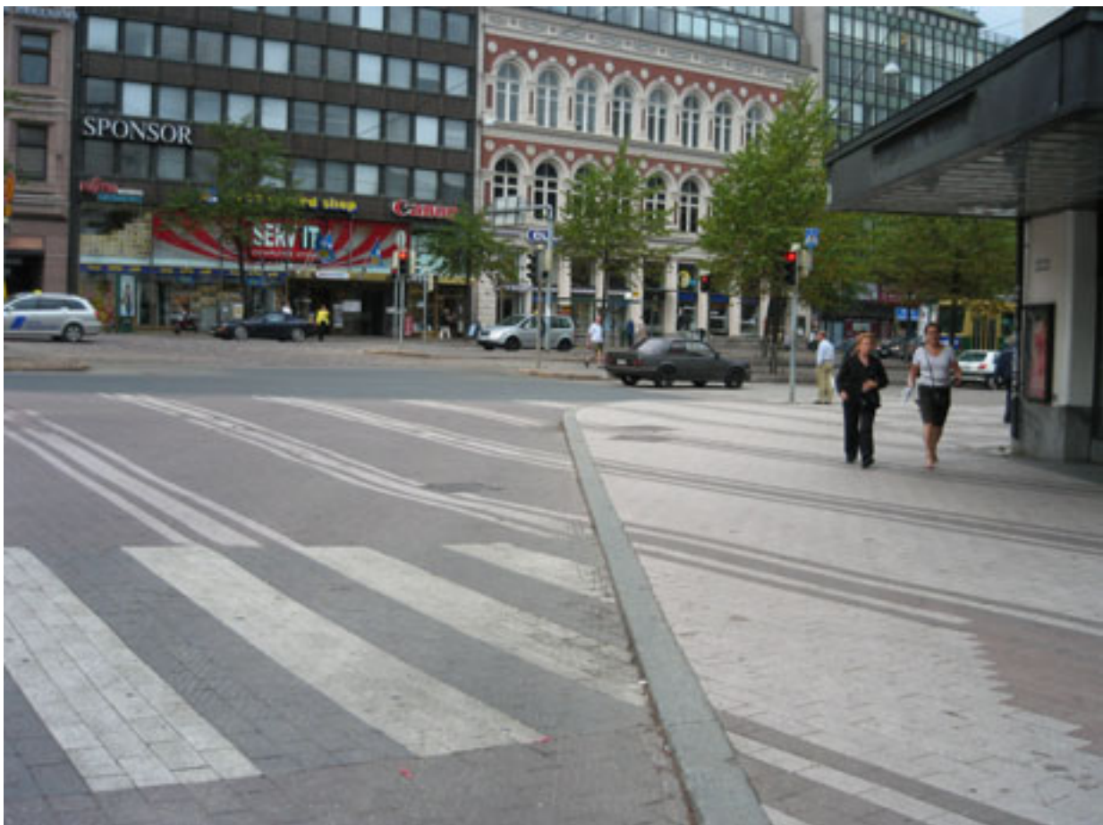
Kuva 43. Betonikiveyksen voimakas kuviointi vaikeuttaa suojatien hahmottamista Erottajanaukiolla.
