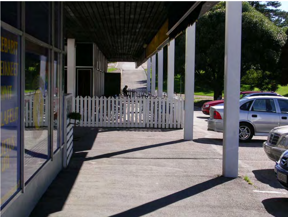
Kuva 23. Pohjois-Vuosaaren ostoskeskuksen kuoppainen piha-alue on erittäin vaarallinen. Aluetta tulisi kehittää kokonaisvaltaisesti toimintojen jäsennöinnin, pinnoitteiden, varusteiden, kalusteiden, valaistuksen ja istutusten osalta.
