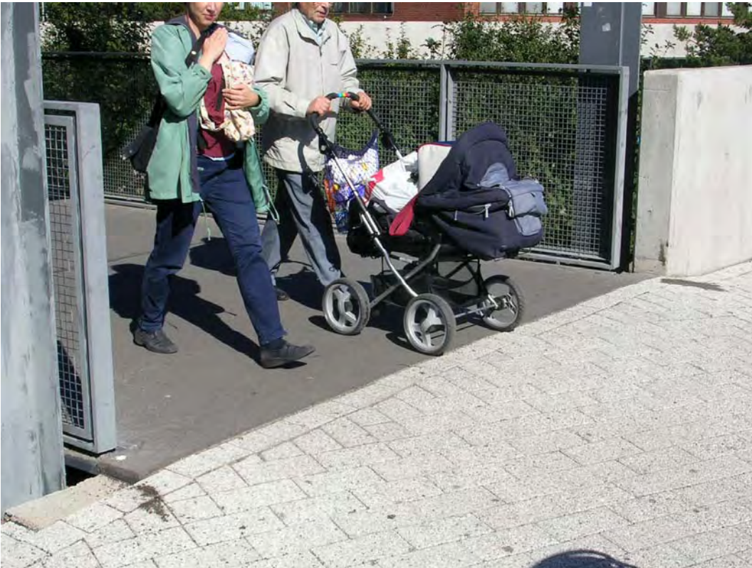
Kuva 25. Vuotalon edustan aiemmin liukas puukansi on turvallinen uuden päällysteen ansiosta.
