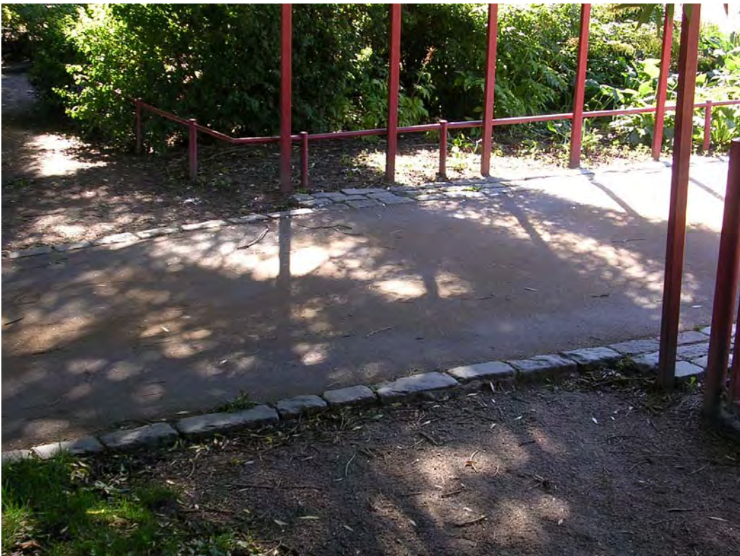
Kuva 8. Ilveskorvenpuiston alueella liikumista haittaavat kynnyksen muodostavat nupukiviraidat sorakäytävien liittymäkohdissa.
