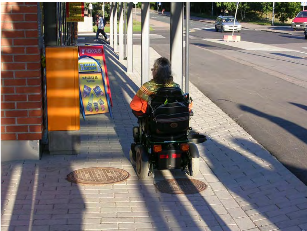
Kuva 11. Vuosaarentien varteen rakennetun uuden liikerakennuksen edustan ja jalkakäytävän välinen kalteva vyöhyke pakottaa pyörätuolinkäyttäjän kiertämään. Mainostelineet estävät katosalueen läpikulun.
