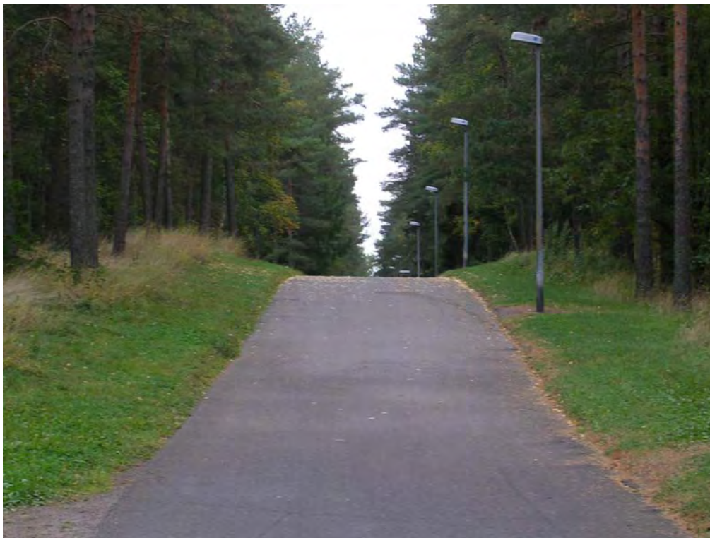
Kuva 24. Urheilukentän pohjoispään kohdalla olevan jyrkän väyläosuuden kohdalle tulisi asentaa käsijohteet.
