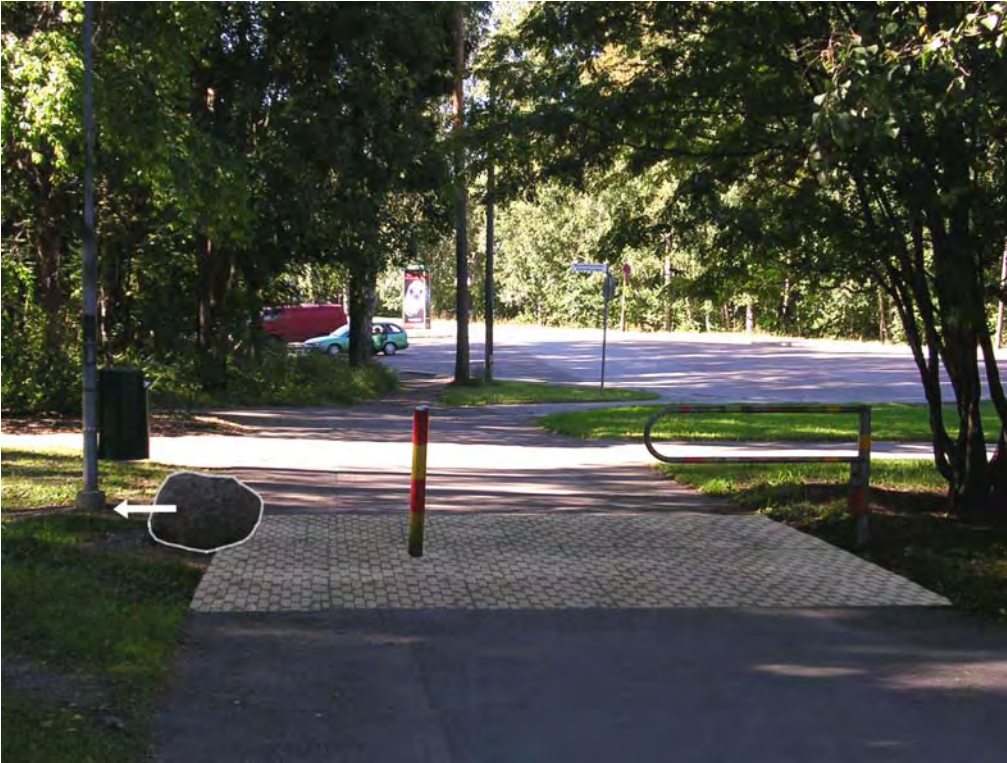
Kuva 22. Isonvillasaarentien päästä Pohjois-Vuosaaren ostoskeskukselle johtavalla väylällä on puomi, pollari ja kivenlohkare väylällä. Valokuvasoitteessa on esitetty näkövammaista em. koh- teista varoittava vyöhyke esim. vaaleista lohkopintaisista graniittisista noppakivistä rakennettuna.
