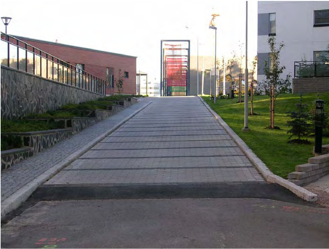
Kuva 27. Rajapaadenraitin pitkään jyrkkään nousuun tulee asentaa käsijohteet. Heikkonäköinen voi tulkita kulkupinnan raidoituksen porrasaskelmasta aiheutuvaksi varjoksi.
