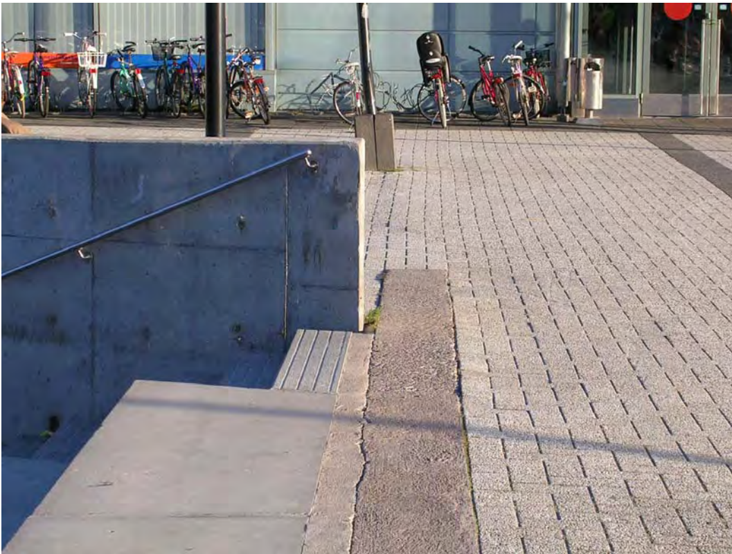
Kuva 28. Mosaiikkitorin uusi betoninen porrasrakenne ei erotu vaaleasta toripinnasta. Käsijohteen jatkamisen lisäksi tulisi porrasalueen reuna merkitä tummanharmaalla massalla tai betonikivillä.
