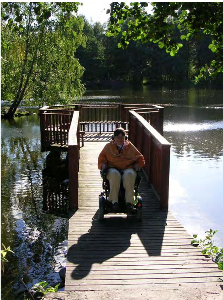
Kuva 7. Kangaslammen oleskelulaiturit ovat hyviä kaikille käyttäjille. Kysymyksiä herätti kuitenkin se, ettei suojakaidetta ollut koko laiturin pituudella.
