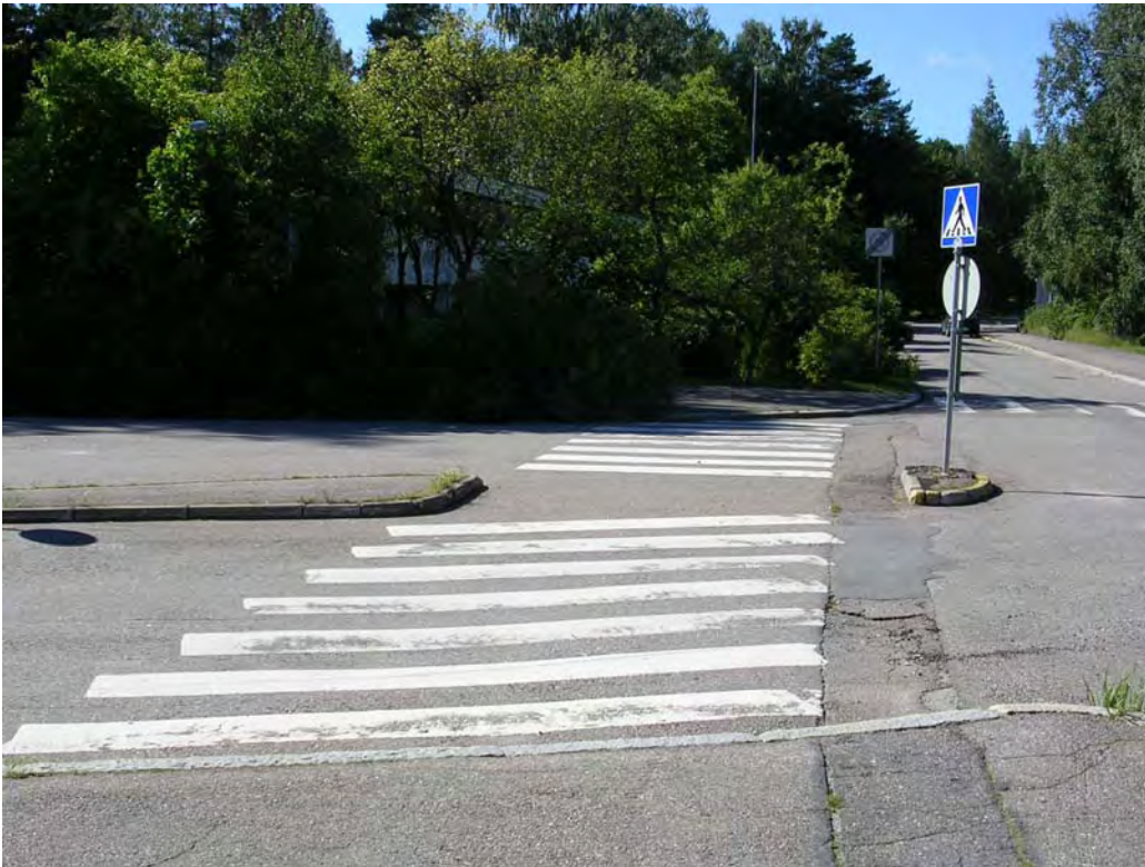
Kuva 19. Suojateiden reunakivet tulee kartoittaa ja ensimmäisinä tulee parantaa liian korkeat reunakivet. Kuvassa urheilukentän pysäköintialueen kohta, jossa myös keskisaarekkeen havaittavuutta tulee parantaa matalalla reunakivellä ja kontrastivärillä.
