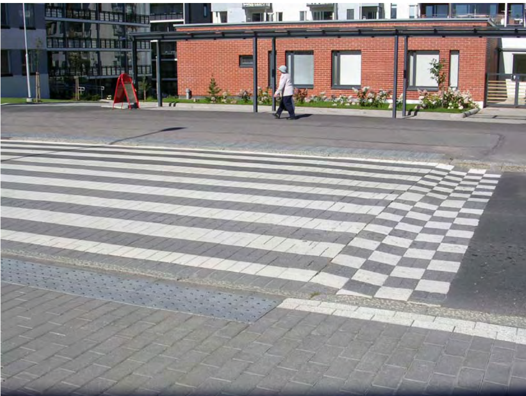
Kuva 26. Vuosaarentien korotettuihin suojateihin on asennettu kohokuvioiset varoitusvyöhykkeet auttamaan näkövammaista tunnistamaan ajoradan reuna.
