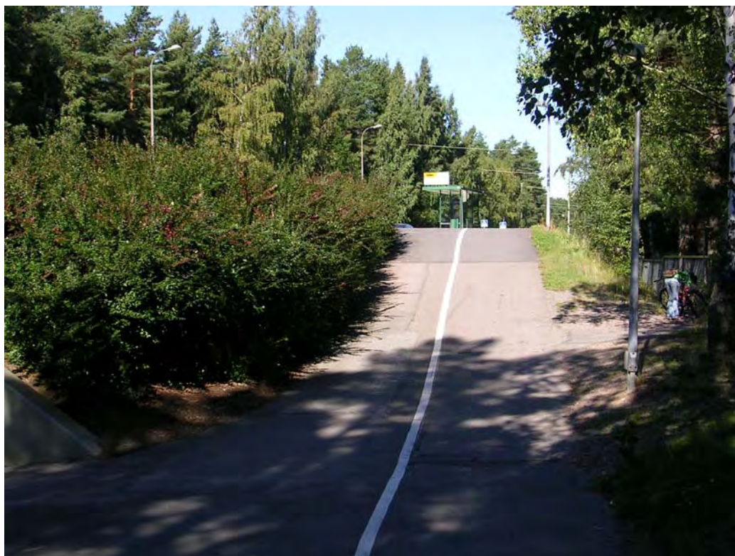
Kuva 21. Kallvikintien alikulusta Merikorttintien kohdalla on jyrkkä nousu pysäkillä. Jalankulkuväylän reunaan tulisi asentaa käsijohde.
