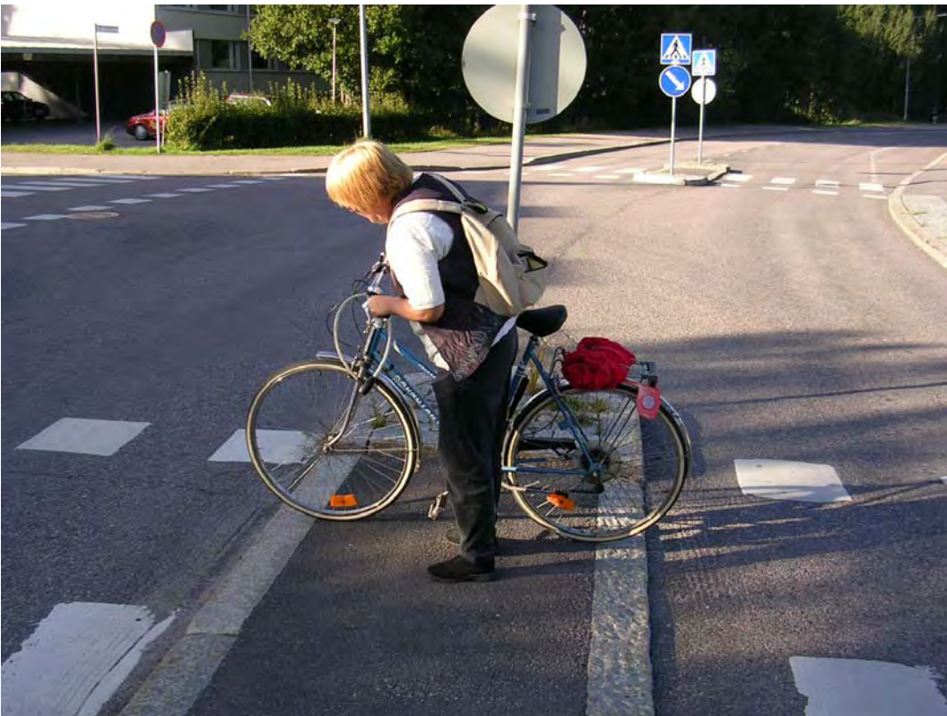
Kuva 10. Porslahdentien suojateillä on monenlaisia ongelmia; reunakivet ovat liian korkeita, keskisaarekkeet liian kapeita ja kaltevuudet liian suuria.
