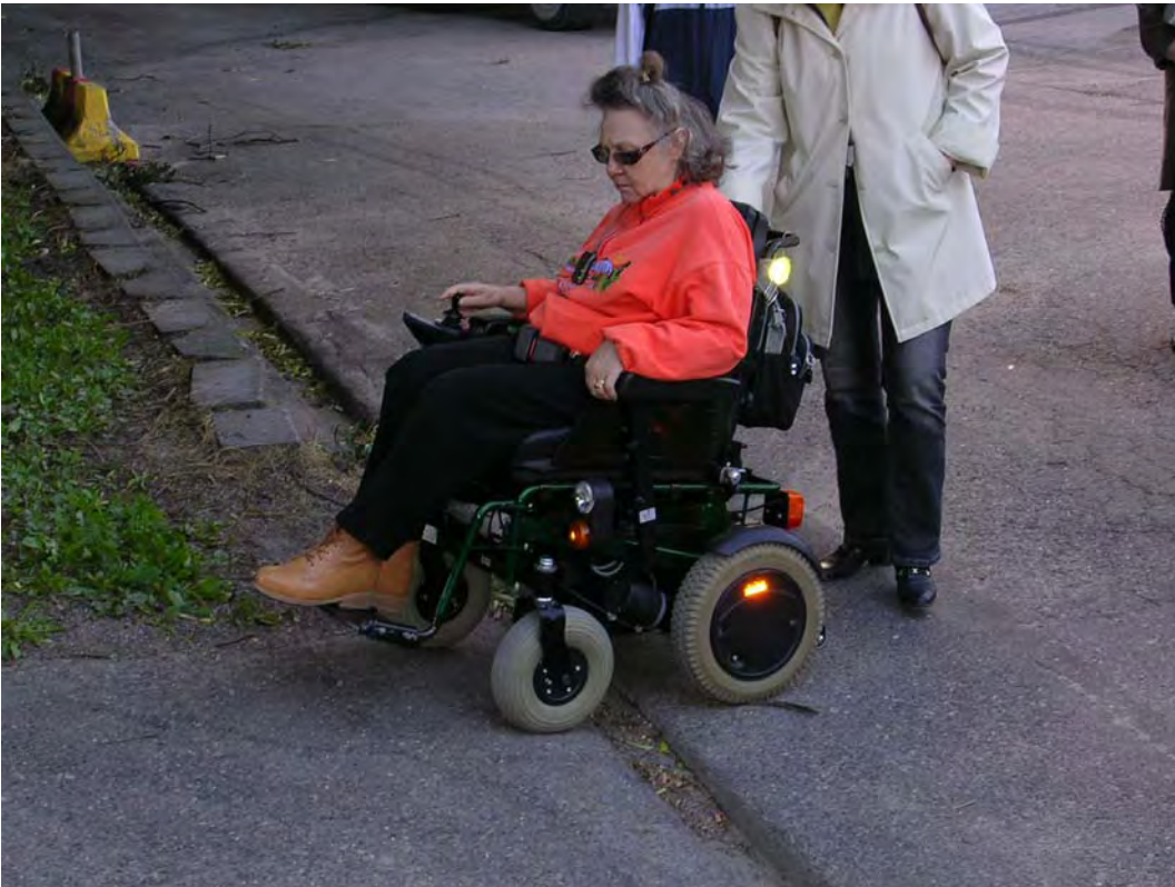
Kuva 9. Vuosaaren pohjoisen ostoskeskuksen pysäköintialueen asfaltti on vaarallisen epätasainen. Etelän suunnasta (Kivisaarenpolku) saavuttaessa joudutaan ylittämään syvä ja jyrkkäreunainen sadevesikouru, johon pienipyöräinen pyörätuoli tai rollaattori voi juuttua.
