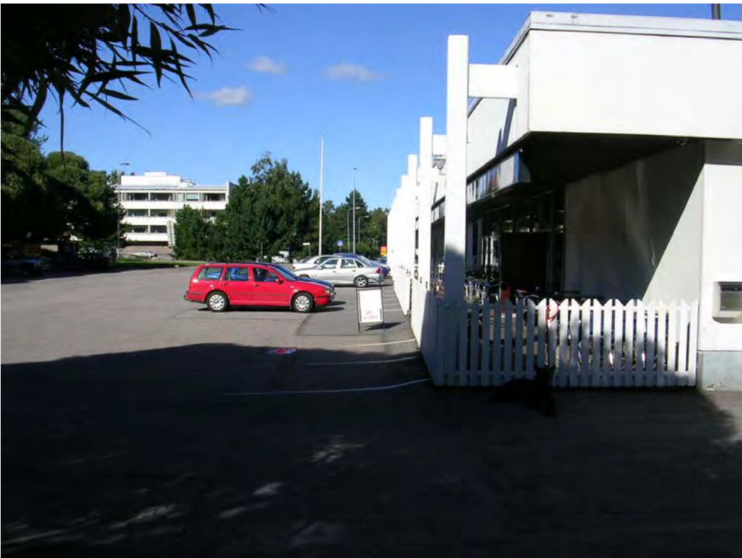
Kuva 13. Pohjois-Vuosaaren ostoskeskuksen piha-alue on pahoin painunut ja vaarallisen epätasainen. Aidattu terassi pakottaa jalankulkijat autojen joukkoon.
