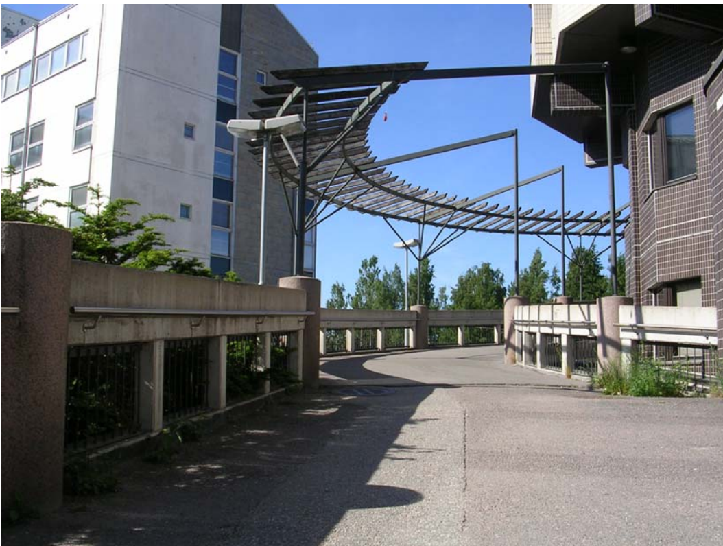
Kuva 9. Sitratorilta nousee aseman ylikululle pitkä, jyrkkä luiska. Käsijohde katkeaa kannatinpylväiden kohdilla.
