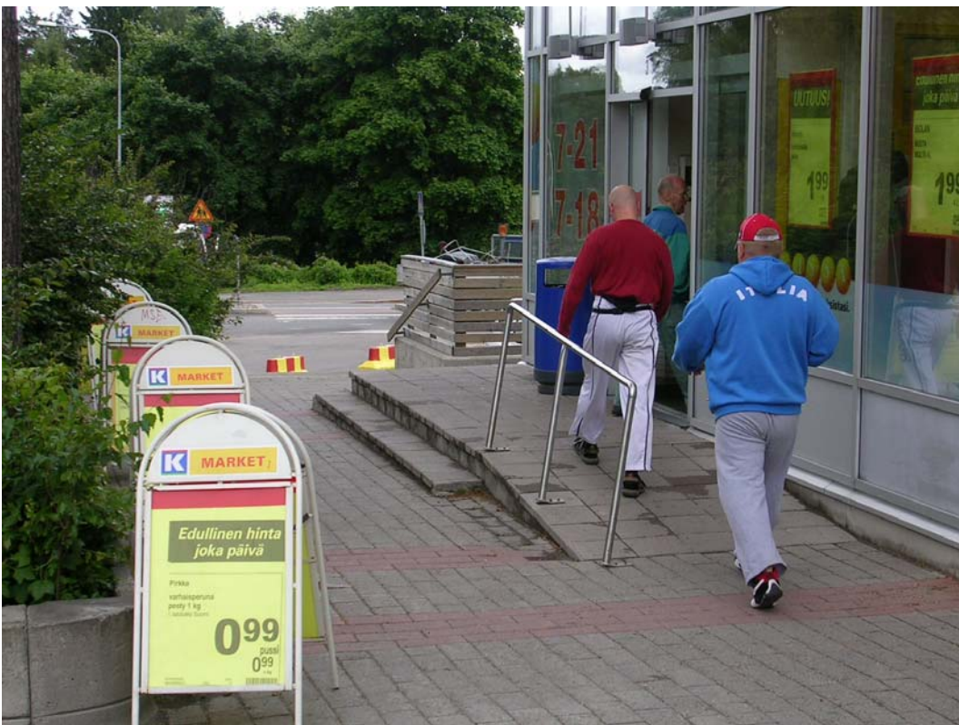
Kuva 15. Oikein mitoitettu sisäänkäyntialueen luiskajärjestely.
