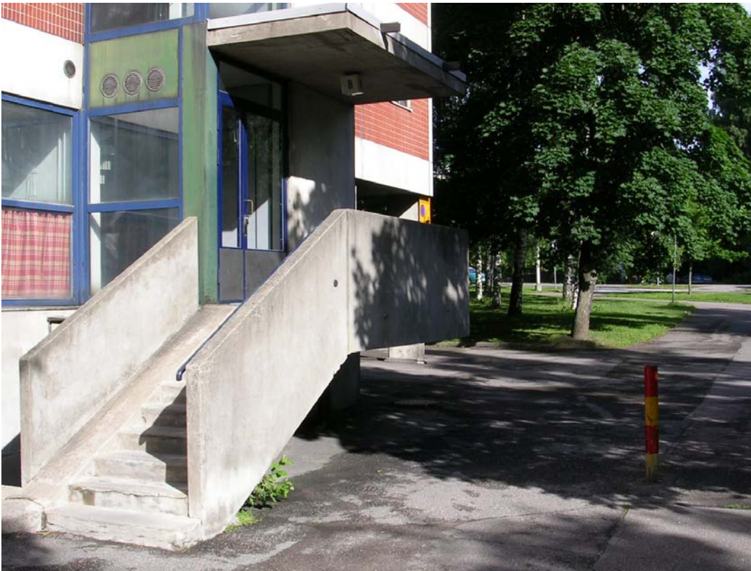
Kuva 17. Halsuantiellä asuintalojen sisäänkäyntien betonirakenteisiin voi heikkonäköinen törmätä.
