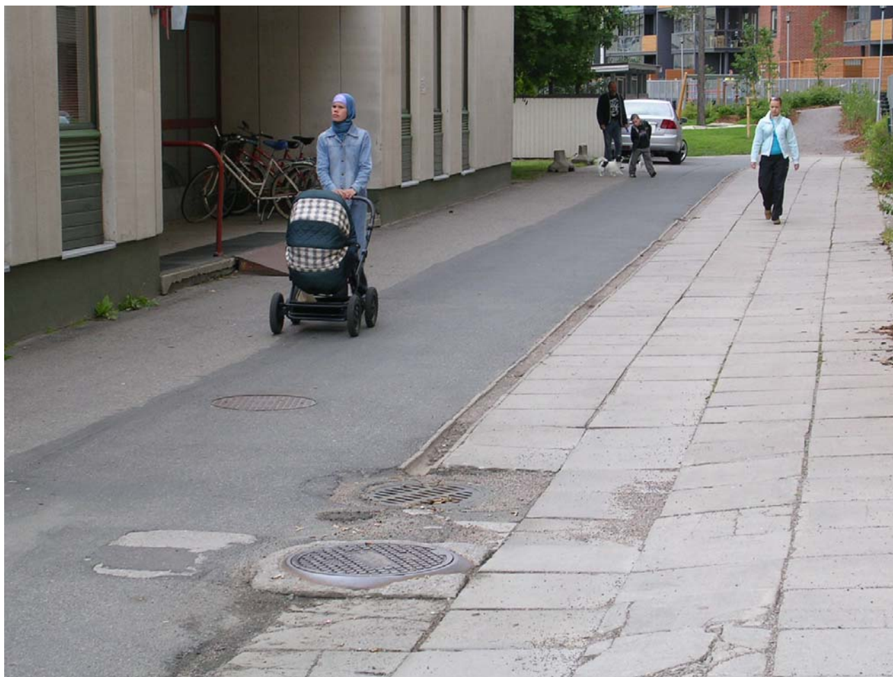
Kuva 30. Kaustisenpolun parantaminen terveysaseman kohdalla on tärkein esteettömyyden kehittämistoimenpide. Tasauksen nostaminen, uusi päällyste ja jyrkkäreunaisen kuivatuskourun poistaminen ovat alustavasti ehdotettavia toimenpiteitä.
