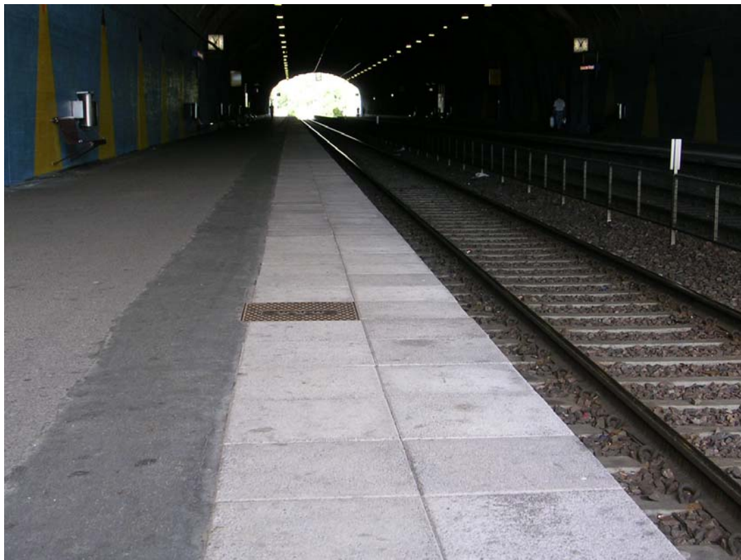
Kuva 25. Malminkartanon aseman suurin esteettömyysongelma on hämäryys. Laiturin reunassa on leveä vaalea varoitusalue, mutta tuntoaistiin perustuva varoitusraita puuttuu.
