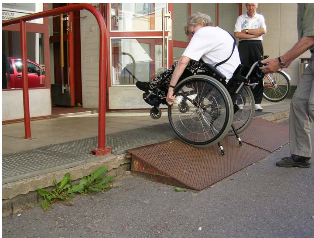
Kuva 11. Terveysaseman sisääntulon luiska on liian jyrkkä eikä täytä muutenkaan esteettömyyden vaatimuksia. Ensisijaisena parannustoimenpiteenä Kaustisenpolun tasauksen nostaminen.
