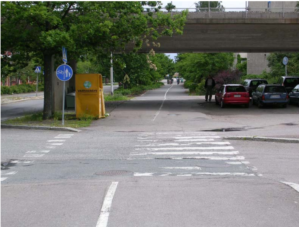
Kuva 12. Sitratien ja aseman pysäköintialueen liittymän hahmottaminen on vaikeaa heikkonäköiselle. Uusi suojatiemaalaus, asianmukaiset reunakivet ja ajoväylien yhdistäminen jalkakäytävän kohdalla ovat tärkeimmät tarvittavat toimenpiteet.
