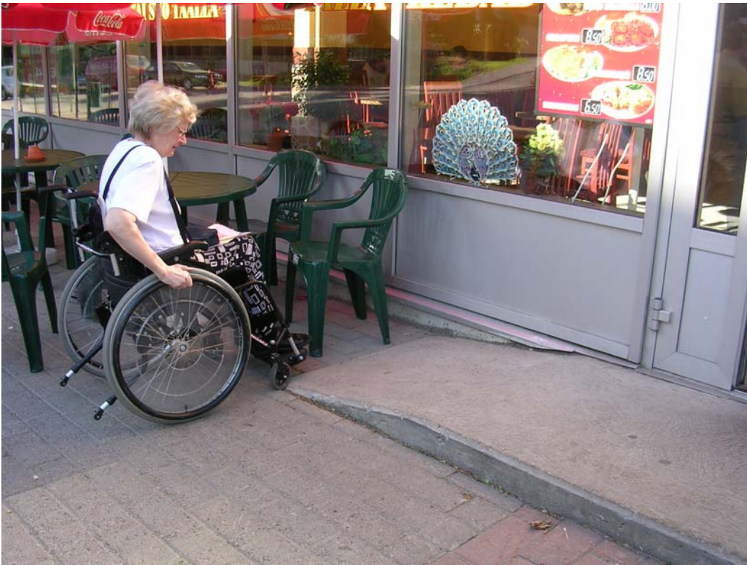
Kuva 14. Kalusteet estävät luiskan käytön. Luiskan oven edustan tasanne on myös liian pieni sähköpyörätuolin kääntämiseen.
