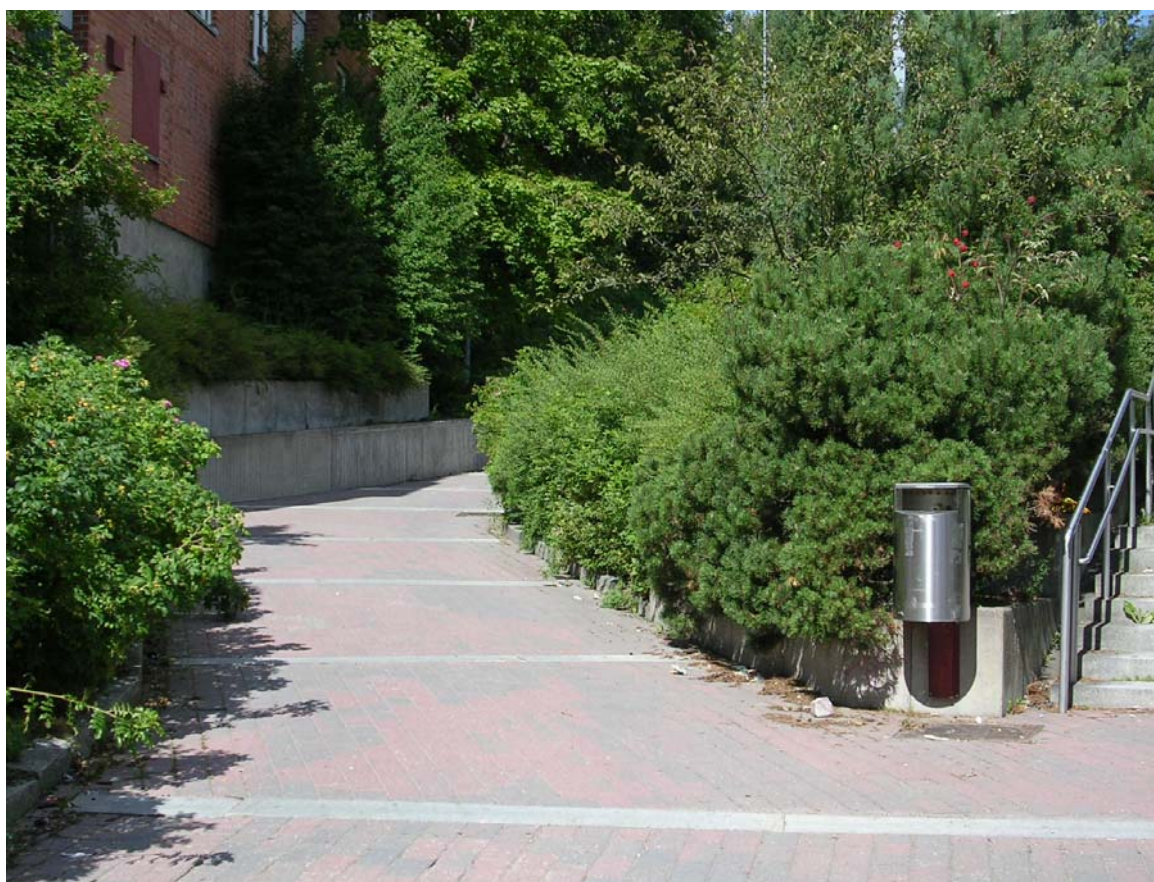
Kuva 32. Kaikkiin asemalle nouseviin jyrkkiin luiskiin tulisi lisätä molemmin puolin käsijohteet kahdelle korkeudelle.
