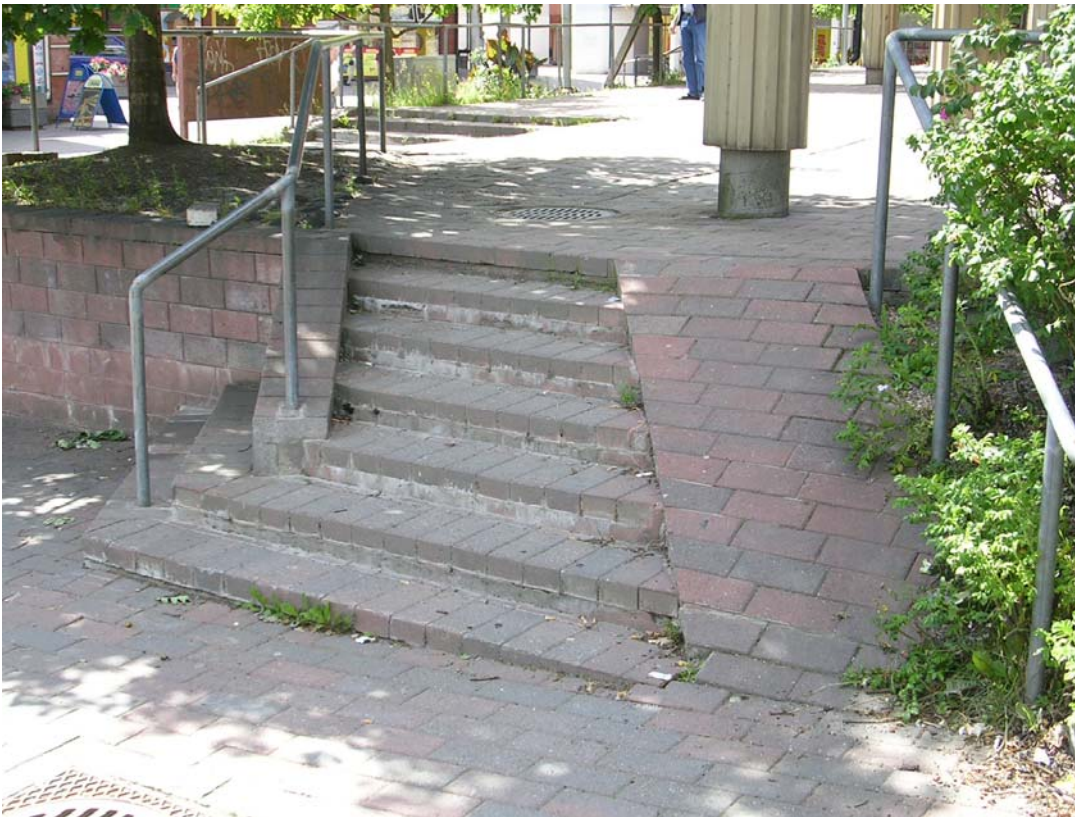
Kuva 22. Malminkartanon aukion liikkeiden edustalta asemalle johtava porras luiskineen on erikoisen muotoilunsa vuoksi vaikeasti hahmotettava ja vaarallinen heikkonäköiselle liikkujalle.
