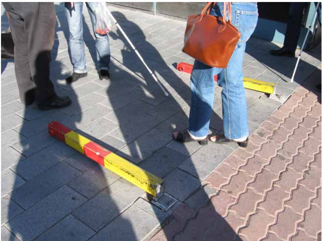
Kuva 23. Kaadetut pollarit aiheuttavat kompastumisvaaraa jalankulkualueilla. Varoittavat materiaalit puuttuvat.
