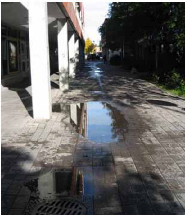
Kuva 26. Lyypekinkujalla on pahoja painumia ja rikkoutuneita päällysteitä etenkin jalankulkuarkadissa tontin puolella.
