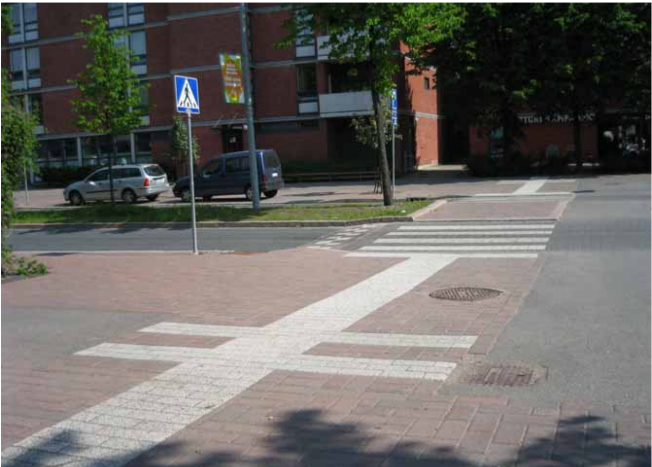
Kuva 11. Kauppakartanonkadun suojateille johtaa jalkakäytävän ja pyörätien poikki varoittava raita, joka toimii ohjauksena suojatielle ja varoittaa kadun pyöräilijöitä suojatiestä.
