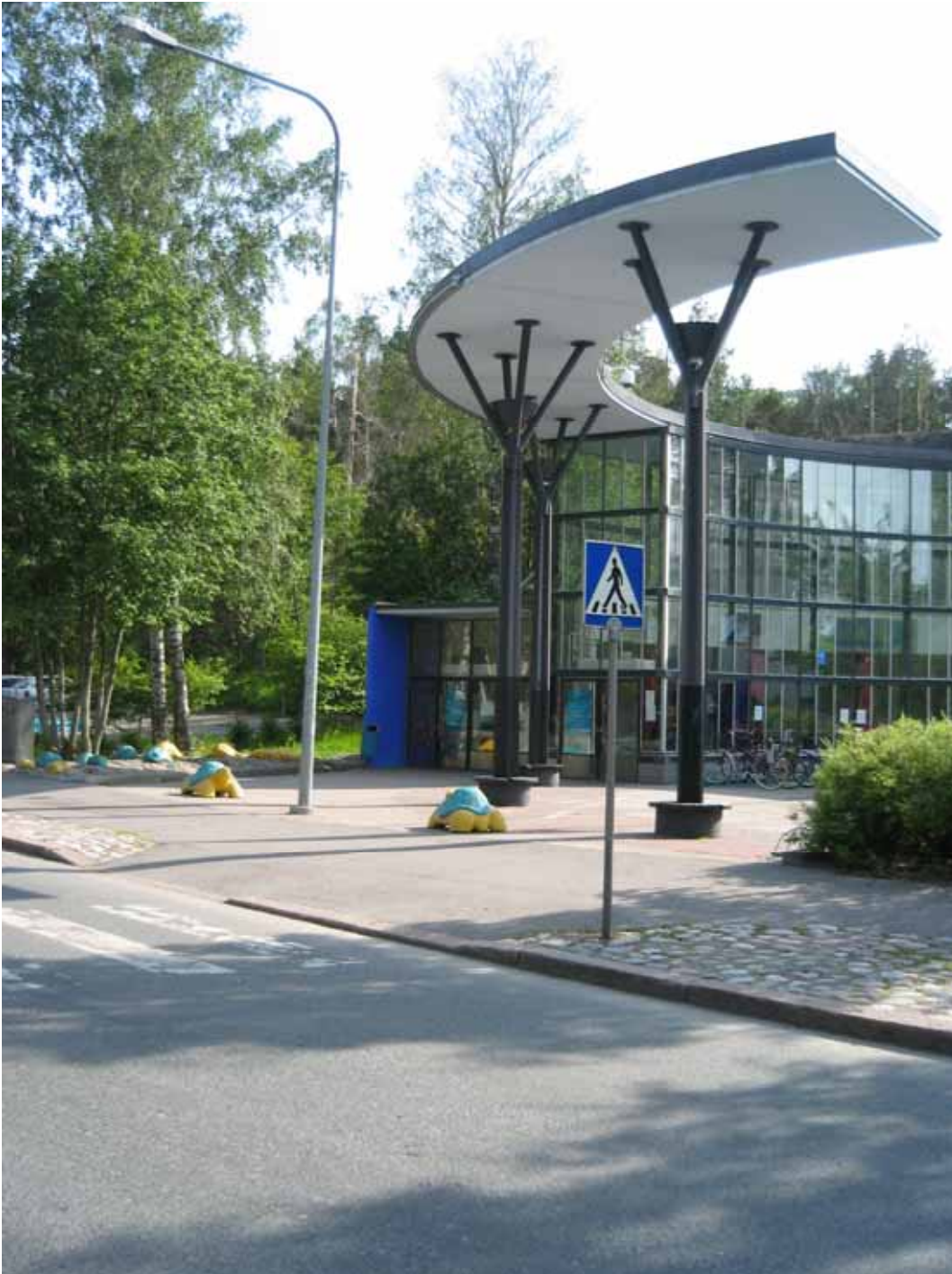
Kuva 18. Itäkeskuksen uimahallille johtavan suojatin reunatuet on madallettu, mutta piha-alueella on monia näkövammaisten kulkua haittaavia esteitä.
