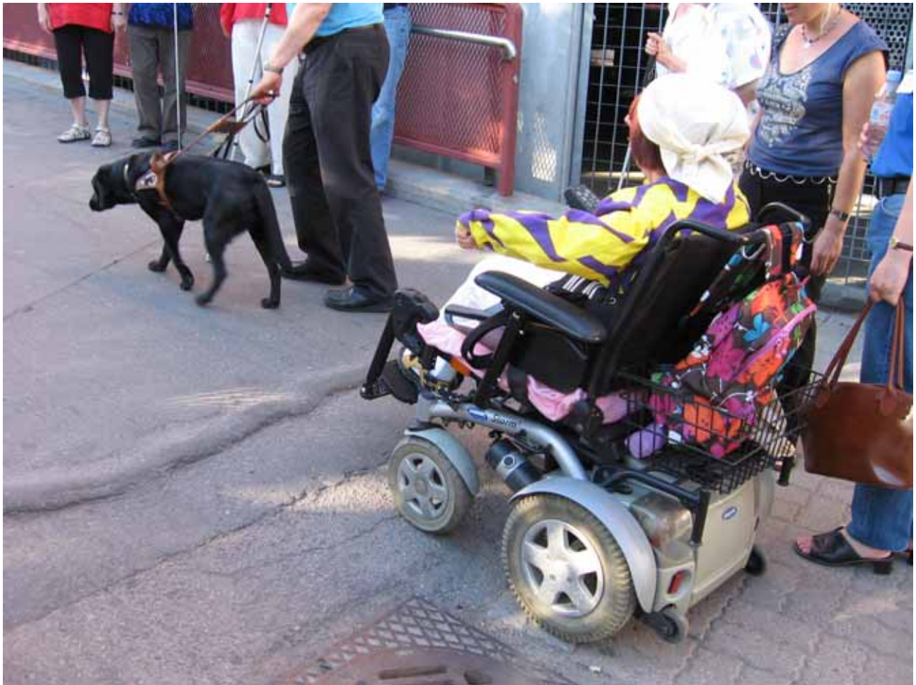
Kuva 9. Asiakkaankadun sillan luiskassa päällyste on valunut valliksi, joka on vaikea ylittää pyörätuolilla.
