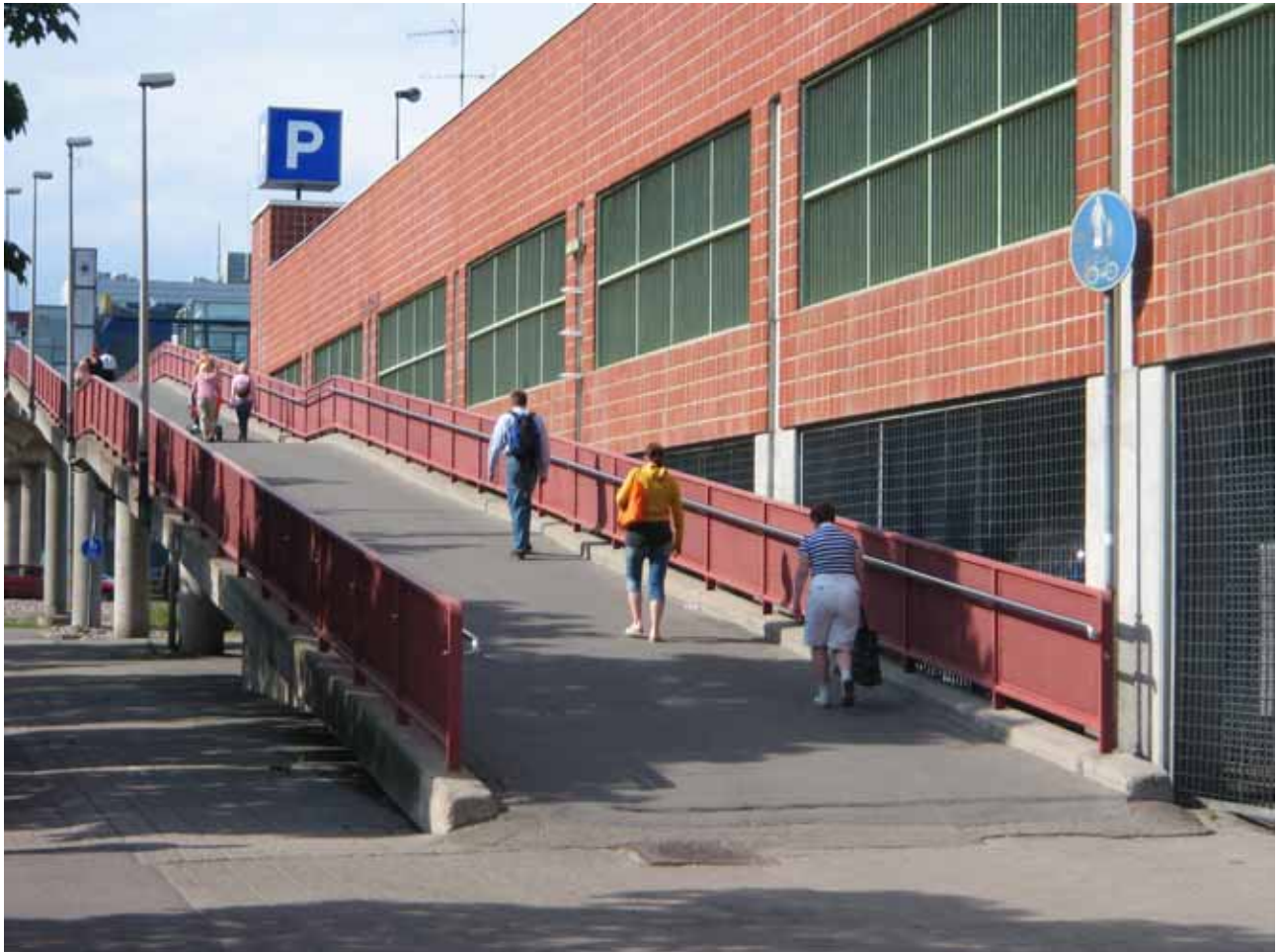
Kuva 14. Asiakkaankadun sillan luiska on jyrkkä ja matka välitasanteelle on liian pitkä. Liikuntasaumoissa on pyörätuolilla vaikeasti ylitettäviä epätasaisuuksia.
