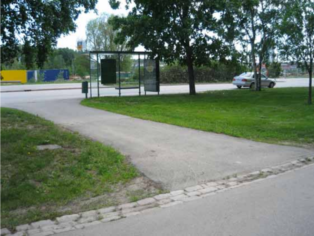
Kuva 20. Sadevesikouru katkaisee kulkuyhteyden pysäkillle Vanhanlinnantielle.
