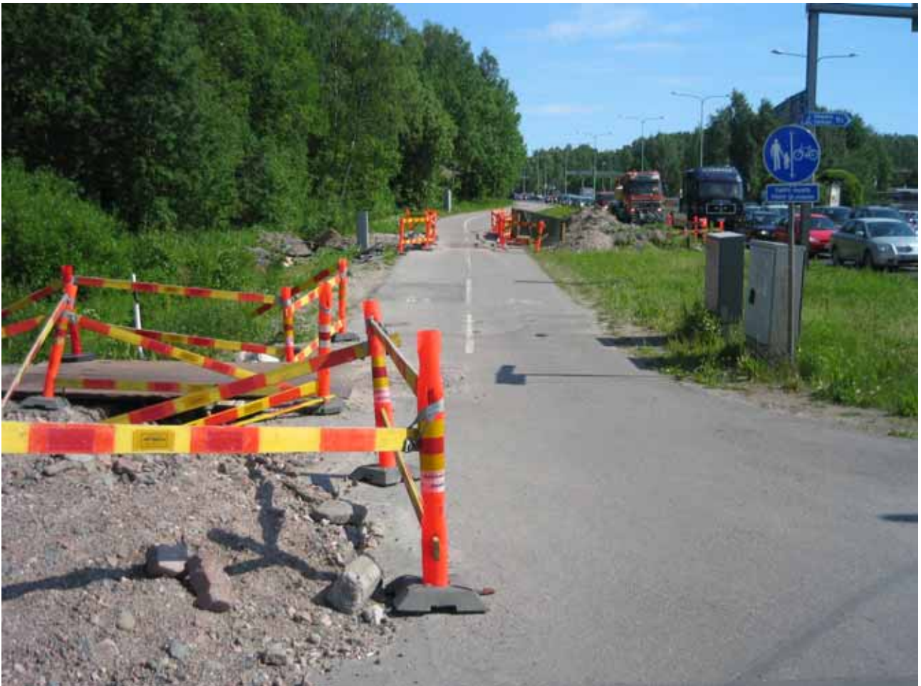
Kuva 22. Meripellontiellä kulkua vaikeuttavat työmaat. Itäväylän risteys tulee muuttumaan lähivuosina eritasoliittymäksi.
