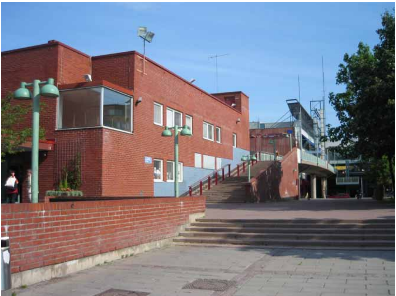
Kuva 27. Tallinnanaukiolta Stoan aukiolle johtava silta päättyy portaisiin, mutta korvaava esteetön hissiyhteys löytyy rakennuksesta portaiden sivusta. Portaiden yhteydessä on lastenvaunuluiska, joka on erittäin jyrkkä.
