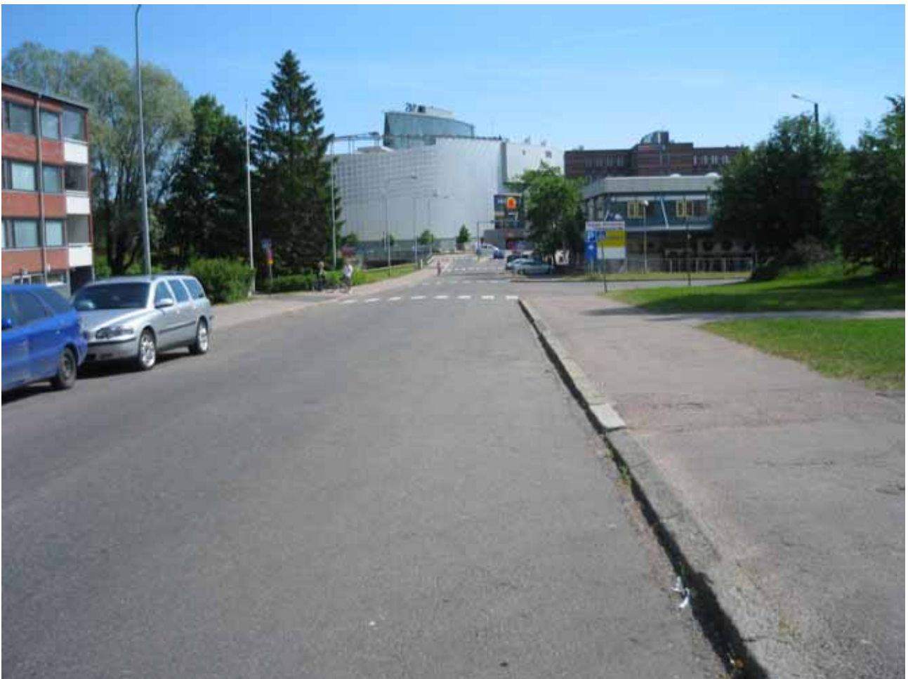
Kuva 19. Korsholmantiellä suojatien reunatuet on madallettu, mutta ne eivät vastaa nykyisiä tyyppiirustuksia.
