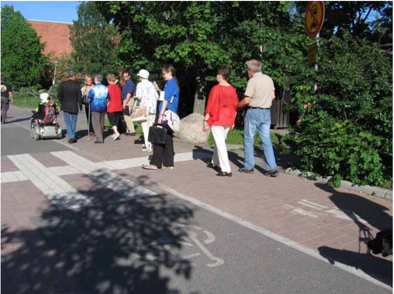
Kuva 8. Kauppakartanontien suojateiden ohjaavat ja varoittavat alueet todettiin liikkumista helpottaviksi, vaikka niiden vaikutus perustuu kontrastiin ja tuntuvaikutus on heikko.
