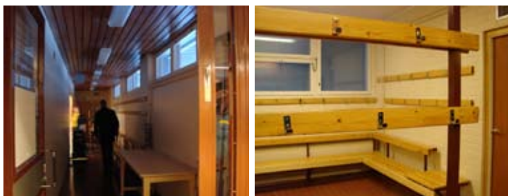
Nykyinen Paloheinän ulkoilumaja - käytävä ja pukuhuonetiloja
