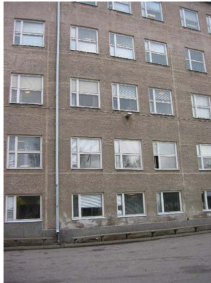
Luokkahuoneiden ikkunat aukeavat etelään pihalle
