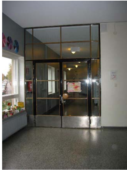
Säilytettävät, palo-oviksi kunnostettavat teräslasiovet
