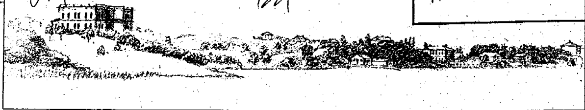
Hesperian puiston aluetta noin 1850. Vasemmalla vapaaherra Carl Johan Walleenin rakennuttama Hakasalmen huvila. Kuvassa näkyy, miten karua alue oli, kun Walleen ryhtyi rakentamaan puistoaan. Oikealla näkyy Töölön ravintola. Samaan aikaan, kun Hakasalmen huvilan puistoa rakennettiin, tekivät Töölön ravintolan omistajat istuksia ravintolansa ympäristössä. Lyijykynäpiirustus (Helsingin kaupunginmuseo).
