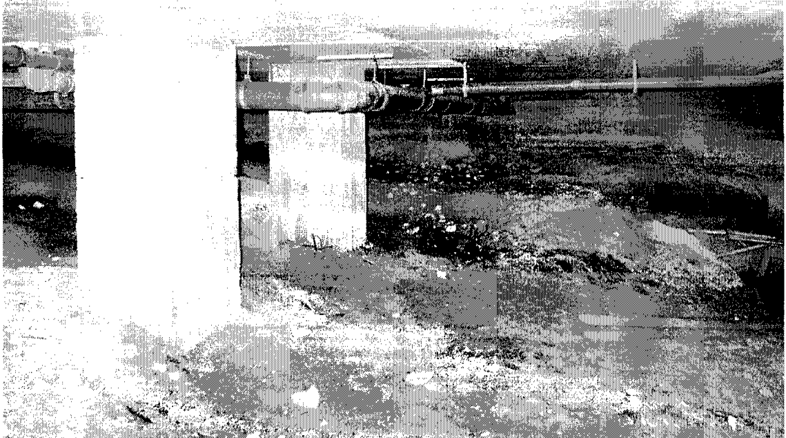
kuva 3. Alustilassa sijaitsevat pilarit.
