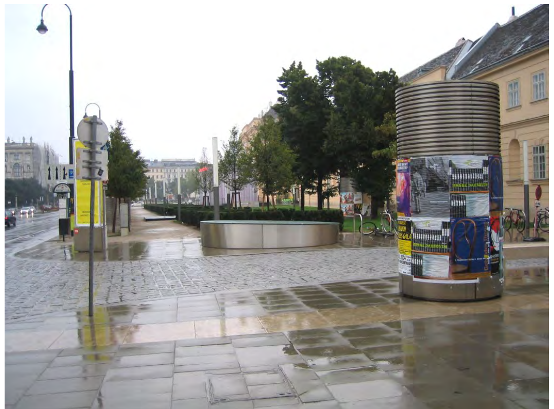
Pysäköintilaitosten ilmanvaihtohormeja on käytetty kulttuurimainontaan. Wien. Kuva Marjatta Uusitalo
