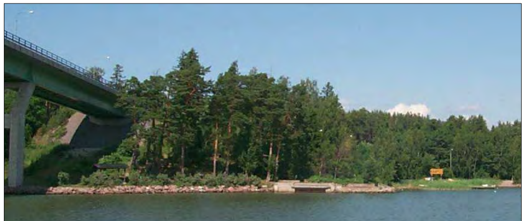
Kuva 16. Emäsalon sillan mantereenpuoleinen maapenger.
