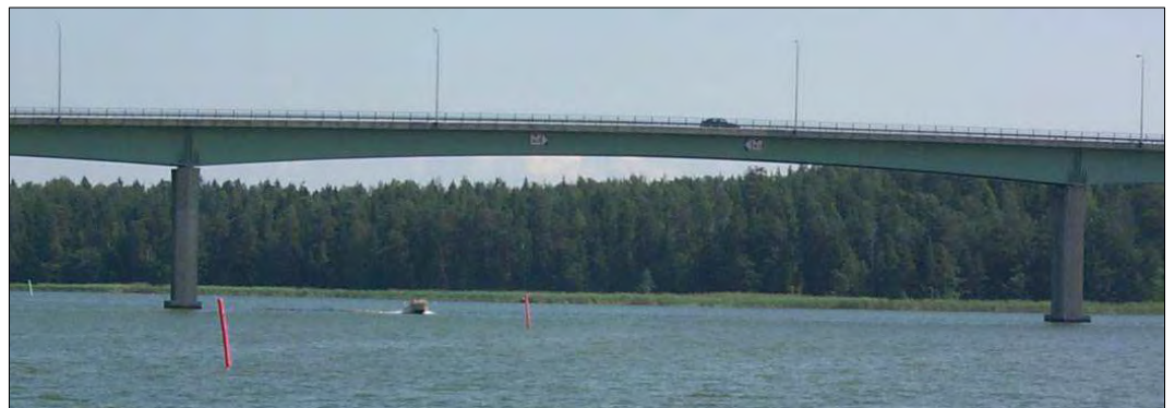
Kuva 15. Emäsaloon johtava vesistö silta Porvoossa.
