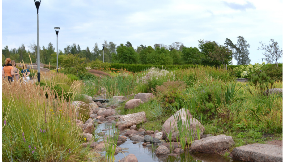
Kuva 37. Hulevesien hallintaa Kotkan Katarinanpuistossa
