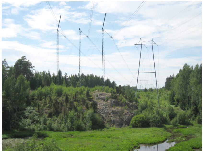
Kuva 2. 400kV ja 110 kV voimajohtolinjat Porvoonväylän pohjoispuolella. (Kimmo Tuomisto)
