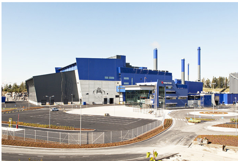
Kuva 16. Långmossebergenin jätevoimala (Olli-Pekka Orpo)
