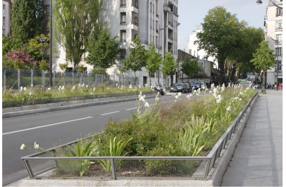
Kuva 46. Esimerkki kalualueen hulevesien imeytysrakenteesta Pariisissa.
