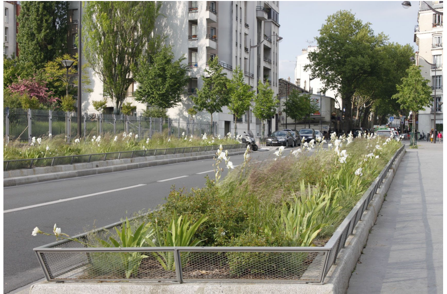
Kuva 46. Esimerkki kalualueen hulevesien imeytysrakenteesta Pariisissa.
