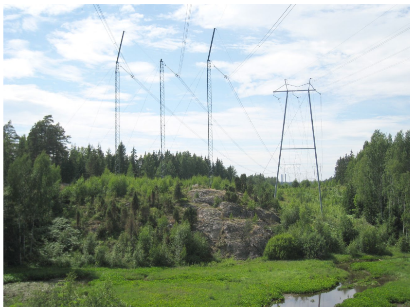
Kuva 2. 400kV ja 110 kV voimajohtolinjat Porvoonväylän pohjoispuolelle (Kimmo Tuomisto)
