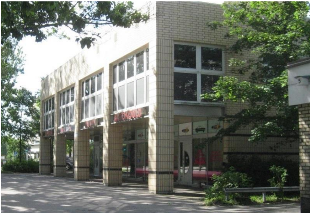
Kuva 16. Raskaat arkadit heikentävät palveluiden näkyvyyttä katukuvassa
