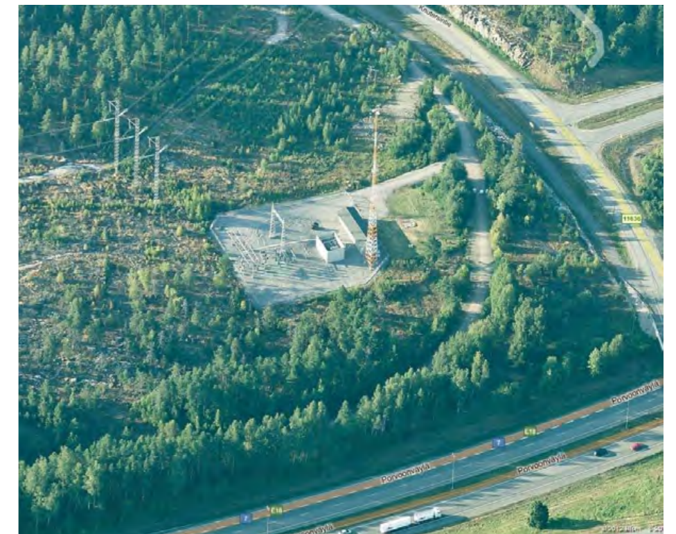
Yllä: Landbon nykyinen sähköasema. Kuva: Bing maps.
