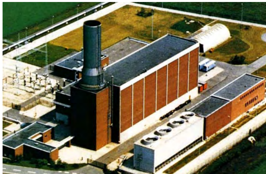
Vasemmallä: Huntorf. Paineilma on varastoitu luoliin maan alle. Kuva: E.ON.
