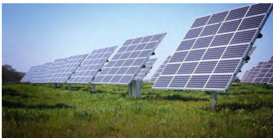
Yllä: Rinteeseen asennettuja aurinkopaneeleja Saksassa. Fürth-Atzenhof on entinen kaatopaikka. Kuva: Wiegel Verwaltung GmbH & Co KG.
