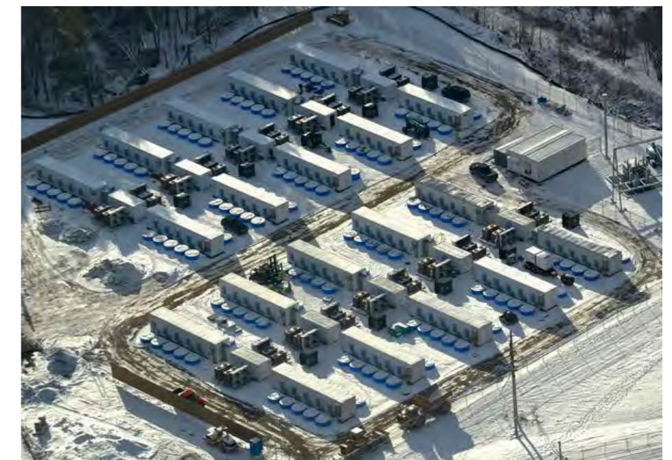
Oikealla: Stephentownin vauhtipyöräyksikkö. Kuva: Beacon Power LLC.
