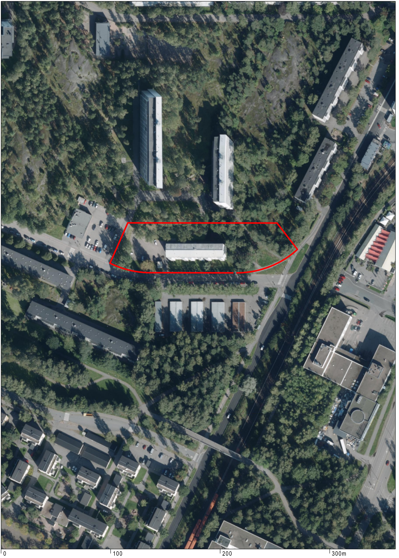
Ilmakuva Mellunkylä Keinulaudantie 3
