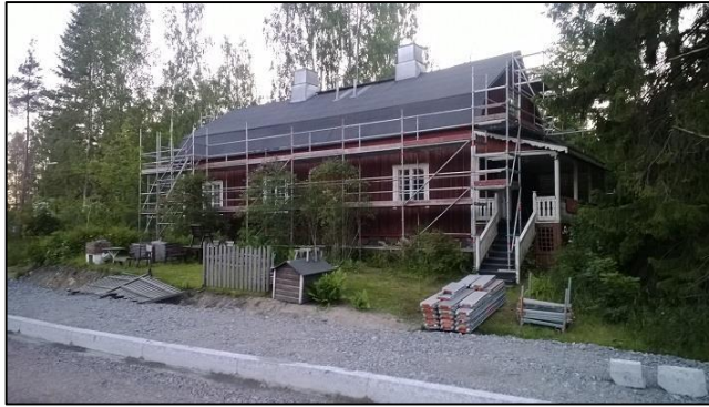
Kuva 19. Kaivoshuvilan ympärille asennettiin rakennustelineitä kesäkuun lopussa.
