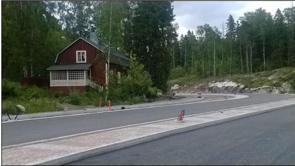
Kuva 1. Uusi Koirasaarentie Kaivoshuvilan eteläpuolella kesäkuussa 2015.
