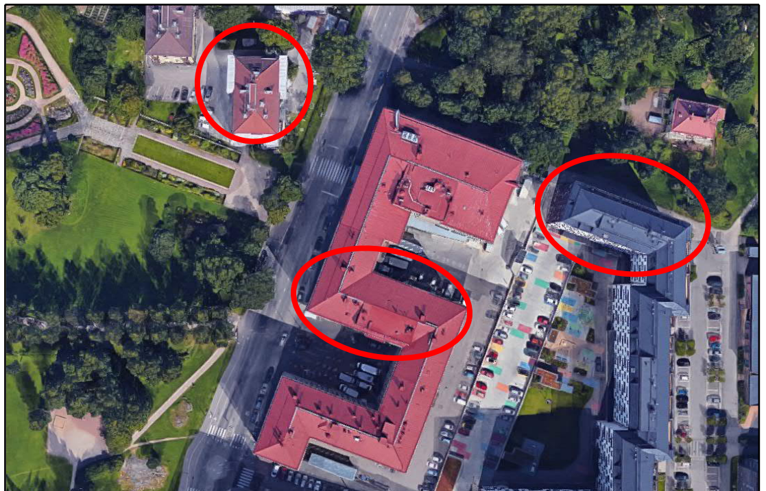
Kuva 4. Kohteen viereisten rakennusten katoilla sijaitsevat lähimmät LVIS-laitteet
