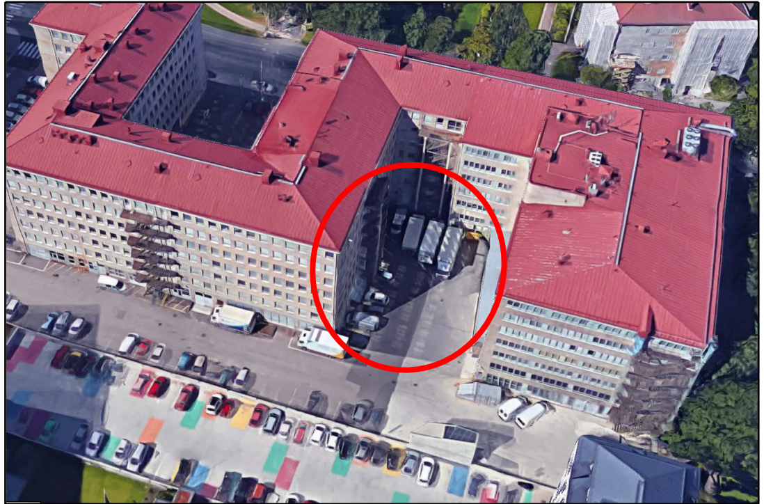
Kuva 6. Kohteen eteläpuolella sijaitseva lastauslaituri
