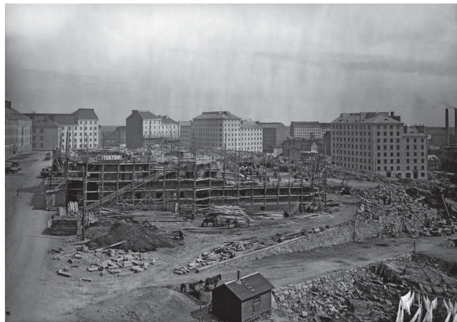
Agricolankatu 1-3. Helsingin Teollisuuskoulun työmaa. Erik Sundström 4.6.1929 / HKMA
