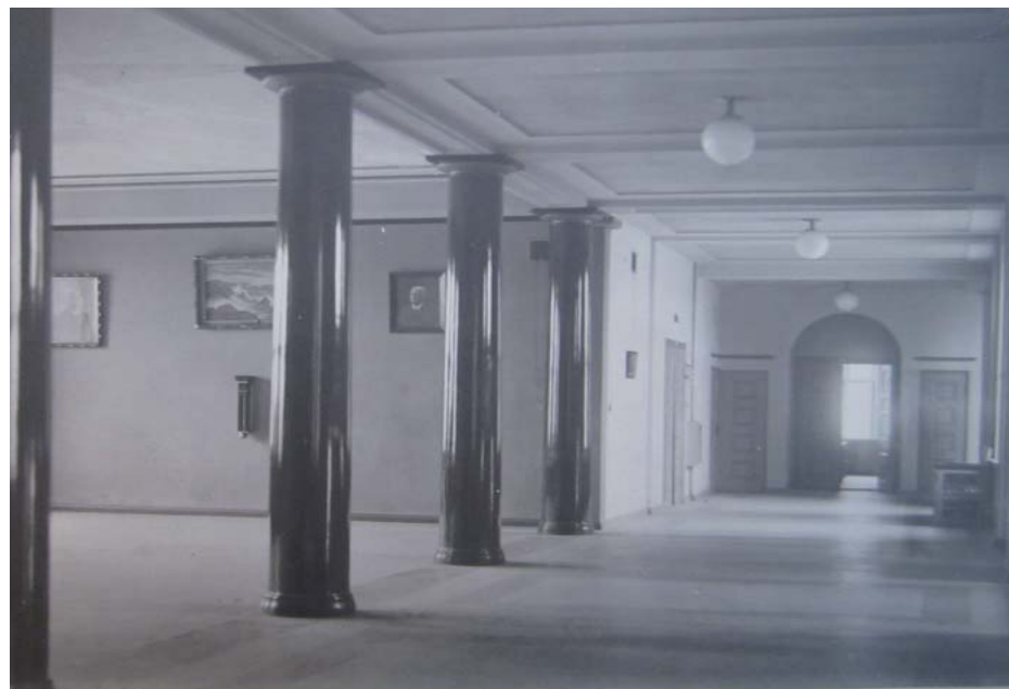
Kolmannen kerroksen aula ennen ovien paikan muuttamista 1975 peruskorjauksessa/ KA
