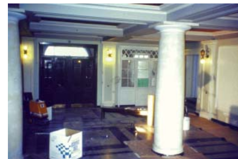
Sisäntulohallin pylväs ennen 1997 peruskorjausta. Kuva Eila Sammallahti.
