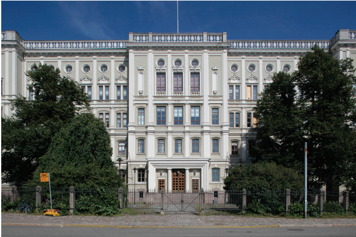
1. Päärakennuksen pääsisäänkäynti ei ole käytössä. Käynti rakennukseen tapahtuu sisäpihan kautta. Hietalahden puoleista pihaa kiertää rautakaide, jonka porttia pidetään lukossa.
