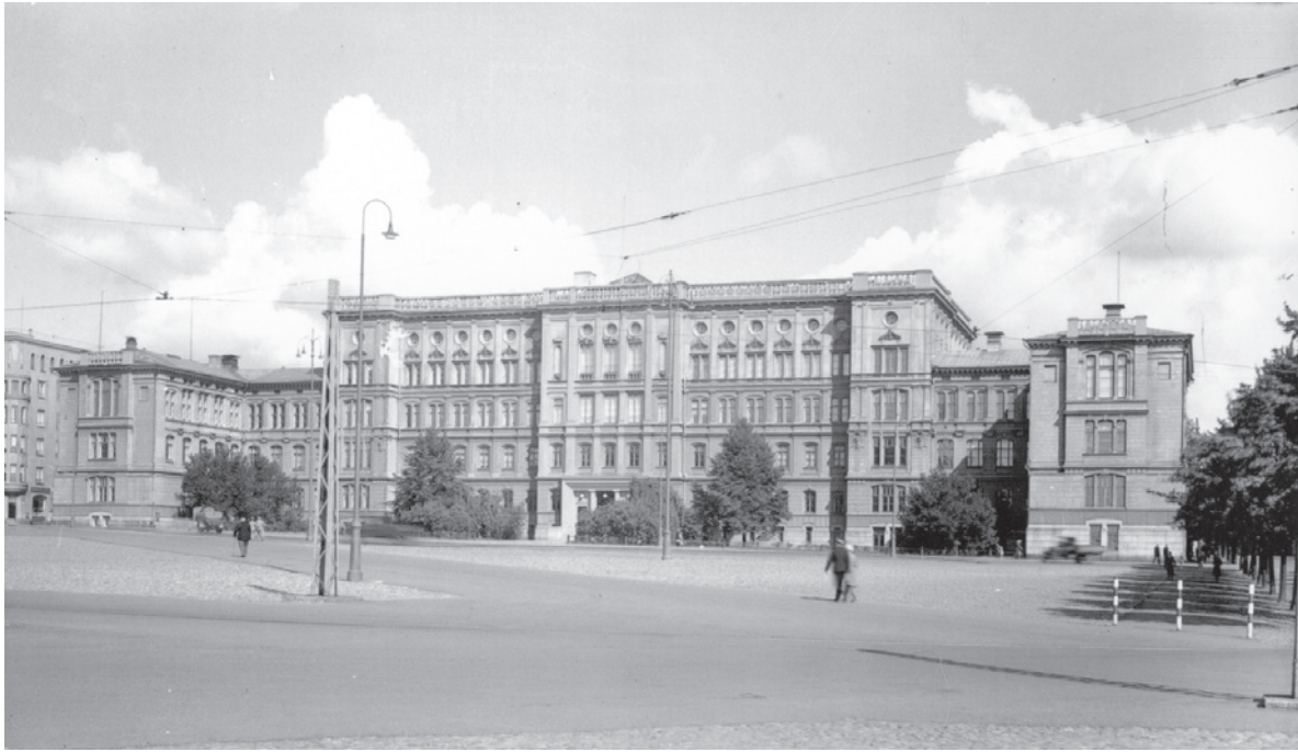
Vuoden 1928 korotuksessa päärakennus sai nykyisen ulkomuotonsa. AYA.
