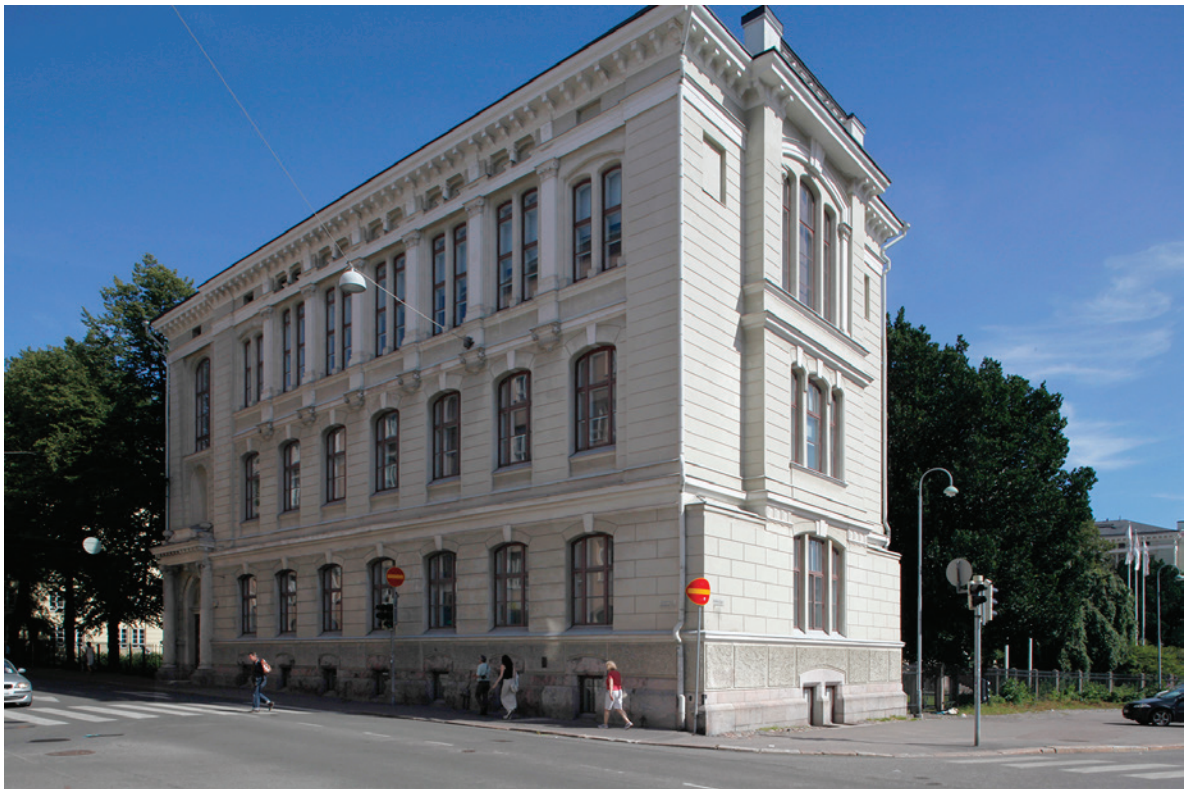
2. Päärakennuksen ikkunat uusittiin 1970-luvulla, mutta noudattavat alkuperäistä puitejakoa.
