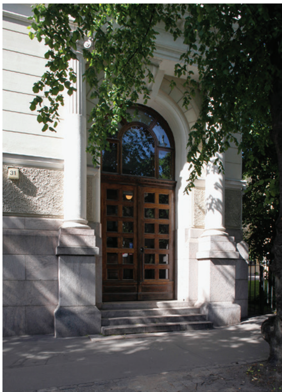
5. Eteläpuolen sisäänkäynnistä pääsee kellarin opiskelijaruokalaan. Ovet ovat samoin kuin pohjoispäädyssä Armas Lindgrenin suunnitelmien mukaisia.
