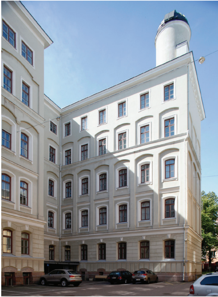
9. Observatoriota ei käytetä. Pohjoisen pihasiiven viereen on rakennettu roskakatos.
