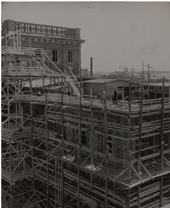
Päärakennusta korjataan talvisodan pommitusten jäljiltä. AYA.
