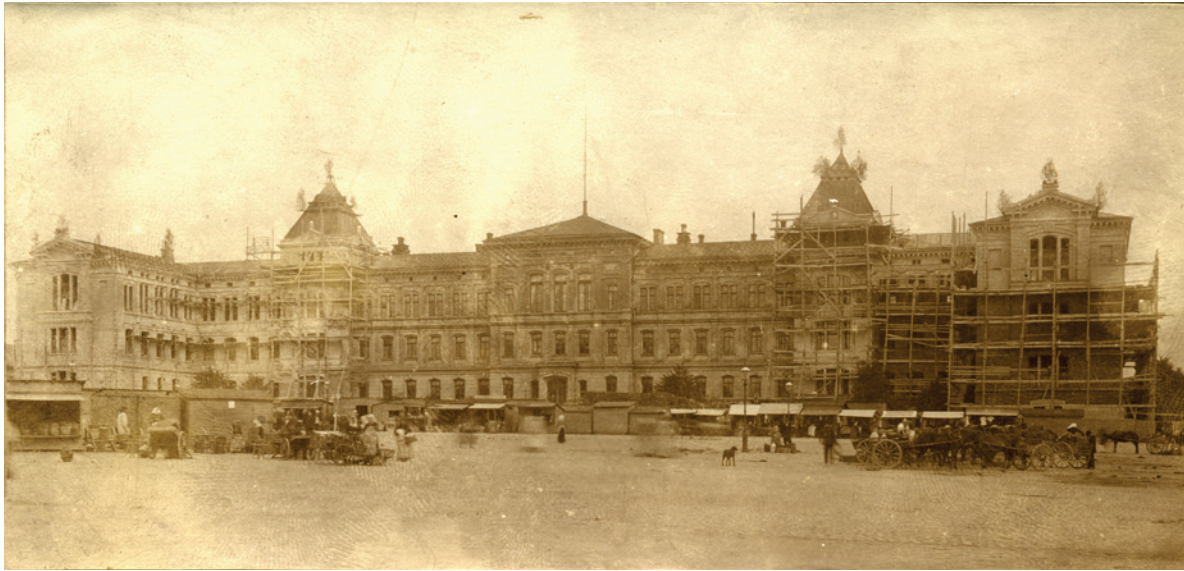
Nyströmin laajennuksen rakentamistyöt valmistumassa vuonna 1905. Juhlan kunniaksi on katolle kannettu koivuja koristukseksi. AYA.
