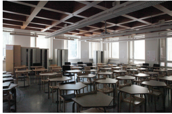
3. Ensimmäisen kerroksen eteläpäädyn suuressa salissa on säilynyt alkuperäinen kasettikatto. Kiinteät nousevat puupenkit on purettu ja lattia tasattu.
