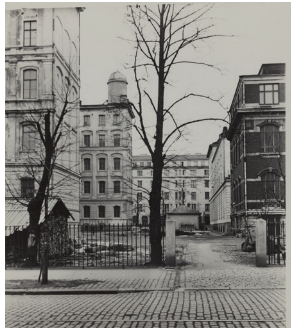
Vanhin Kemia laboratorio purettiin pommitusvaurioiden jälkeen. Myös pihalla näkyvä pieni varastorakennus purettiin myöhemmin. AYA.
