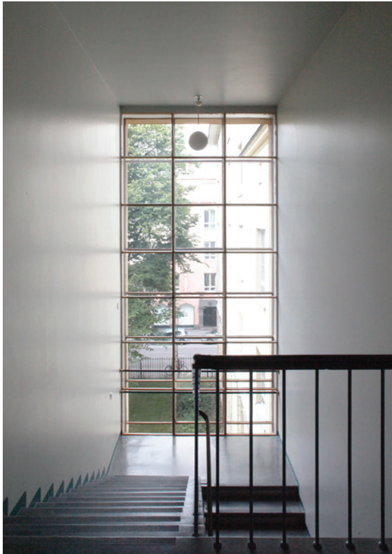
11. Pohjoisportaan ikkuna on alkuperäinen.
