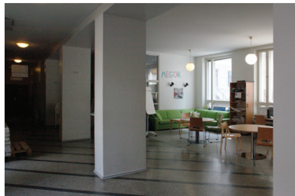
2. Aulan tilahahmo on säilynyt pääosin ennallaan, näkyvissä on alkuperäinen, dynaamisen viiteraitainen lattia sekä alkuperäisiä kattovalaisimia. Tilaan on lisätty runsaasti uusia kalusteita. Ikkunoiden viereinen lattia on uusittu.
