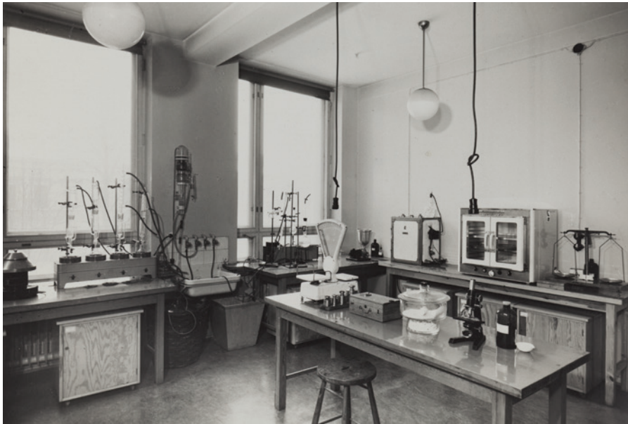
Laboratoriotiloja Uuden kemian rakennuksessa. AYA.
