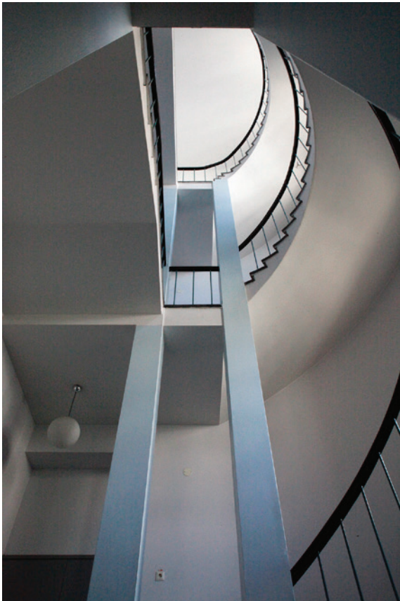
14. Portaan keskellä kulkee kaikkien kerrosten läpi korkeat, vaaleansiniseksi maalatut pylväät.
