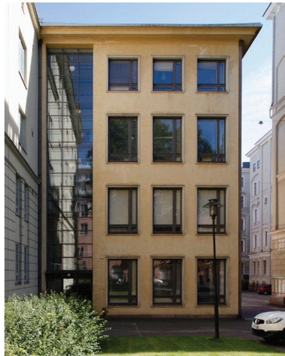
4. Pohjoisjulkisivussa Lönnrotinkadulle päin erottuvat porrastilan yhtenäiset ikkunat.
