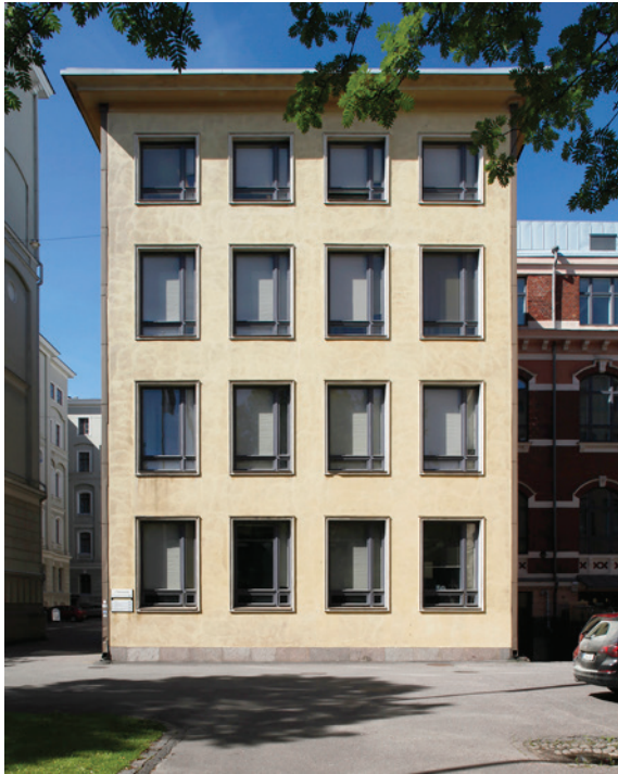
1. Eteläjulkisivu Bulevardille päin. Ulkoarkkitehtuuri on säilynyt alkuperäisenä.
