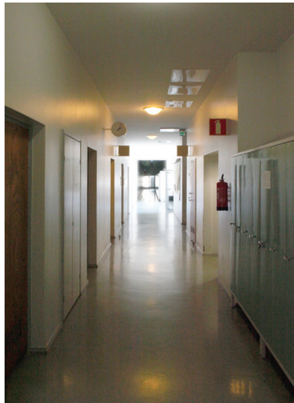
4. Käytävätilat ovat säilyneet hyvin alkuperäisessä tilahahmossaan. Ovet ja valaisimet pääosin alkuperäisiä.
