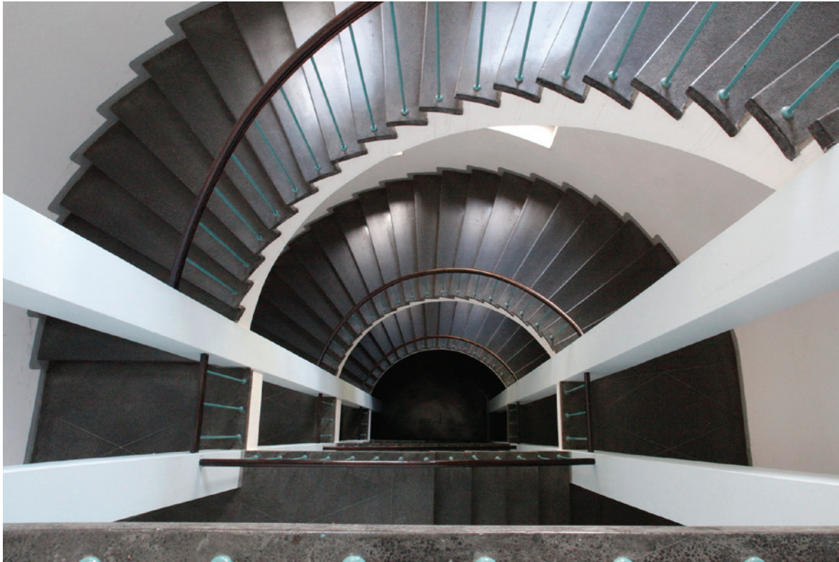
12. Uuden ja Vanhan kemian välinen porras seuraa alkuperäisen portaan muotoa, mutta on J. S. Sirénin suunnittelema. Porras ylhäältä päin katsottuna.
