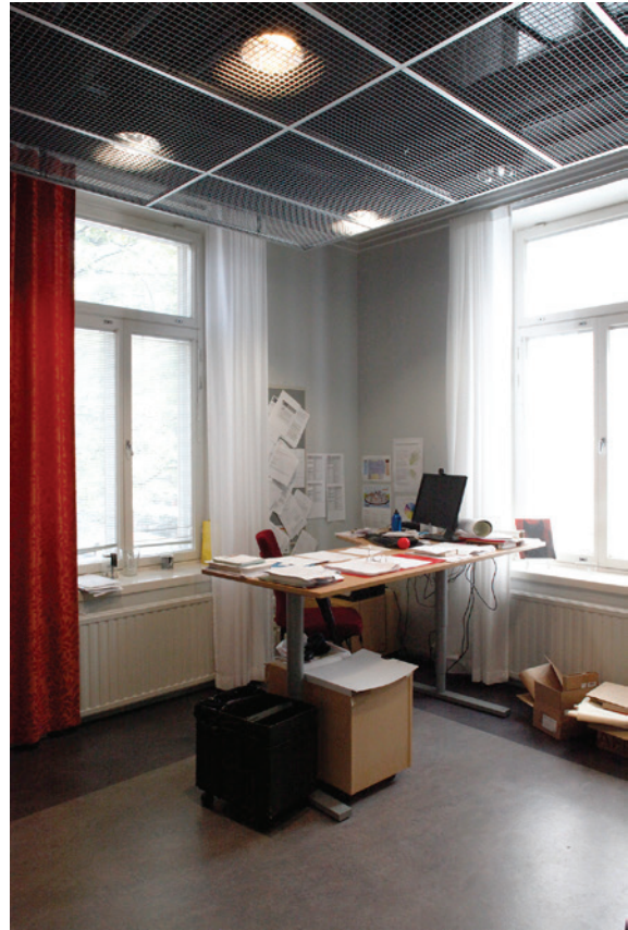
1. Kaikissa toimistohuoneissa on samat pintaratkaisut. Joissakin huoneissa on vanhoja kattolistoja näkyvillä ritilöiden takana.
