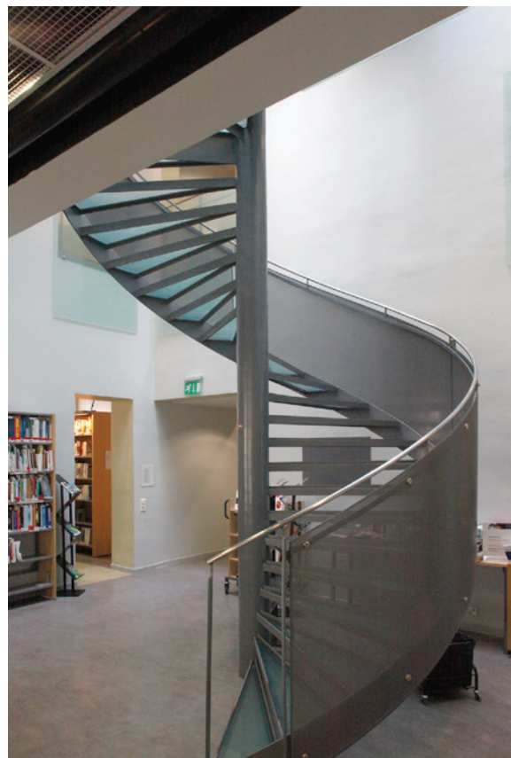
2. Kierreporras on tehty 2000-luvun alussa ja sille puhkottu tila rakennusrungon keskeltä.
