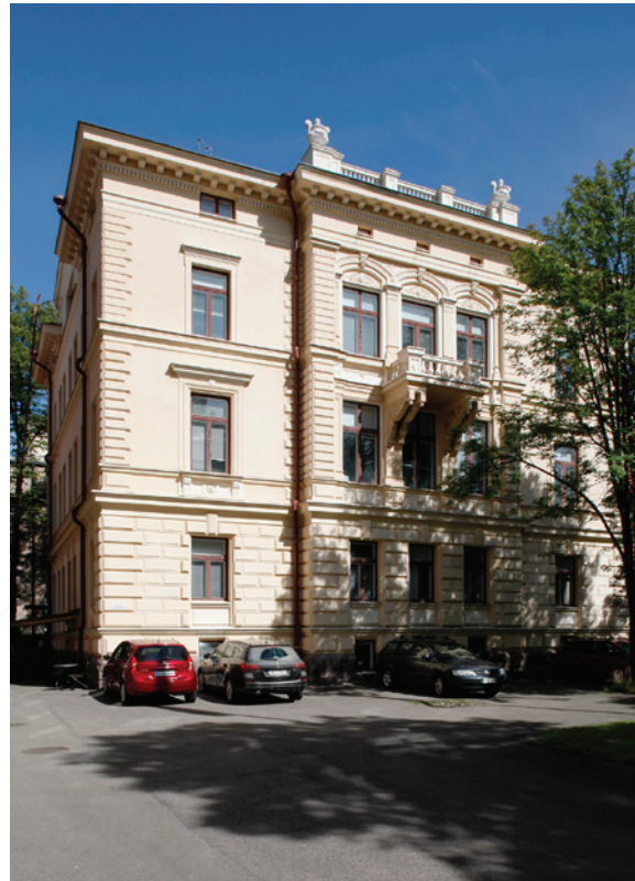
5. Länsijulkisivu päärakennukselle päin. Pohjoissivulla on sisäänkäynti pihaportaaseen ja kellariin. Katon uurnakoristeet on tehty vanhan mallin mukaan 1980-luvulla puuttuvien paikalle.
