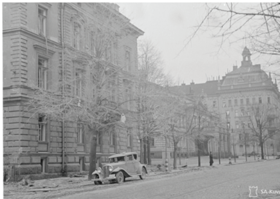
Talvisodan pommitusten jälkeen otetussa kuvassa näkyy vasemmalla Bulevardi 29. Rakennus kärsi sirpalevaurioita ja sen ikkunat sekä vesikatto rikkooutuivat. Taustalla Ooppera ja Neuvostoliiton suurlähetystö. Bulevardin puoleiset katon uurnakoristeet puuttuvat jo tässä. SA-kuva.
