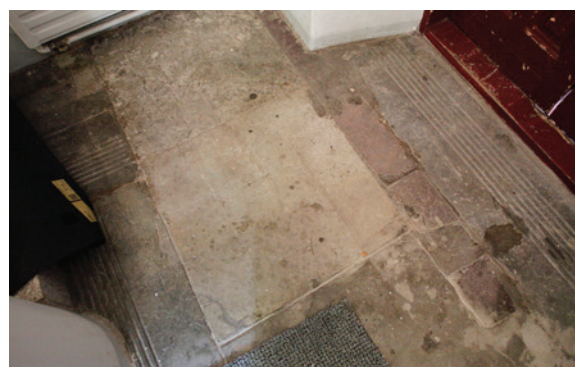
10. Vanhaa lattiapintaa on näkyvissä pihaportaan ulko-oven edessä. Lattia on ladottu fragmentaarista kalkkikivilaatoista, samaa laattaa on päärakennuksen vanhimmassa osassa.
