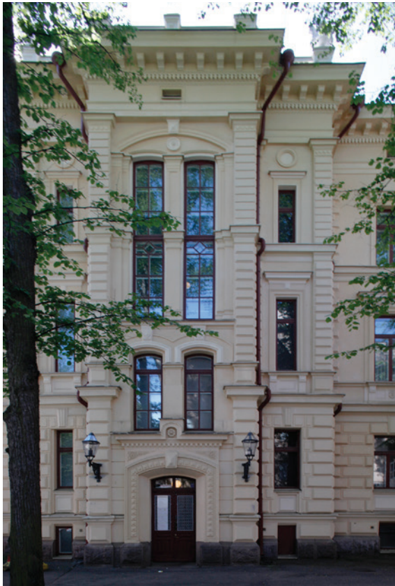
4. Pääportaan korkeat ikkunat erottuvat julkisivussa pääsisäänkäynnin yläpuolella.
