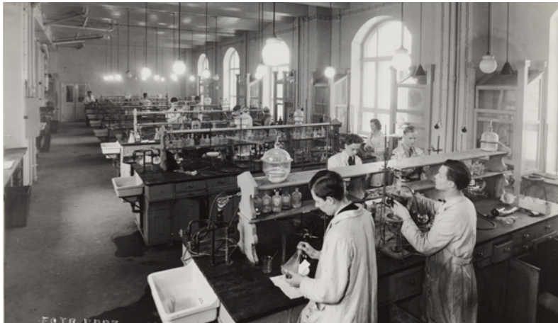
Yksi päädyn isoista laboratoriosaleista. Salissa oli valetut lattiat ja kiinteät työpöydät ja vetokaapit. Sähköjohdot kulkiivat pintavetoina, valaisimet olivat ripustettuja pallovalaisimia, jotka antoivat hyvän kohdevalaisun. AYA.
