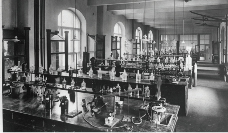
Vanhan Kemian laboratoriotilat rakennuksen itäpäädyn isoissa saleissa laajennuksen jälkeen. AYA.
