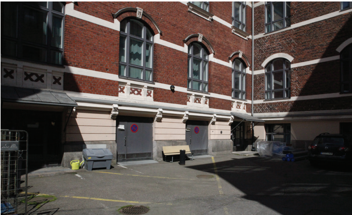
2. Eteläjulkisivuun on ikkunoiden tilalle tehty uusia sisäänkäyntejä sekä jätehuoneita kellariin.
