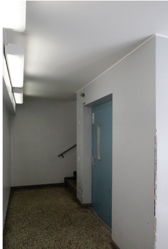
1. Uusi porras rakennettiin 1980-luvun peruskorjauksen yhteydessä
