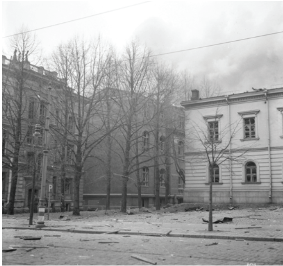
Talvisodan pommitusten jälkeen otettu valokuva. Keskellä Vanha kemia, vasemmalla Bulevardi 29, oikealla Ooppera. Sa-kuva.
