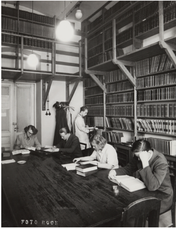
Ensimmäisen kerroksen kirjastohuoneessa oli puurakenteiset parvet, jotka nykyään on purettu. AYA.
