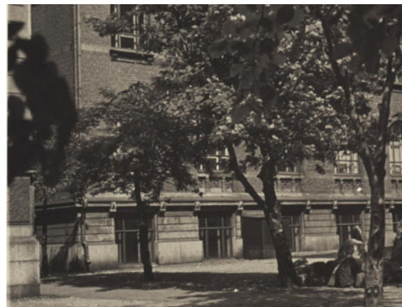
Sisäpihalla rakennusten ympärillä oli ruohokenttiä ja puita. AYA.
