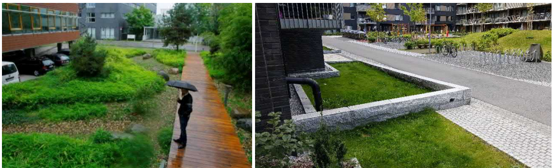
Kuva 7. Esimerkkejä korttelialueelle sijoitettavasta suodatusrakenteesta
