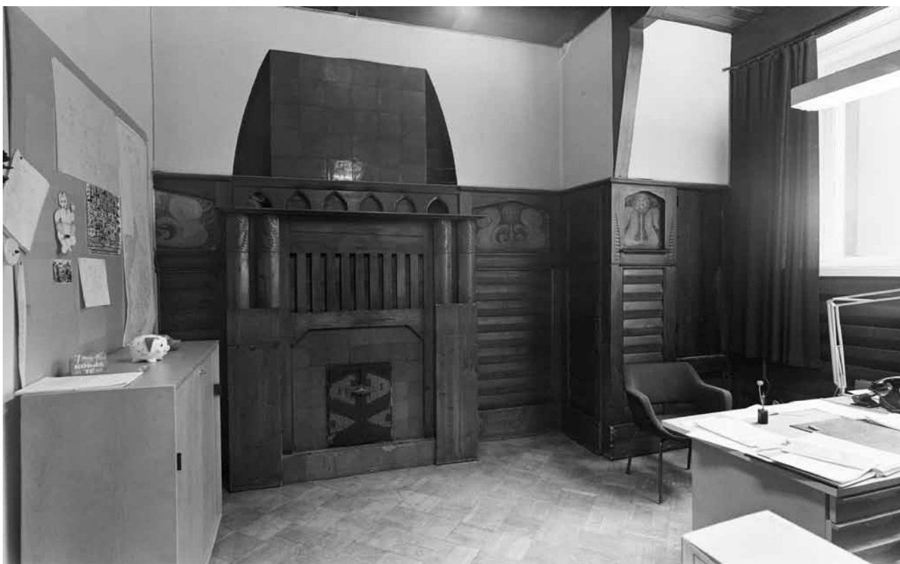
Entinen ruokasali jaettuna väliseinällä ja toimistokäytössä vuonna 1973. Seinä purettu myöhemmin. Kuva K.Hakli. HKM KA .
