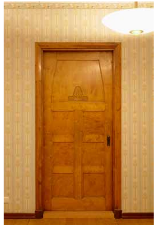
Tämä osittain visakoivusta valmistettu liukuovi ei ole alkuperäinen, mutta se mukaillee malliltaan alkuperäistä.
