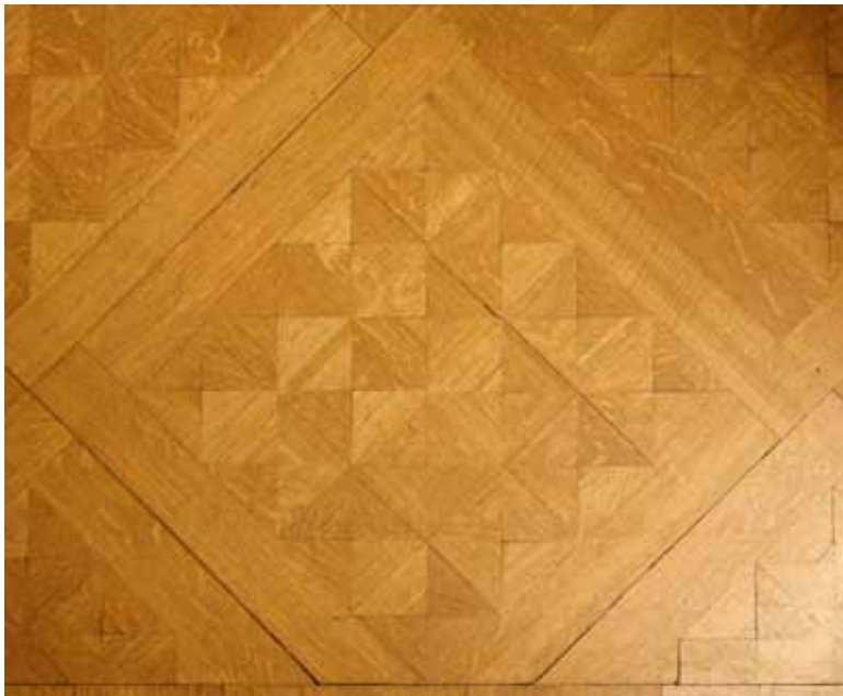
Kulmasalin alkuperäinen tammiparketti on säilynyt.
