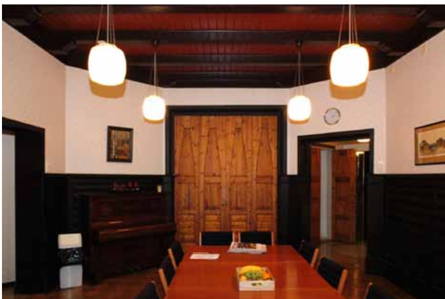
Alkuperäinen taiteovi. Katon sähköasennuksia on tehty valepalkkien sisään.
