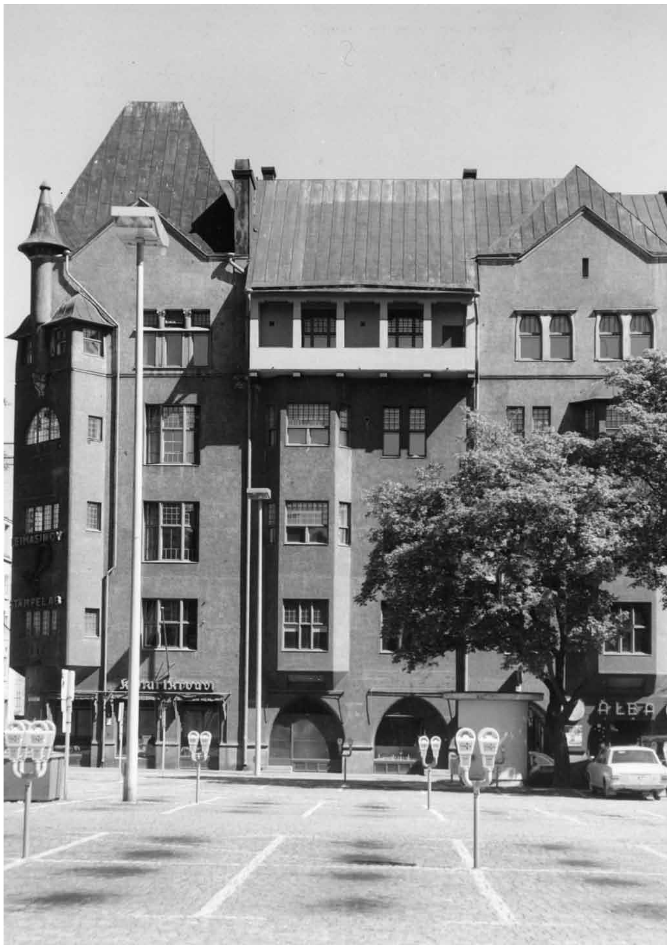
Julkisivu Fabianinkadulle kuvattuna 1962 jälkeen. Kuva István Rácz. MFA.
