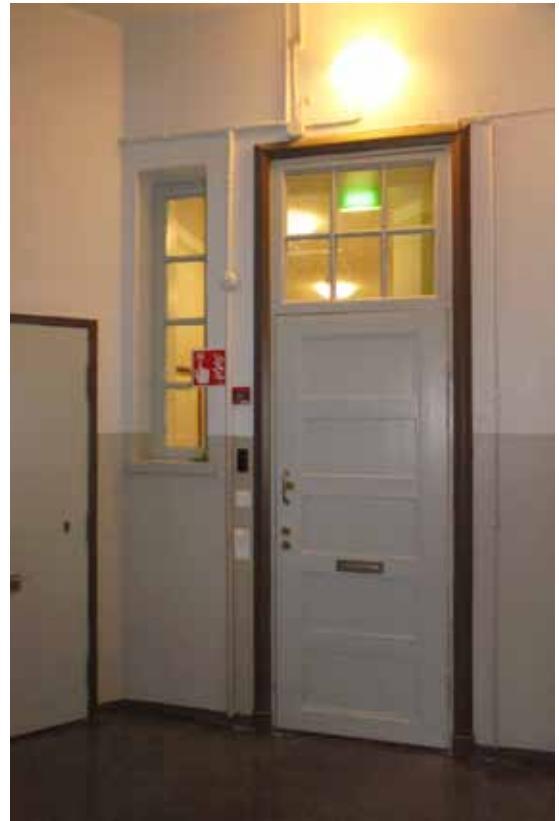
Pohjoisen Makasiinikadun asunnon alkuperäinen keittiön ovi. Porrasluoneen ovissa oli alunperin yläikkunat ja monissa myös sivuikkunoita. Sekundäärisessä tilassa oven muotoilu on suorakulmaista ja pääporrasluoneessa on suippeneviä, ajanmukaisia ikkunoita.
