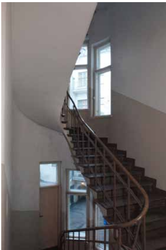
B-porras on säilynyt melko autenttisessa tilassa maantasokerroksen muutosta lukuunottamatta. Parvekkeiden ovet on uusittu.
