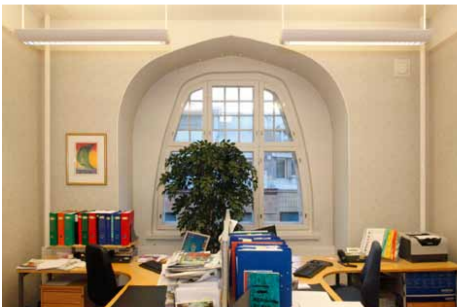
Viidennen kerroksen Pohjoisen Makasiinikadun puoleisessa huonerivin viimeisessä huoneessa on paksun seinärakenteen sisään muurattu suippokaari, jonka sisään muodostuvassa erkkerissä on ylälaidastaan suippeneva jugend-ikkuna. Ikkunan kohdalla on todennäköisesti melko ohut ulkoseinärakenne.
