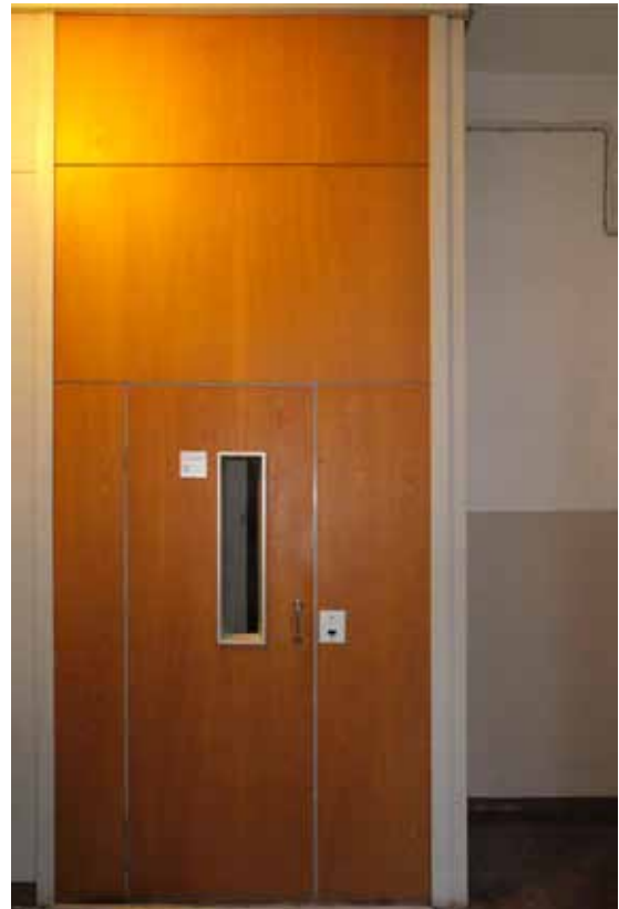
B-portaaseen on lisätty pieni henkilöhissi alkuperäisen halokohissin paikalle.
