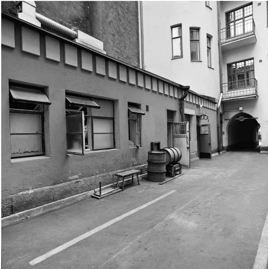
Piharakennus muutettiin v.1972 leipomoksi (Kotileipomo Eromanga). Kuva Matti Karjanoja 1978. HKM KA.
