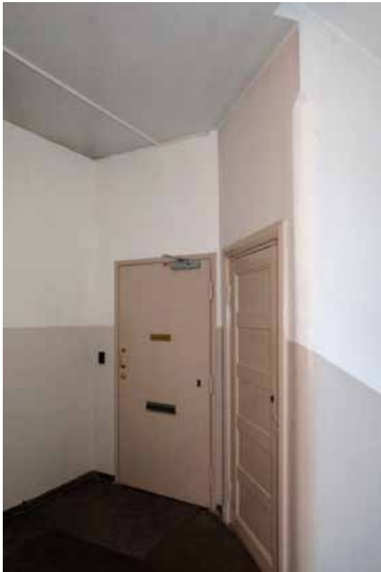
Pihasiiven asunnon ovi on uusittu laakaovi. Sen vieressä on käytöstä poistettu vanha keittiön sisäänkäynti alkuperäisine ovineen.
