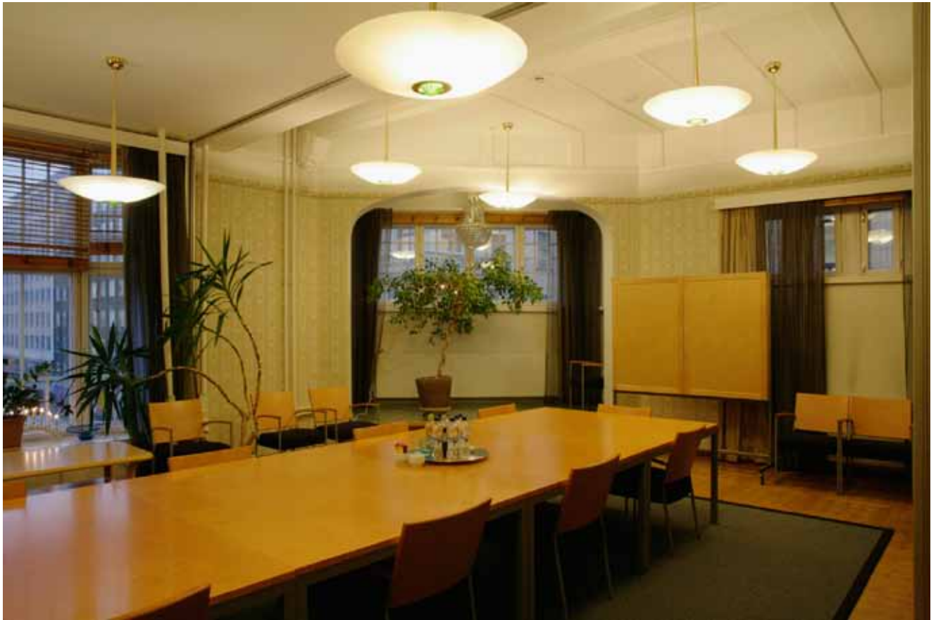
Puolet nurkkasalin katosta on alaslaskettu. Alakattoon on asennettu taittuva väliseinä, jolla tila voidaan jakaa.
