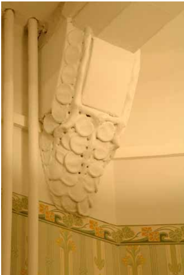
Kolmannen kerroksen nurkkasalissa on nähtävissä erkkeriä kannattavan teräspalkin koristeellinen rapattu konsoli.
