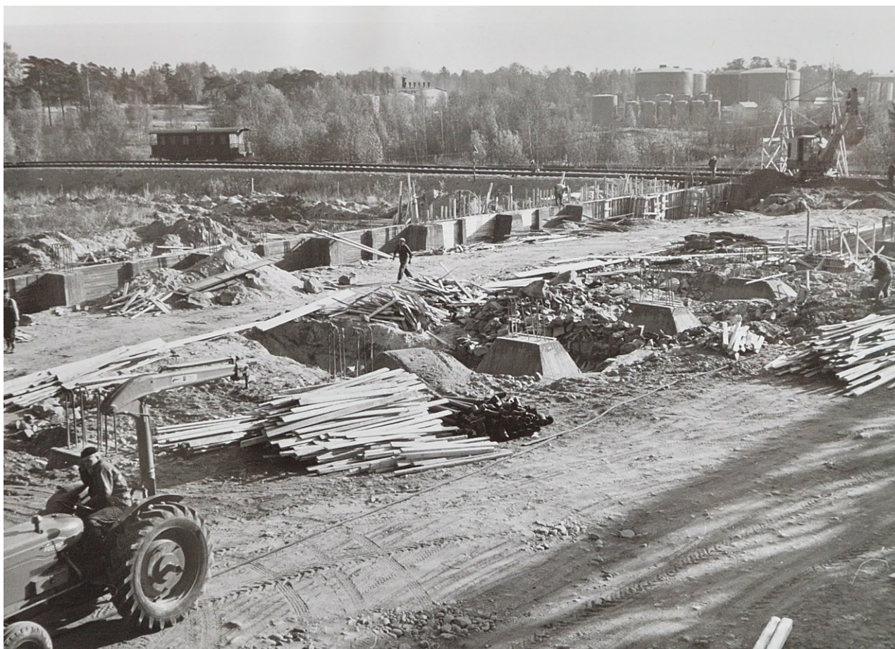
Telko Oy:n varastorakennus rakenteilla. 1960-luvulla. Elinkeinoelämän keskusarkisto, Mikkeli.
