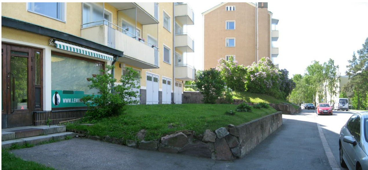
Hiihtomäentien katutilaa. Rakennukset on sijoitettu kadun suuntaisesti, mutta tontilla on kuitenkin kapea etupiha, joka rajautuu katuun pienellä korkeuserolla. Maantasokerroksessa on liiketilaa. (EV 2018)
