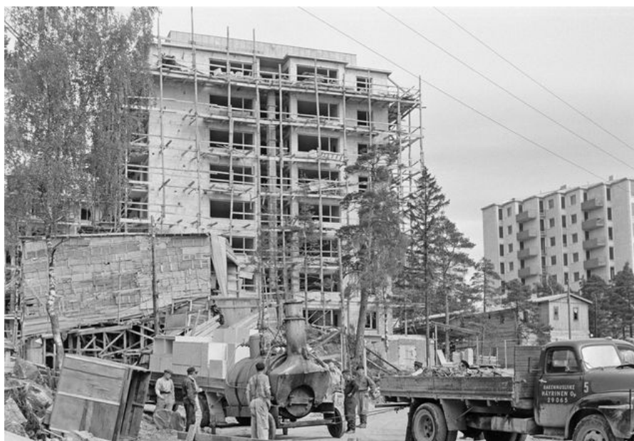
Rakennustyömaa Herttoniemessä vuonna 1957. Kuva: István Rácz / Helsingin kaupunginmuseo
