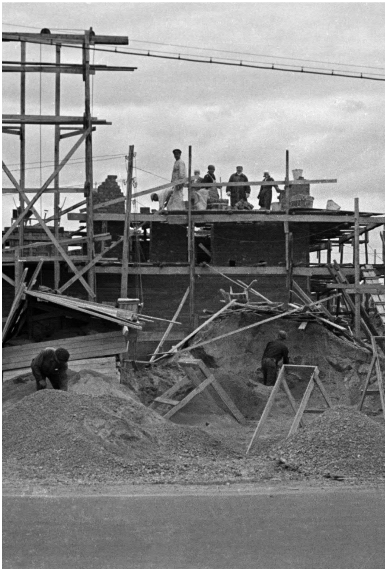
Rakennustyömaa Herttoniemessä, vuonna 1954, kuva: Kannisto Väinö / Helsingin kaupunginmuseo
