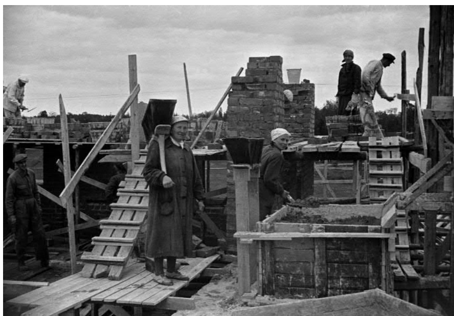
Herttoniemi, muuraustöitä rakennustyömailla, vuonna 1954, kuva: Väinö Kannisto / Helsingin kaupunginmuseo
