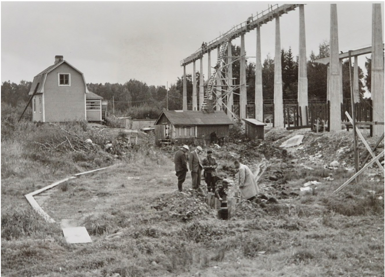
Entistä Elannon sekataivaramymälän henkilökunnan rakennusta puretaan betonirakenteiden tieltä. Telko Oy:n varastorakennuse rakenteilla 1960-luvun alussa. Elinkeinoelämän keskusarkisto, Mikkeli.
