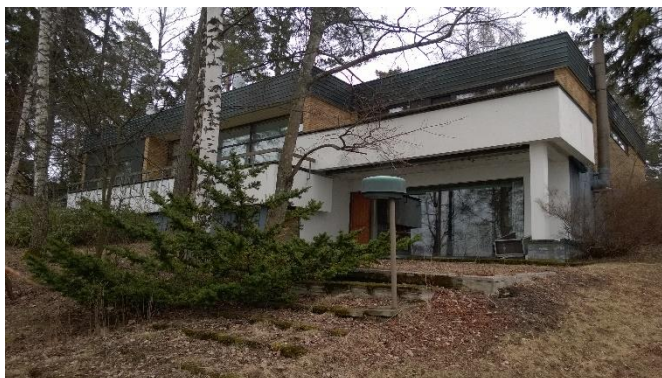
Vuonna 2017 purettu asuinrakennus
