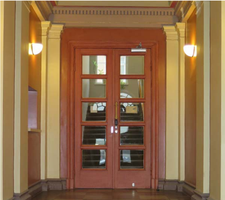
Eteishallin ja porrashuoneen lasipariliovet 1946 on jaettu viiteen päällekkäiseen lasikenttään, joita kehystää ulkoneva profiloitu kehys (vrt 1930-l. peiliovet). Eteishallin ovesa on kirkkaat lasit, mutta palo-ovina toimivien sivuovien lasit on muutettu rautalankalaseiksi. Saranat ovat alkuperäiset, mutta muut helat on uusittu lukuun ottamatta eteishallin oven messinkivedintä.
