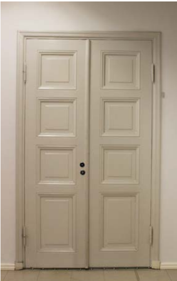
Paripeiliovet ovat alkuperäisiä. Niiden kolme ylintä peilikenttää ovat neliömäiset, alin peili on muita korkeampi. Kehyslistat ovat profiloidut ja ne liittyvät jalkalistoihin sokkelipaloin.
