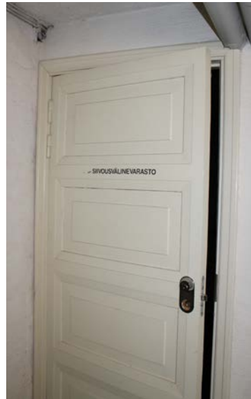
Kellarin peiliovet ovat neljään osaan jaettu peiliovia. Suurin osa kellarin peiliovista on uusittu vanhaa mallia mukaillen 1980-luvun korjauksessa, mutta vanha ovi on tallella 013/014 välillä. Ovet on maalattu vihreiksi ja valkoisiksi.
