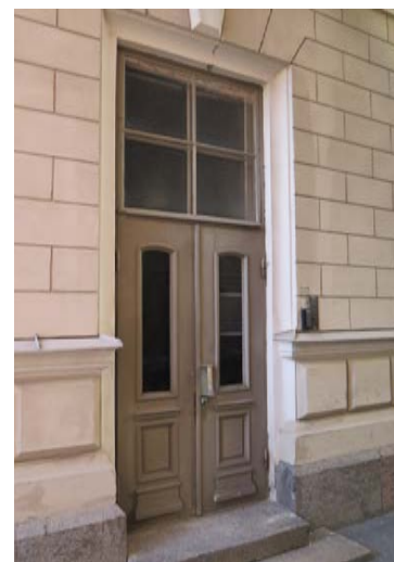
Itäpäädyn paripeilioessa on korkeat lasiaukot. Oven yläpuolella on lisäksi suuri neli-ruutuinen yläikkuna. Alkuperäisen oven vedin on ilmeisesti 1920-luvulta.
