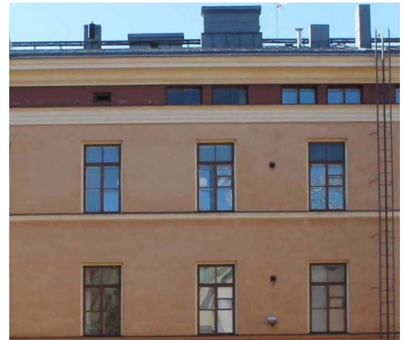
Ullakon ikkunat on sijoitettu friisimaiseen osaan. Keittiöporrashuoneiden ja niihin liittyvien tilojen kohdalla ikkunat ovat suuremmat. Muutama ikkuna on muutettu säleiköksi.
