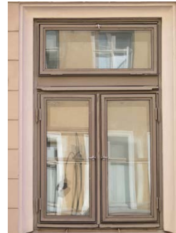
Kuusiruutuiset ikkunat sijoittuvat ensimmäiseen kerrokseen (yllä oik). Ikkunoissa on T-karmit, jotka jakautuvat pienempiin ruutuihin. Ensimmäisen kerroksen kahteen ikkunaan on lisätty palolasit teräslistoin (alla).
