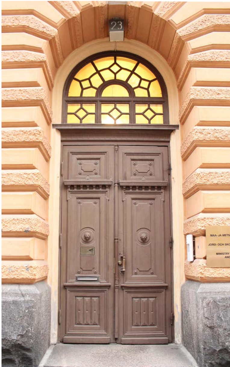
Pääsisäänkäynnin paripeilioveen liittyy kaareva koristeellinen yläikkuna. Pariovi on jaettu kolmeen peiliin. Korkeimman kesimmäisen peilin keskellä on koristeena leijonan päät. Ovesta on todennäköisesti alkuperäinen messinkivedin, jossa on sorvattu puukahva.
