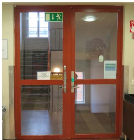
Porrashuoneiden teräslasiovet ovat peräisin 1980-luvun korjauksesta. Teräspalo-ovissa on yksi vaakajako ja rautalankasit. Ne on maalattu kerroksittain erivärisiksi.
