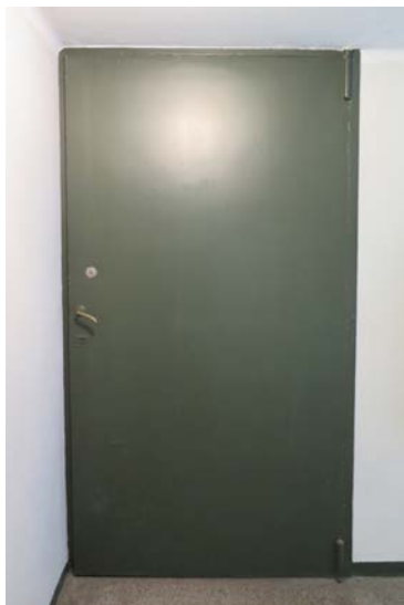
Ullakon palo-ovi on alkuperäinen teräslaa-kaovi, jossa myös alkuperäinen messinkipainike. Ovet on maalattu tummanvihreiksi.
