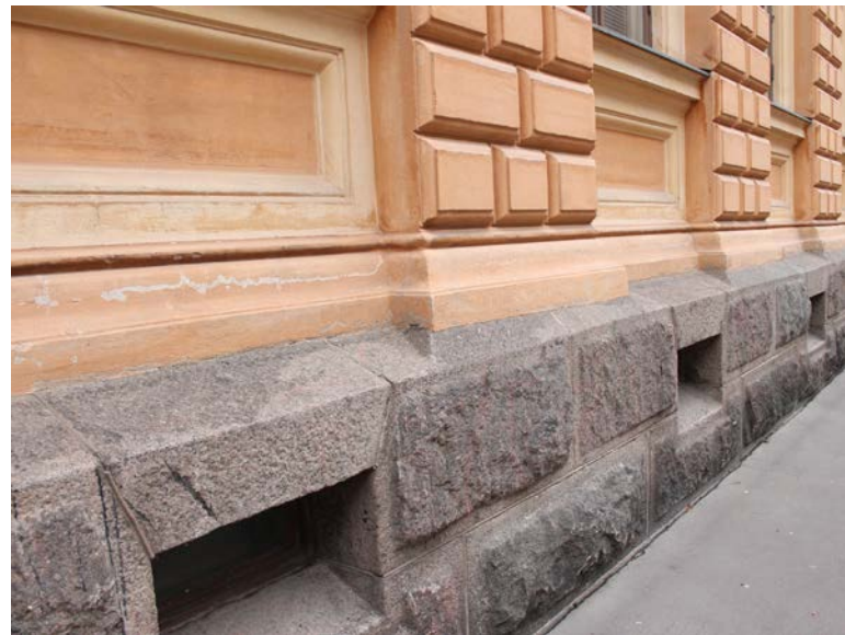
Kellarin ikkunat sijoittuvat sokkelin graniittimuuraukseen ja niissä on rautalankalaset. Osa ikkunoista on laitettu umpeen.
