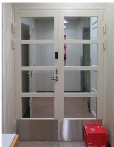
Käytävän teräslasiovet ovat vakiomallisia ja ne ovat peräisin 2000-luvun muutoksista.
