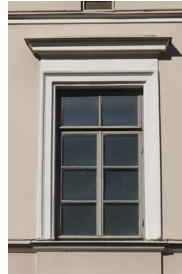
Kuusiruutuiset ikkunat sijoittuvat ensimmäiseen kerrokseen (yllä oik). Ikkunoissa on T-karmit, jotka jakautuvat pienempiin ruutuihin. Ensimmäisen kerroksen kahteen ikkunaan on lisätty palolasit teräslistoin (alla).
