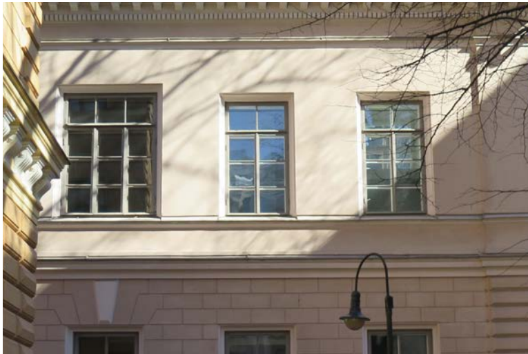
Moniruutuinen ikkuna länsipäädyn toisessa kerroksessa on alkuperäinen käytävän ikkuna, joka koostuu 12-ruudusta (vasemmalla). Se on myös muita korkeampi. Ensimmäisen kerroksen ikkuna-aukkoa on levennetty 1920-luvulla (yllä).
