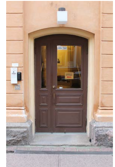
Pihasisivun peiliovet ovat samaa mallia ja niissä on lasiaukot. Vasikalliset ovet on sijoitettu kaarevaan oviaukkoon.
