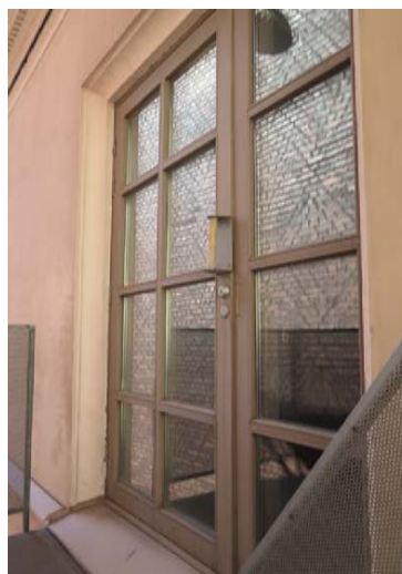
Itäpäädyn lasiovi on tehty alkuperäisen ikkunan paikalle 1990-luvulla poistumistietä varten. Ovi ja sen viereinen kapea ikkuna on jaettu 12-ruutuun, kuten paikalla ollut alkuperäinen ikkuna.
