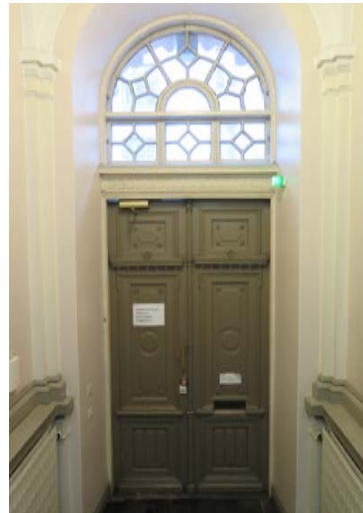
Pääsisäänkäyntien paripeiliovet ovat lähes identtiset pääsisäänkäyntioven kanssa. Niiden yläpuolella on myös kaarevat yläikkunat. Ovet on säilytetty julkisivussa, vaikka itse oviaukot on muurattu umpeen. Vetimet on ovista poistettu.
