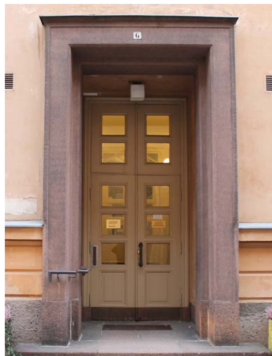
Pääovi G-porras on profiloitu paripeiliovi, jonka kolme ylintä kenttää on lasitettu. Oven yläpuolella on neliosainen ikkuna, joka jatkaa peilioven ylläosan aukotusta.
