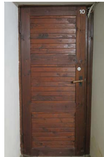
Kellarin paneeliovet ovat ruskeaksi petsatuja kolmen osaan jaettuja kehysovia, joiden peilit ovat vaakaponttipaneelia. Ne ovat peräisin vuoden 1946 korjauksesta.
