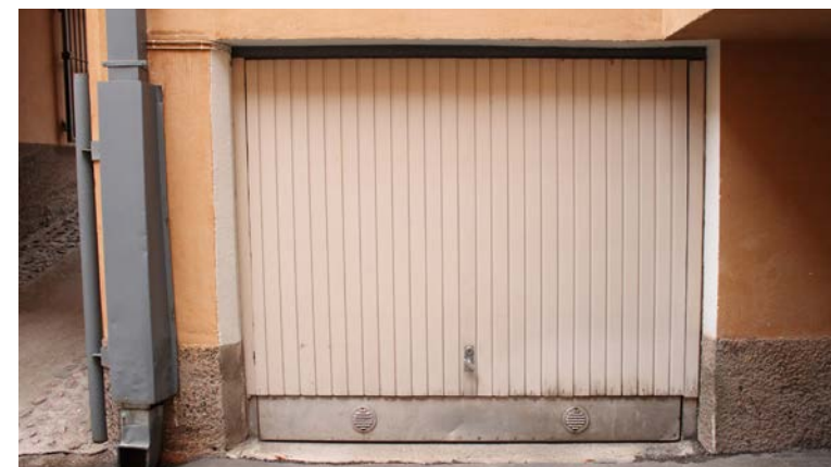
Autotallin ovi on uusittu 1970-luvulla pystypaneloiduksi kippioviksi.
