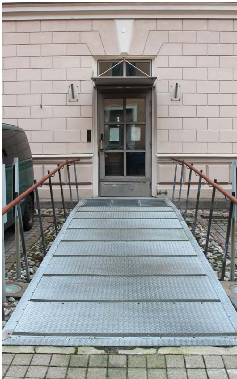
Pihasisivun sisäänkäyntiovi on 1990-luvulta. Puurakenteinen ovi on jaettu kuuteen lasiruutuun ja alaosassa on potkupelti. Oven vedin, joka on samanlainen kuin kahdessa vanhassa ovesta on siihen ilmeisesti siirretty.
