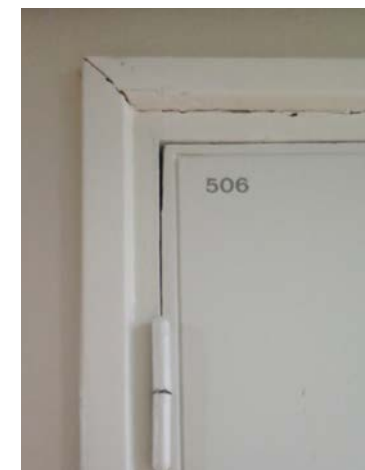
Uralaakaovet 1946 ovat peräisin v. 1946 korjauksesta ja laajennuksesta. Ovet ovat aikakaudelle tyypillisiä massiivisiä puuovia, joiden reunassa on kapea ura. Joidenkin ovien yläosassa on himmennetty lasi, jolloin kehys on profiloitu.
