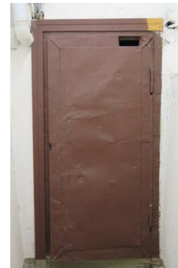
Kellarin teräsovet ovat peräisin vuoden 1946 korjauksesta ja niitä on käytetty teknisissä tiloissa. Ovet on maalattu ruskeiksi.
