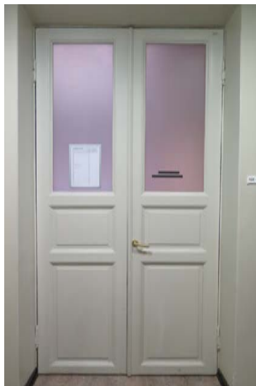
Lasiaukkoiset paripeiliovet ovat kolmeen peiliin jäsenettyjä peiliovia, joissa ylimmän peilin paikalla on opaalisit. Ovet ovat ilmeisesti 1930-luvulta (esim. 123).
