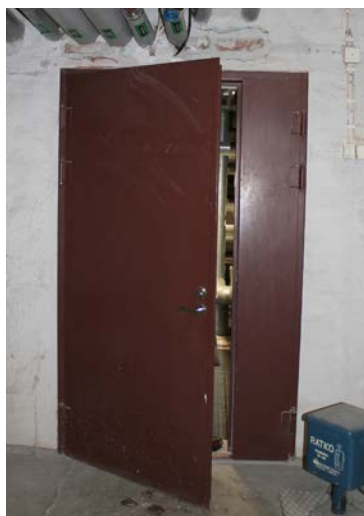
Kellarin palo-ovet ovat vakiomallisia teräslavyypintaisia laakaovia 1980-luvun korjauksesta. Ovet on maalattu punaisiksi, vihreiksi ja valkoisiksi.
