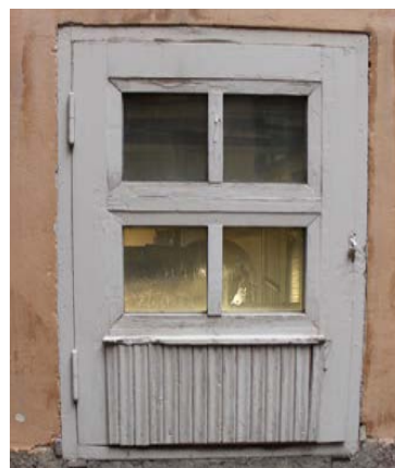
Sisäpihan ikkunaluukku on sijoitettu entisen ikkunan paikalla ilmeisesti 1980-luvulla. Alaosan keilapaneeli ilmeisesti peräisin vanhasta ulko-ovesta.
