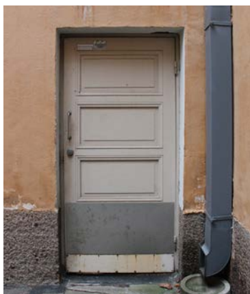
Sisäpihan huoltotilojen peiliovi on uusittu 1980-luvulla vanhaa tyyliä mukaillen.
