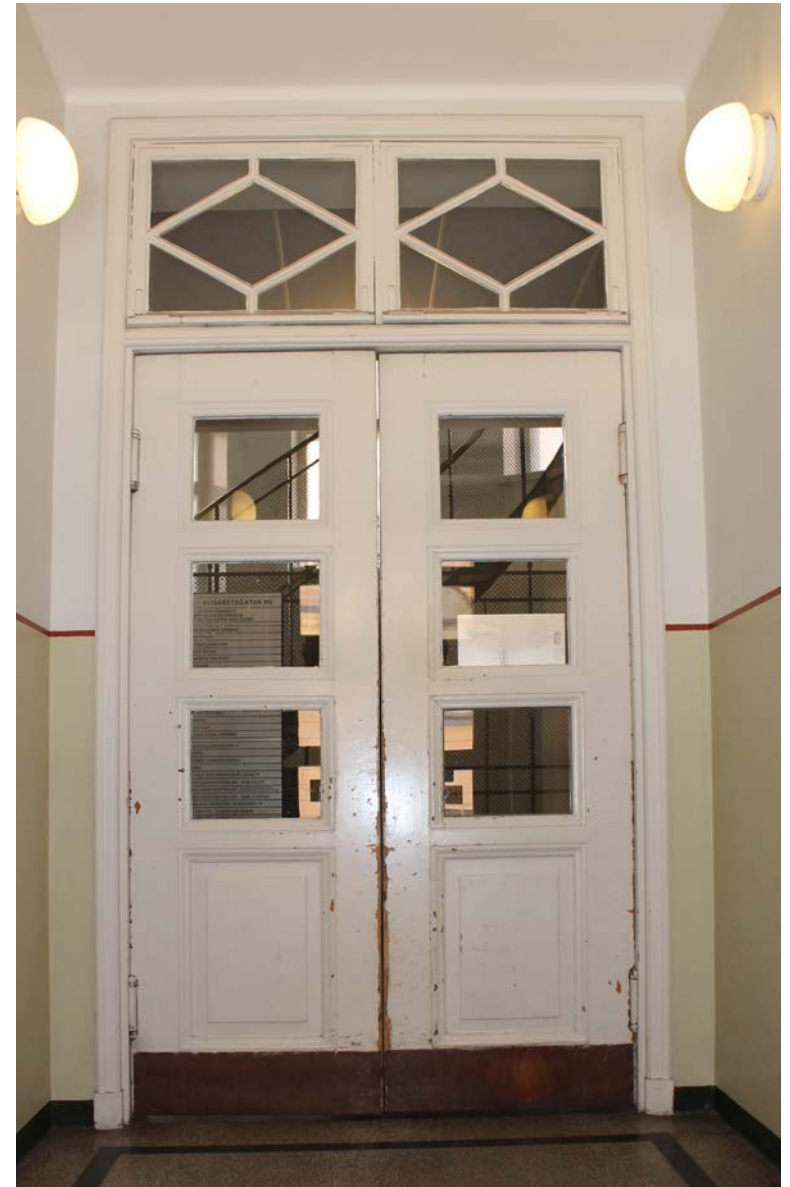
Tuulikaapin heiluriovi on alkuperäinen pari-ovi, jonka yläpuolista ikkunaa koristavat vinoneliöt.
