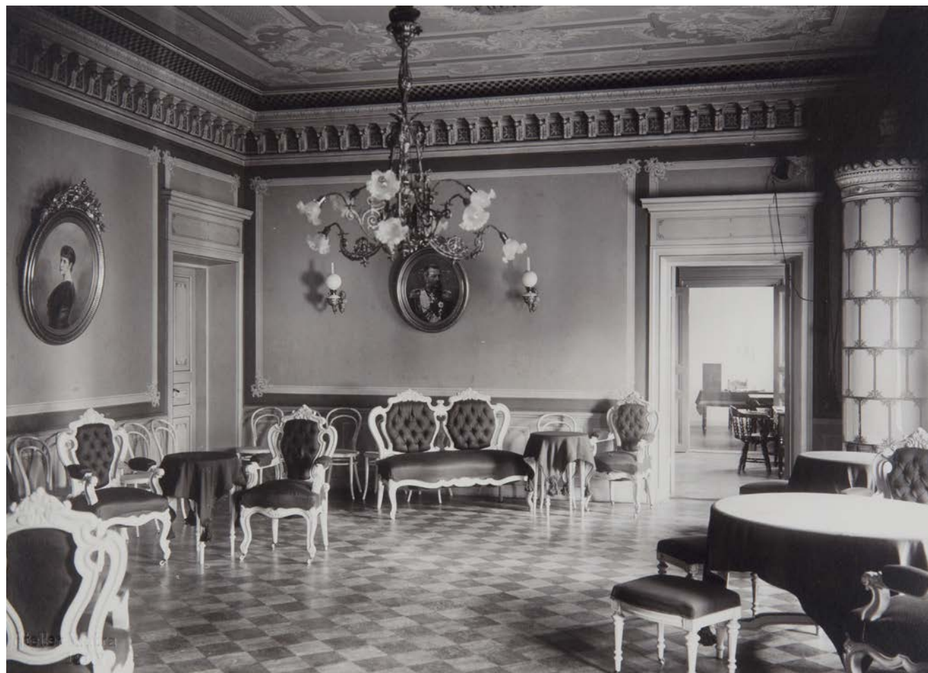
Klubi- ja kansliarakennuksen 2.krs:n sali. Seinäpinnat on jäsenelty peilikenttiin ja kattopinnat ovat kauttaaltaan maalauskoristellut. Akanthus-lehvien koristamat konsolit kannattavat profiloitua kattolistaa, jota on edelleen nähtävissä porrashuoneen puolella. Ulkoseinällä on kaksi pylväskaakeliuunia. Oviaukosta näkyy kanslian kaksi huonetta. F. Engström/ SM
