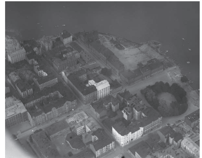
Ilmakuvassa vuodelta 1927 näkyy vasemmalla alhaalla ent. upseerirakennukset ja sisäpihan tallirakennus sekä ylhäällä oikealla rantaan ulottuvat miehistökasarmit nyk. Liisanpuistikon varrella. SM
