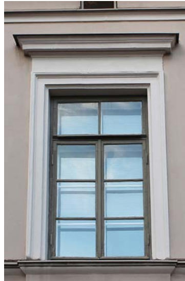
Kahdeksanruutuiset ikkunat sijoittuvat toiseen kerrokseen ja niissä on rapatut kehyslistoitukset. 1920-luvun ikkunat on tehty vanhan mallin mukaan. Katusivulla on yksi vaalea ikkuna (yllä oikealla).
