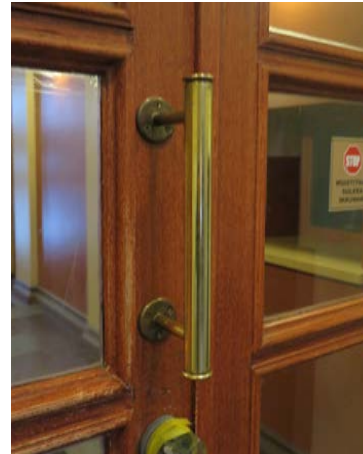
Eteishallin ja porrashuoneen lasipariliovet 1946 on jaettu viiteen päällekkäiseen lasikenttään, joita kehystää ulkoneva profiloitu kehys (vrt 1930-l. peiliovet). Eteishallin ovesa on kirkkaat lasit, mutta palo-ovina toimivien sivuovien lasit on muutettu rautalankalaseiksi. Saranat ovat alkuperäiset, mutta muut helat on uusittu lukuun ottamatta eteishallin oven messinkivedintä.
