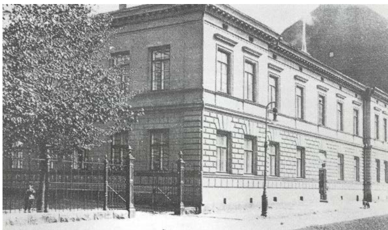
Valtion siementarkastuslaitos 1920-luvun muutostöiden jälkeen. Maneesikadulle on avattu uusi sisäänkäynti ja länsipäättyyn uusia ikkunoita. Kuva teoksesta VSTL 70 vuotta.
