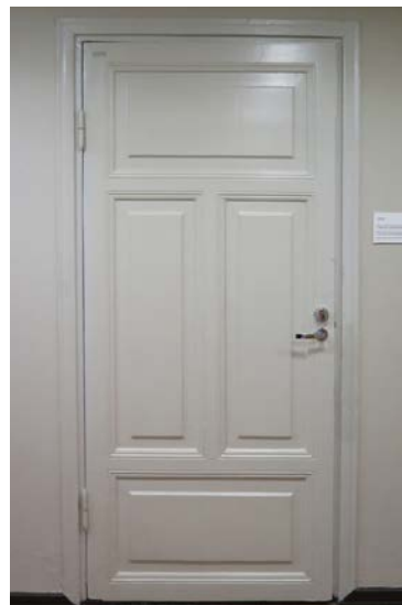
Alkuperäiset yksilehtiset peiliovet on jäsenetty neljään kenttään: ylhäällä ja alhaalla on vaakapeilit ja keskiosassa vierekkäin kaksi pystypeiliä. Saranat ovat alkuperäiset, mutta painike on moderni tai uusi "antiikkimalli". 1930-luvun peiliovet on puolestaan jäsenetty neljään vaakasuuntaiseen peiliin.
