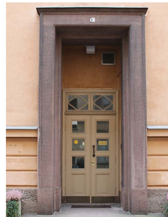
Sivuovi F-porras on profiloitu paripeiliovi, jonka kolme ylintä kenttää on lasitettu. Oven yläpuolella on ikkuna, jossa on vinoneliön muotoinen puitejako.
