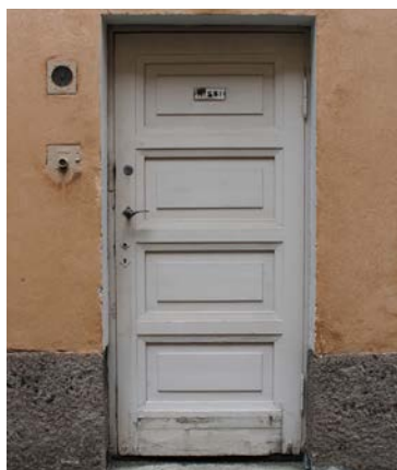
Hissin ulko-ovi on alkuperäinen neljään kenttään jaettu peiliovi. Saranat, lukko ja painike ovat myös alkuperäiset.
