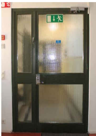
Lasipalo-ovet porrashuoneissa ovat 1970-luvun puolivälistä. Teräsrakenteisissa rautalankalasiovissa on kapea vasikka. Ovet on maalattu vihreiksi ja niissä on kromatut putkivetimet.
