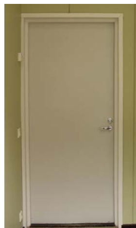
Muut ovet ovat umpinaisia teräspalo-ovia, myöhempiä laakaovia (esim. 129c) ja yksittäisiä 1980-l. peiliovia (esim. wc 126).
