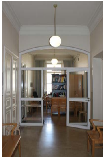
Käytävän päätteenä oleva teräslasiseinä ovineen on lisätty 1980-luvun lopun peruskorjauksen jälkeen.
