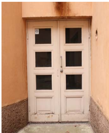
Sisäpihan paripeiliovi on uusittu 1980-luvulla vanhaa tyyliä mukaillen.
