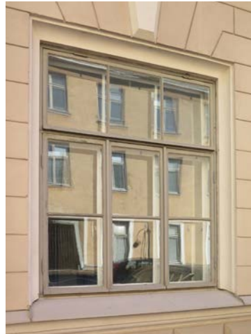
Moniruutuinen ikkuna länsipäädyn toisessa kerroksessa on alkuperäinen käytävän ikkuna, joka koostuu 12-ruudusta (vasemmalla). Se on myös muita korkeampi. Ensimmäisen kerroksen ikkuna-aukkoa on levennetty 1920-luvulla (yllä).
