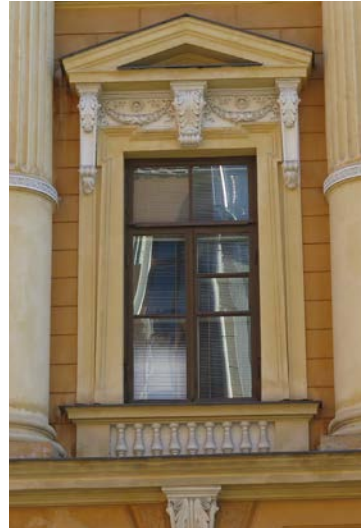
Kuusiruutuiset ikkunat jäsentävät rakennuksen toista ja kolmatta kerrosta. (T-malli). Ikkunoissa on tuuletusta varten nk. fortuskat.
