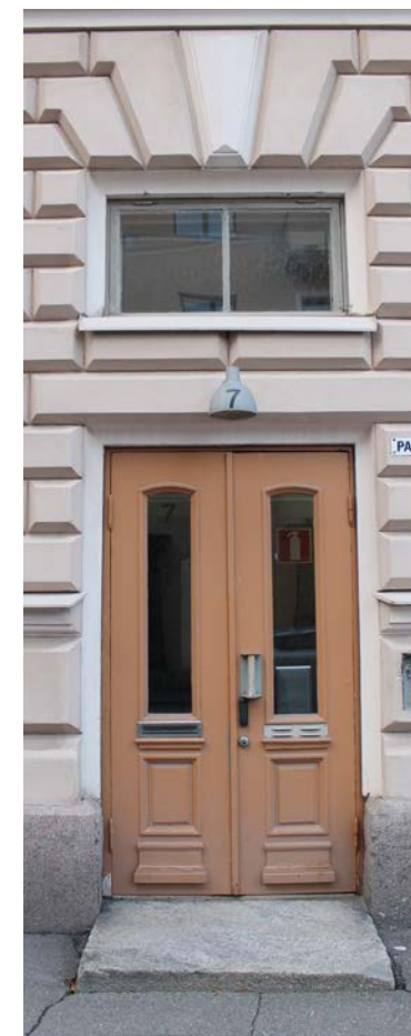
Katusivun paripeiliovi on samaa mallia kuin itäpäädyn alkuperäinen ovi. Se on todennäköisesti myös alkuperäinen ja siirretty länsipäädyistä 1920-luvulla. Punertavanruskea väri poikkeaa muista ovista. Alkuaan ovet ilmeisesti ootrattu tammen sävyyn, joka säilynyt sisäpuolella.
