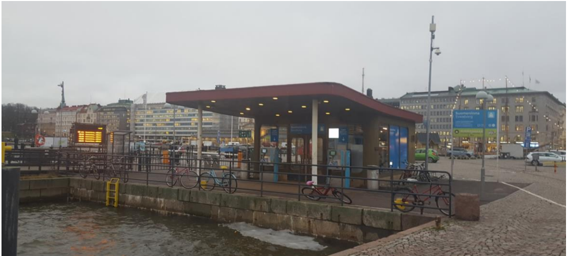
Suomenlinnan lautan nykyinen terminaalirakennus.
