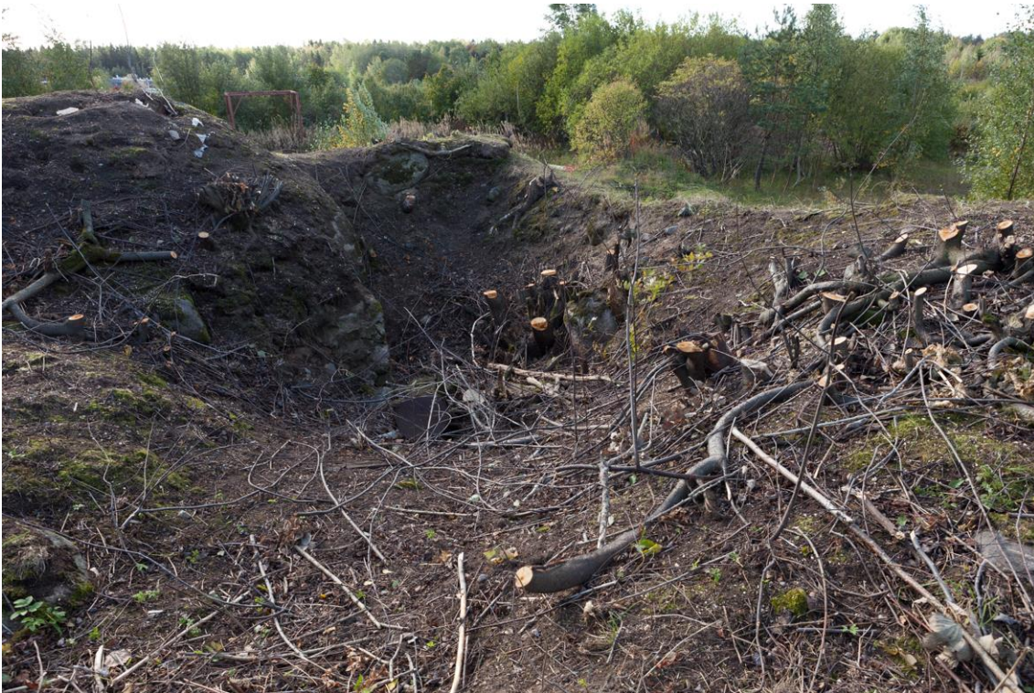
Suojahuoneen edessä oleva kaivanto, jonka kautta on kulku suojahuoneen sisälle. Kuvattu koillisesta. (AKDG5572: 8)
