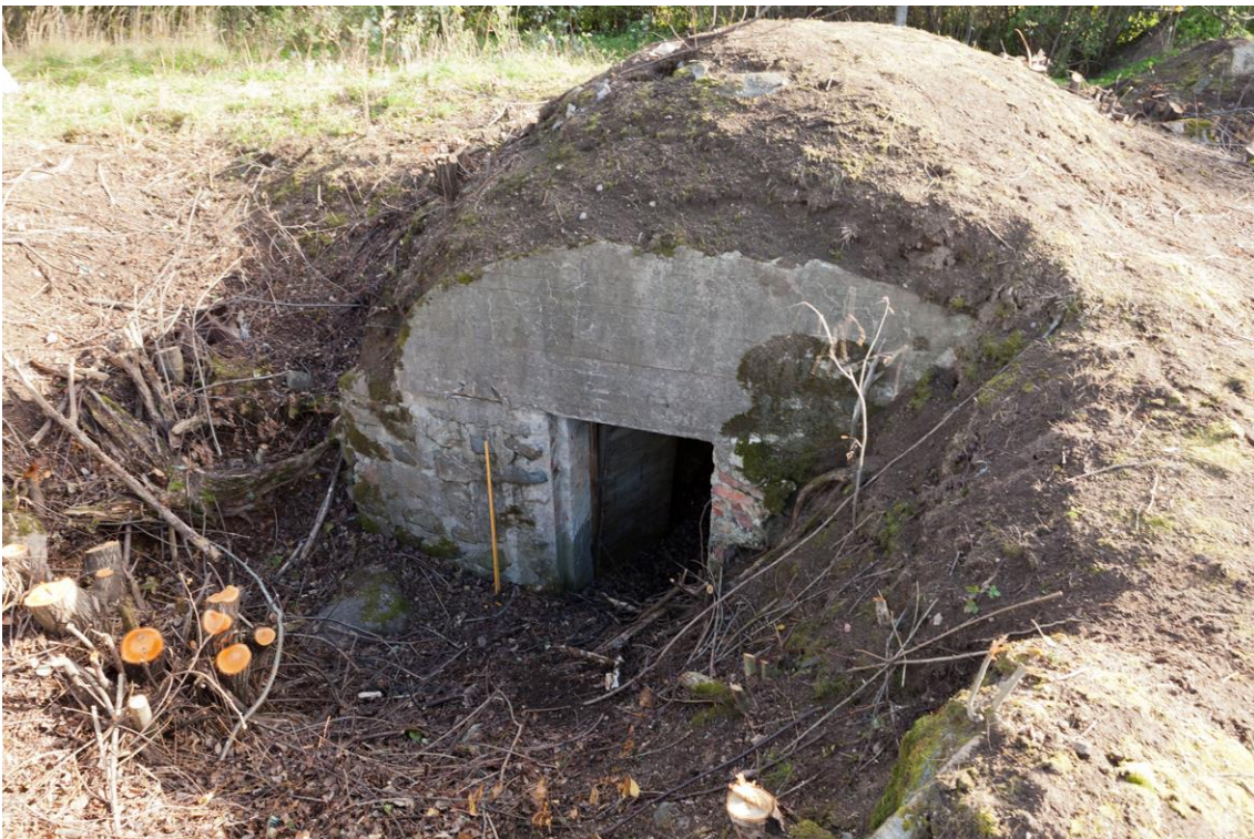
Suojahuoneen etuosa. Kuvattu lounaasta. (AKDG5572: 9)
