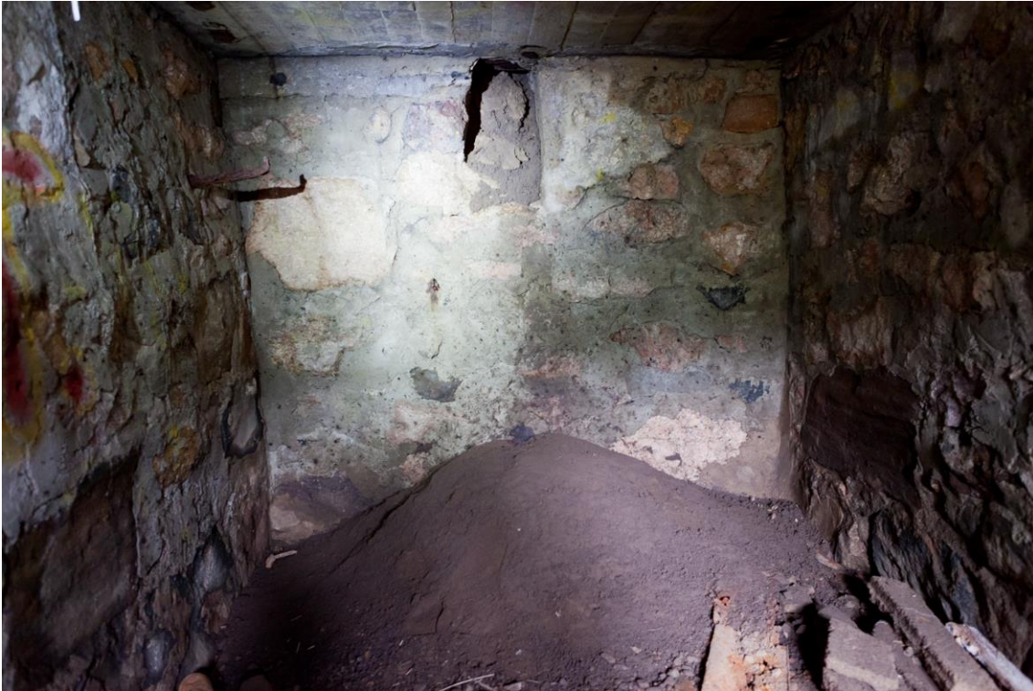
Suojahuoneen 1 takaseinä. (AKDG5573: 10)
