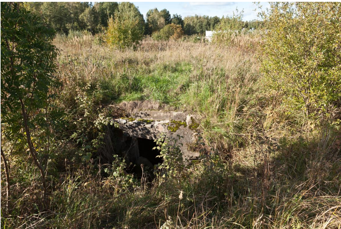
Suojahuone 2, kuvattu lännestä. (AKDG5573: 14)
