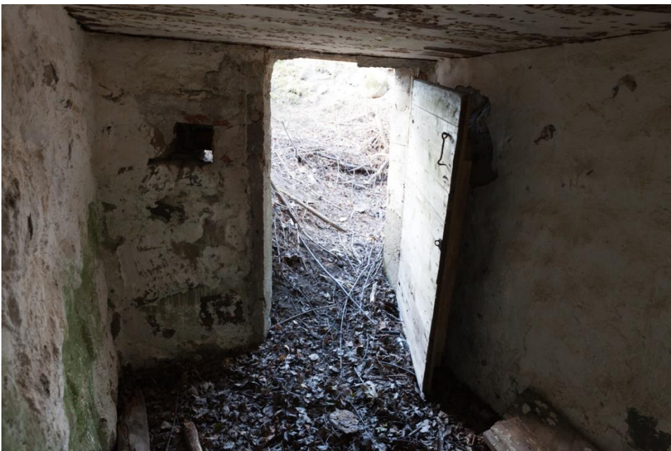
Kuva AKDG5572: 13. Suojahuoneen etuosa ja oviaukko sisältäpäin kuvattuna.
