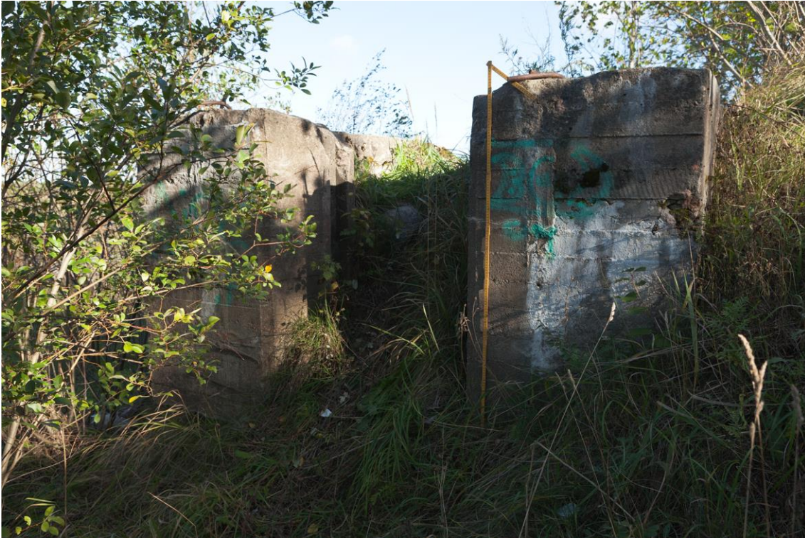
Tähystysaseman takaseinä, kuvattu etelästä. (AKDG5572: 17).
