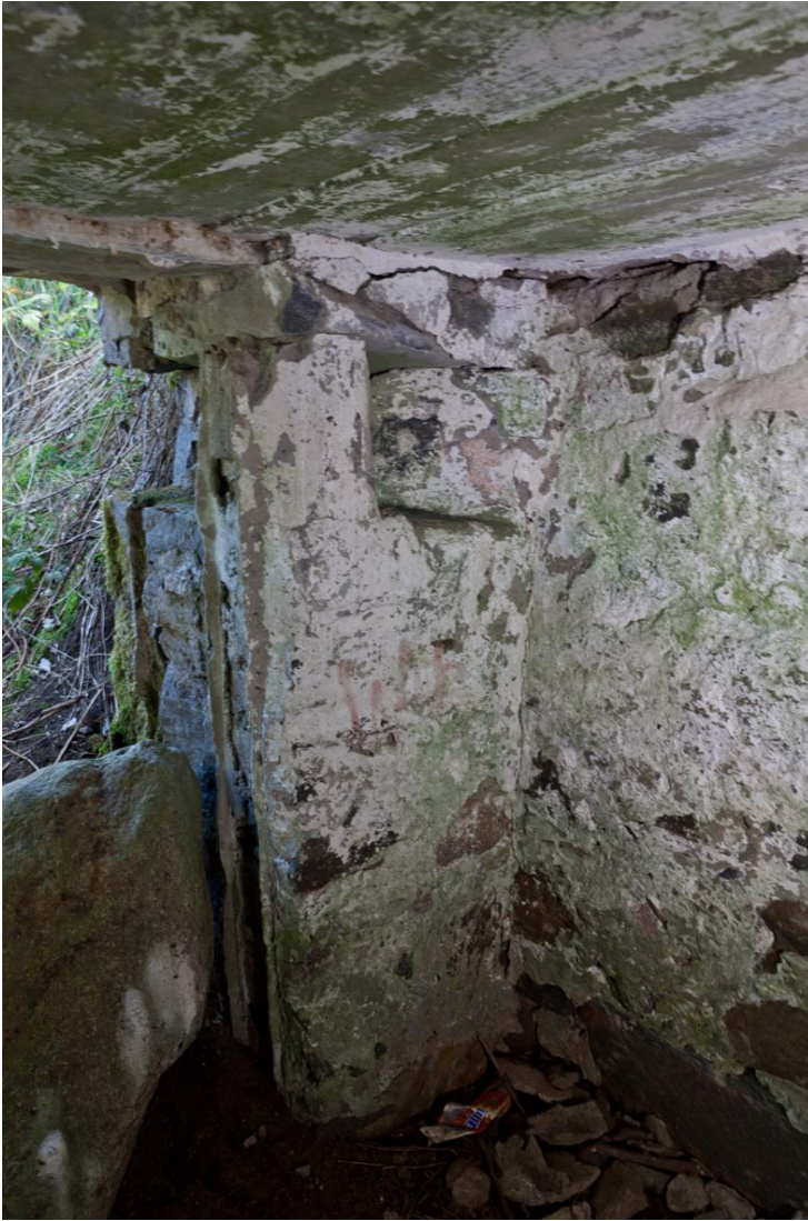
Suojahuoneen oviaukon eteläpuolisen seinämän läpäisevä viisto aukko. (AKDG5573: 19)
