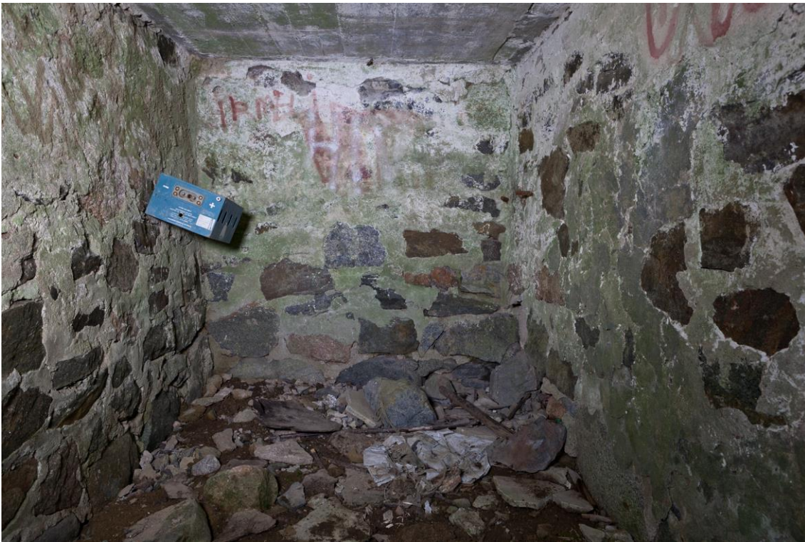
Suojahuoneen 2 takaseinä (AKDG5573: 18)
