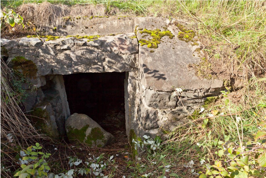
Suojahuoneen 2 betonikatetta. (AKDG5573: 17)
