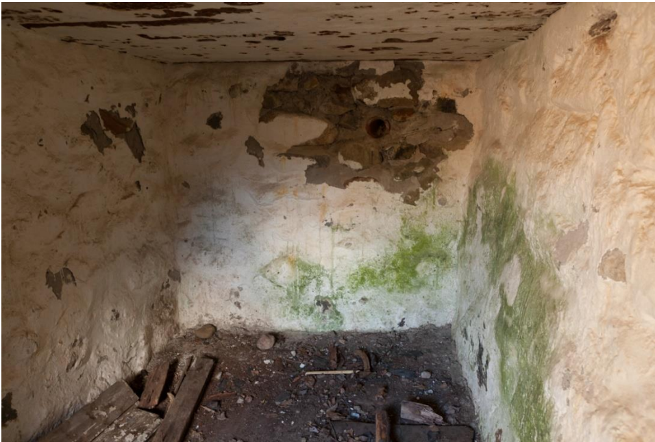
Suojahuoneen takaseinä. (AKDG5572: 12)
