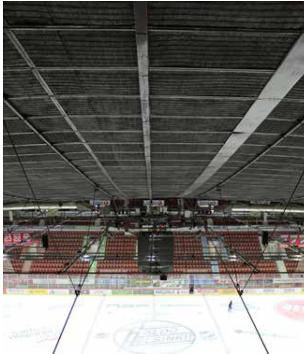
Kuva 53. Kattorakenne koilliskatsomon korkeimmalta kohdalta.
