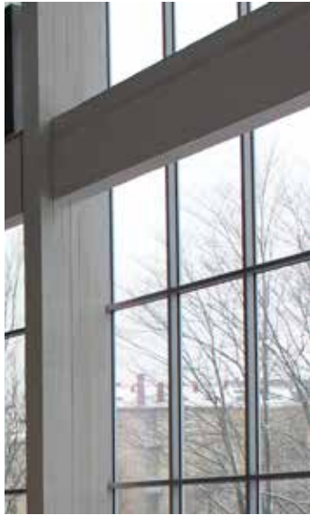
Kuva 47. Lasijulkisivua sisältäpäin kuvattuna.
