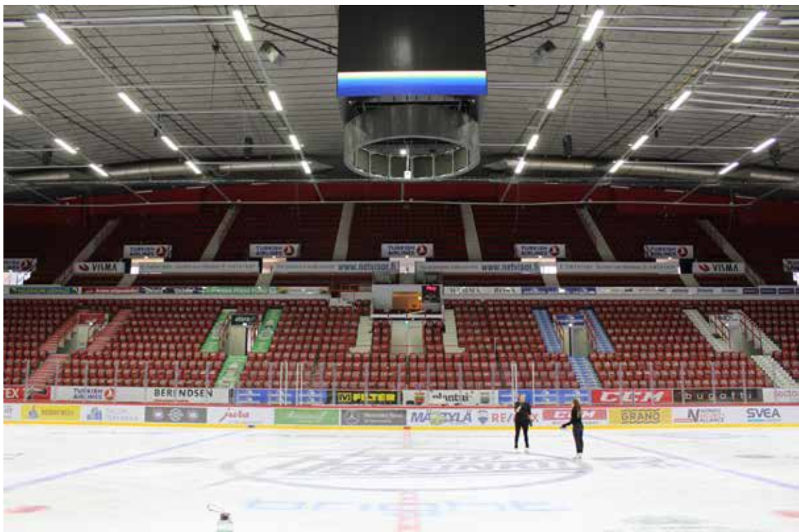
Kuva 46. Areena ja katsomot nykyisin. Puupenkit ja yläosan seisomakatsomot on korvattu taittuvilla istuimilla ja lisätty teleskooppikatsomot. Yläkatsomon kaidejärjestelyt on muutettu vuonna 1974.
