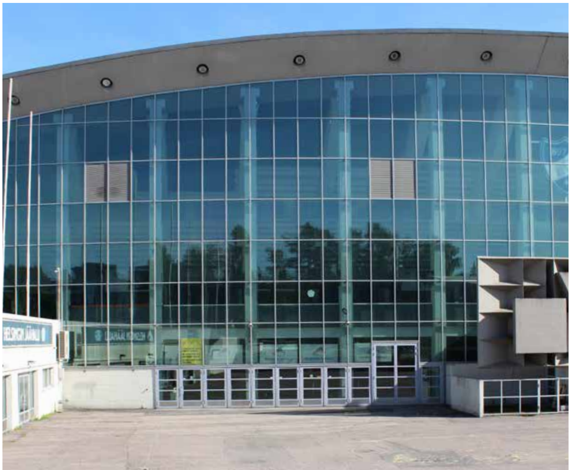
Kuva 49. Julkisivu luoteeseen Nordenskiöldin kadun suuntaan.
