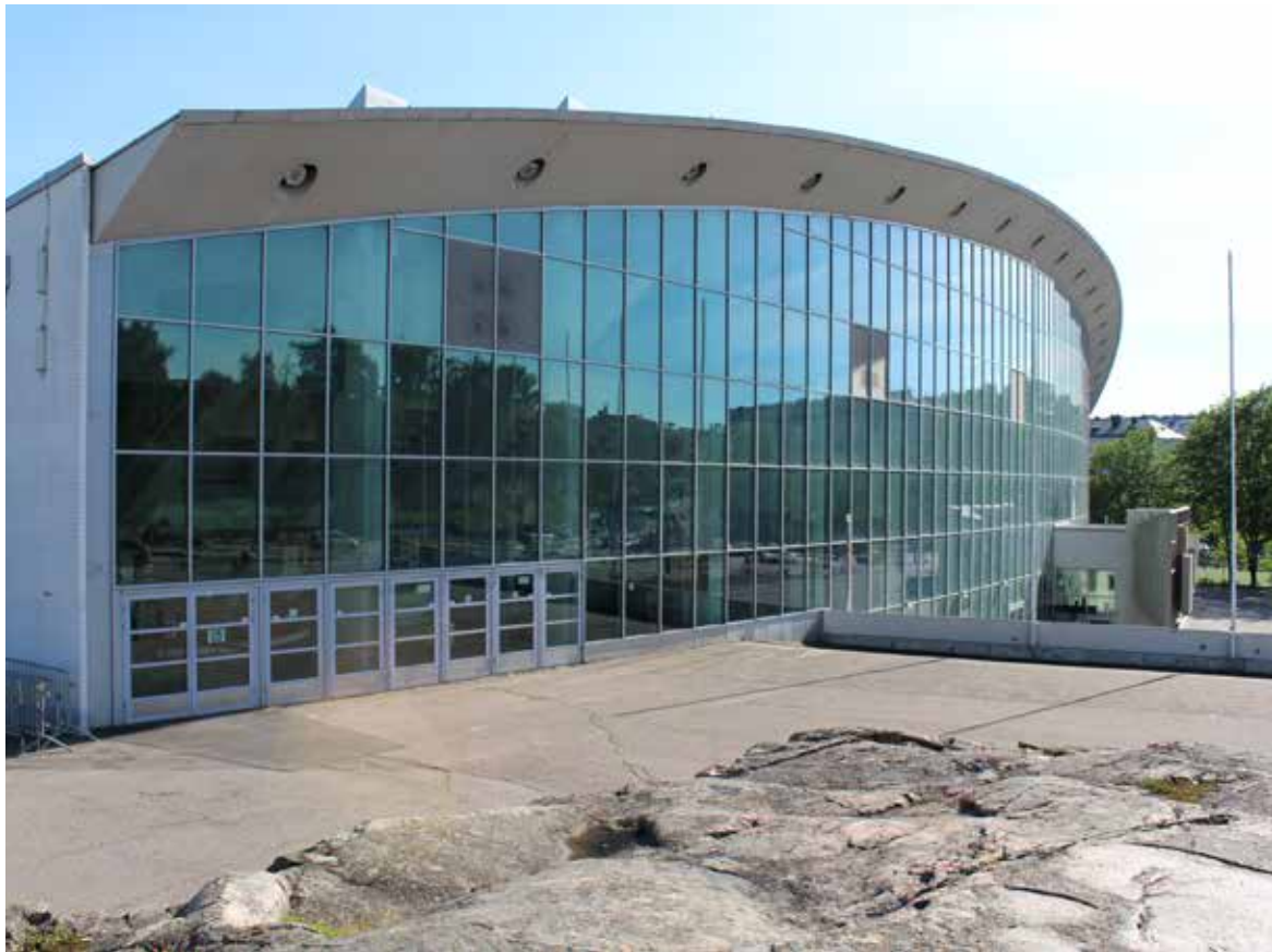
Kuva 43. Julkisivu Nordenskiöldinkadun kallioilta nykyisin. Lehistökeskus ja toimistotilat on rakennettu betonikannen alle vuonna 1980.
