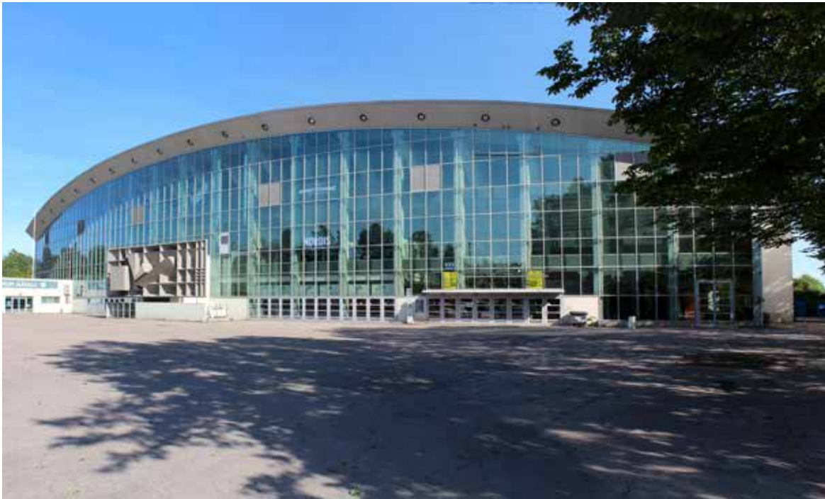
Kuva 41. Jäähalli Nordenskiöldinkadun suunnasta nykyisin. Lasiseinät on uusittu ja betonipinnat kunnostettu vuoden 1999 korjauksessa. Samassa yhteydessä on rakennettu myös tuulikaapit ja sisäänkäyntikatokset.
