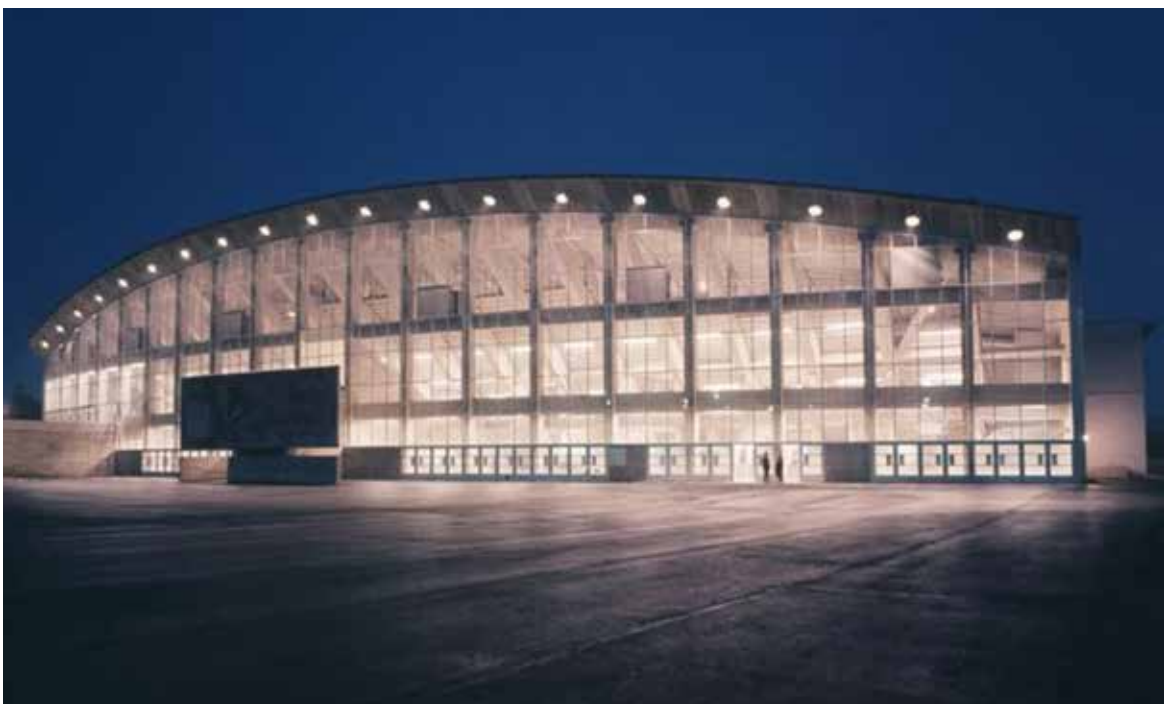
Kuva 42. Julkisivu alkuperäisessä asussaan. Lasin takaa näkyvät katsomon betonirakenteet muodostavat osaltaan julkisivun arkkitehtuuria. Kuvälähde: Kuvaaja Teuvo Kanerva, Museoviraston kuvakokoelmat
