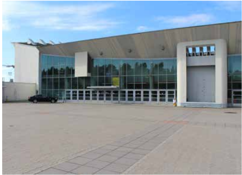
Kuva 48. Koillisjulkisivu harjoitusjäähallin katolla sijaitsevan aukion suuntaan.
