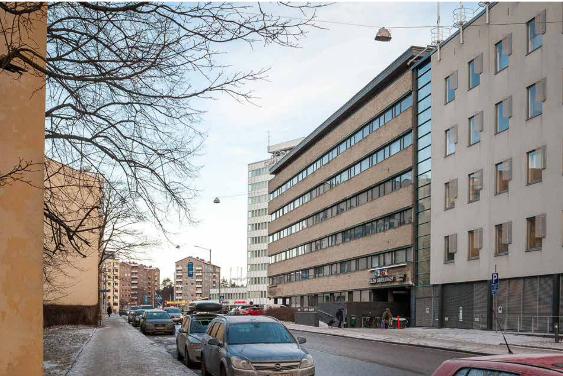
Kun uusi Työterveyslaitos rakennettiin kiinni Töölön Urheilutalon päättyyn, jäi liikuntatilojen sisäänkäynti puristuksiin.
