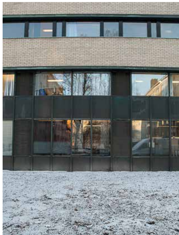
Pohjakerros erottuu muusta julkisivusta pronssilevyineen ja -säleikköineen.
