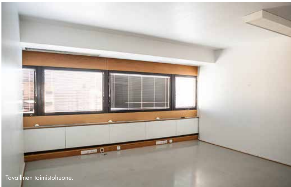
Sisennetyt kantavat pilarit jättävät ikkuna-ajan vapaaksi.
