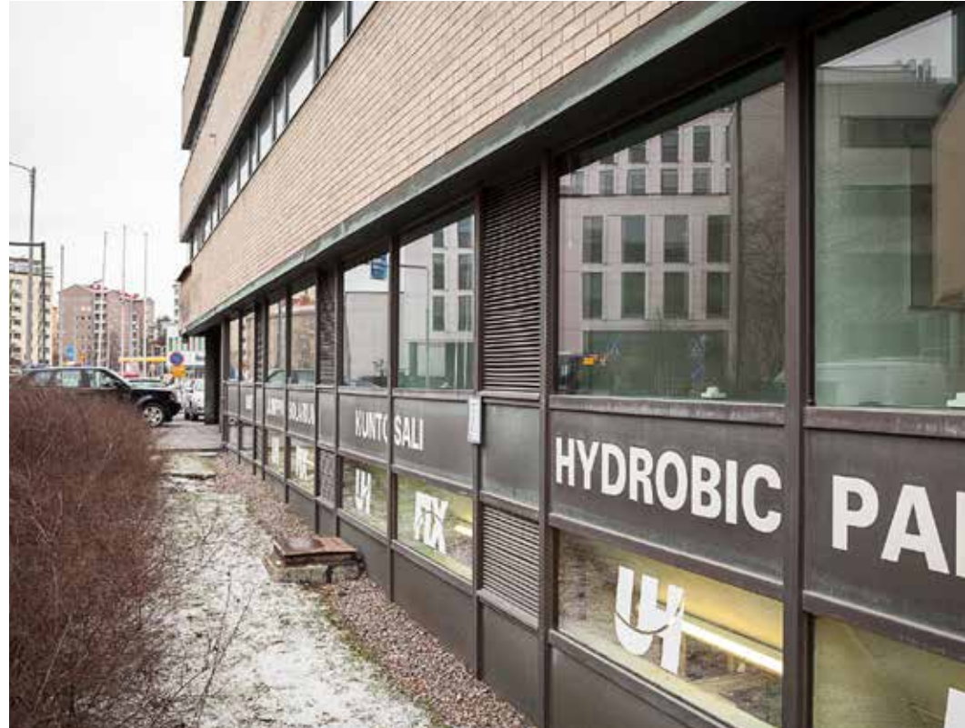
Topeliuksenkadun puolella välipohjan liittymä julkisivuun on detaloitu niin, että voimistelusalii on saatu ikkuna.
