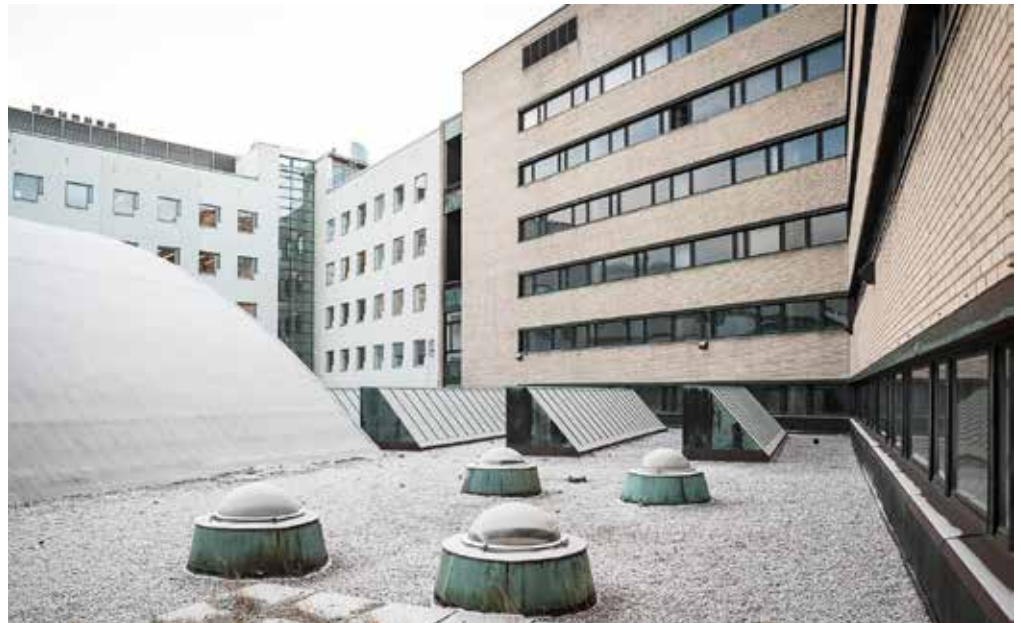
Ylhäällä: Katolle on myöhemmin lisätty ilmastointilaitteita putkistoineen. Vasemmalla: Osa kattolyhtyjen ikkunoista on vaihdettu.
