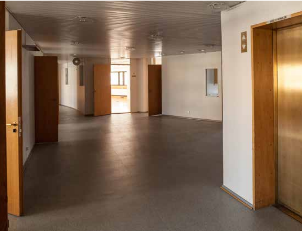
Viidennen kerroksen aulassa on tehty joitakin väliseinämuutoksia.
