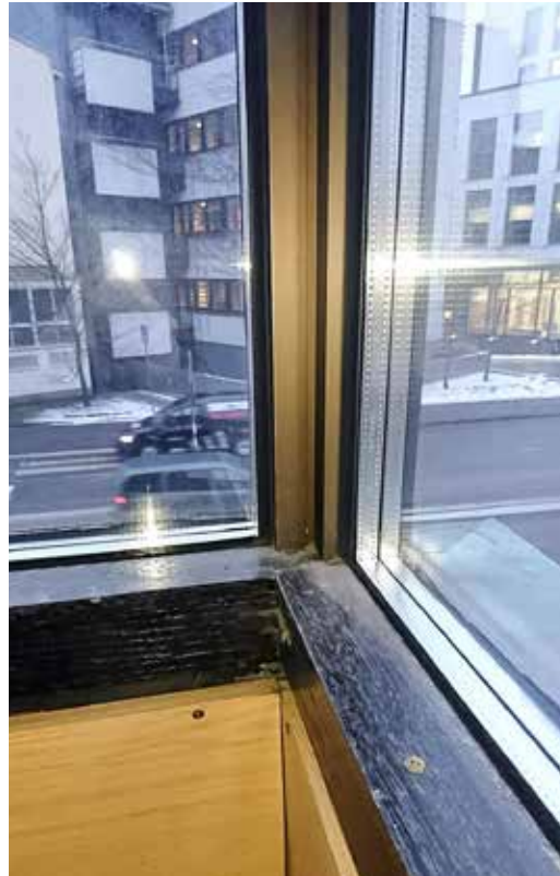
Ulkonurkan ikkunat on vaihdettu umpiolasielementeiksi.
