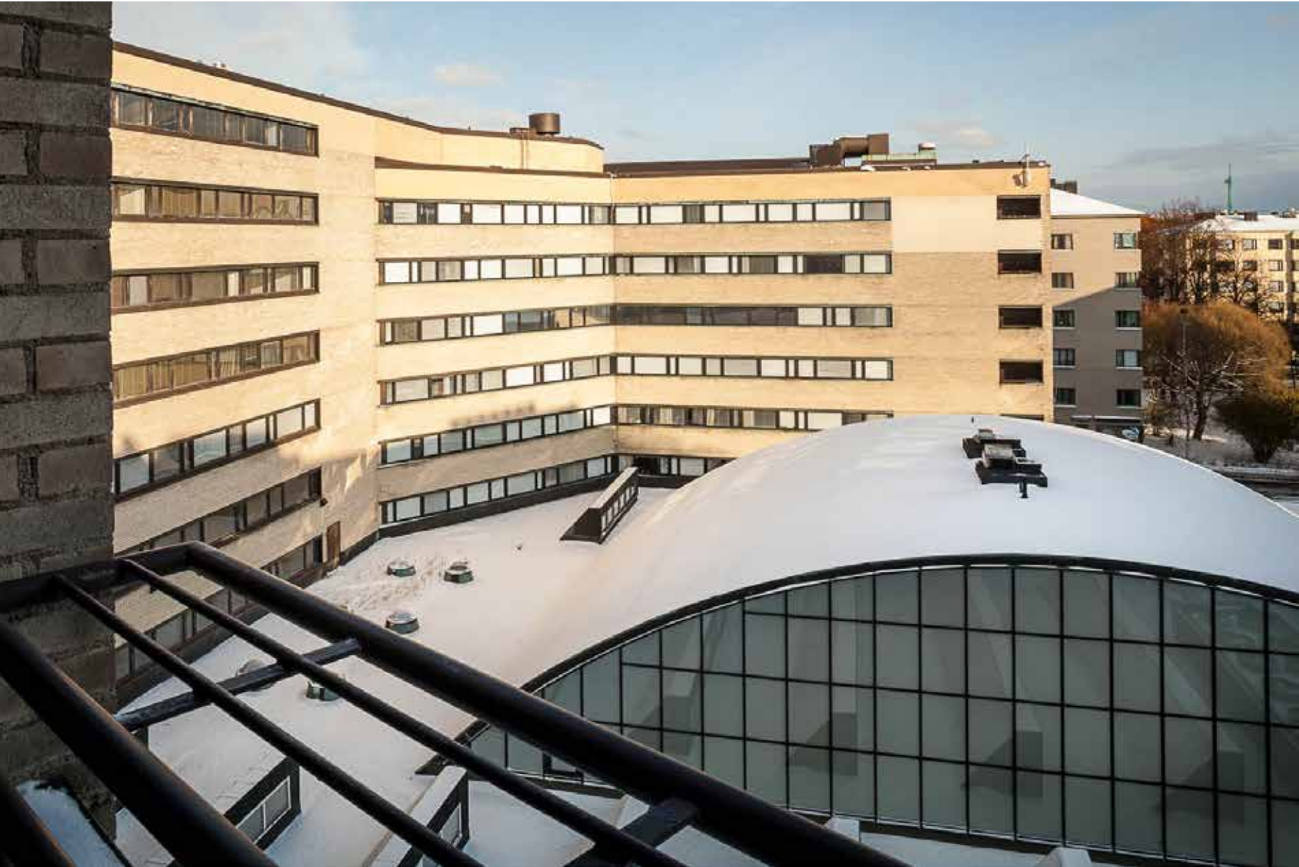
Urheilu- ja uimahallien katto ja sisäpihan puoleinen julkisivu toimistosiiven tuuletusparvekkeelta nähtynä.
