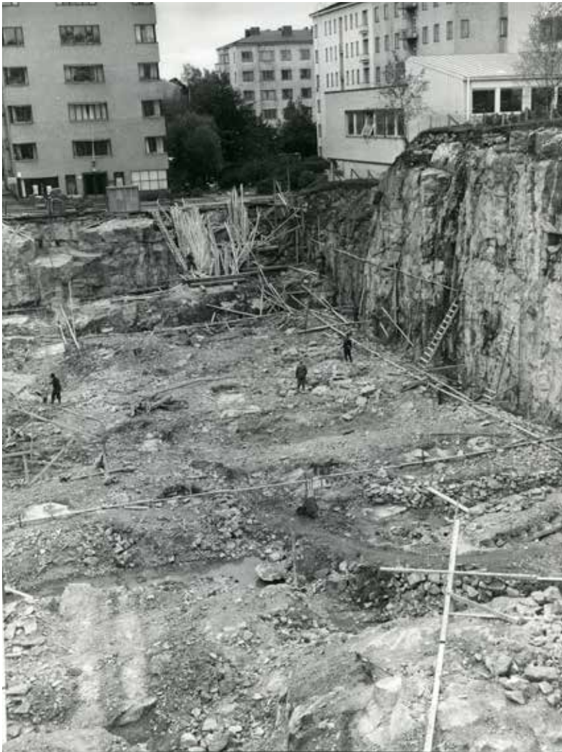
Työmaamonttu Topeliuksenkadun puolelta katsottuna. THA
