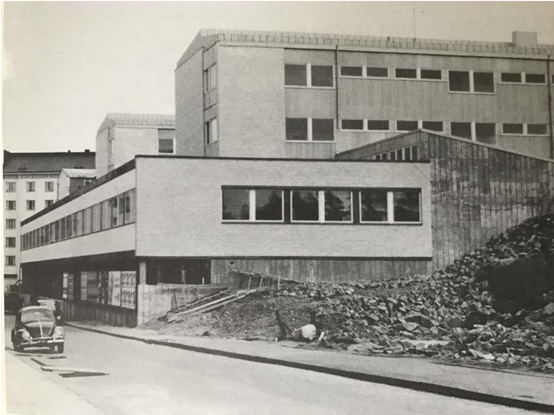
Rakennustyöt loppusuoralla. Kadun varren julkisivujen verhoilut ja pellitykset ovat valmiit, siipirakennuksista puuttuu vielä mineriittilevyverhous ja ikkunoiden pellitykset. (Kuva teoksesta Jukka Haavisto, Aikuiset opintielä. Myynti- ja mainoskoulu Markkinointi-instituutti 1930 – 1990, Markkinointi-instituutin Kannatusyhdistys ry, Helsinki, 1990, 126)
