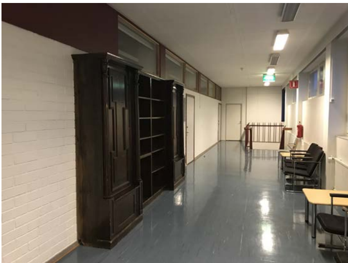
Käytävä ja kalusteet 3. krs (Töölöntullikatu 4)
