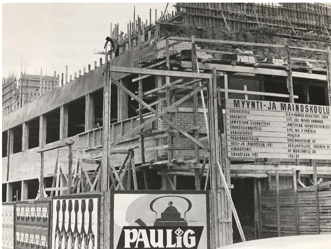
Kadun varren matalan osan päädyn muuraustyö käynnissä. Pääjulkisivun pilaristo ja ikkuna-aukotus antavat jo kuvan rakennuksen ulkoasusta. (Kuva teoksesta Jukka Haavisto, Aikuiset opintiellä. Myynti- ja mainoskoulu Markkinointi-instituutti 1930 – 1990, Markkinointi-instituutin Kannatusyhdistys ry, Helsinki, 1990, 122)
