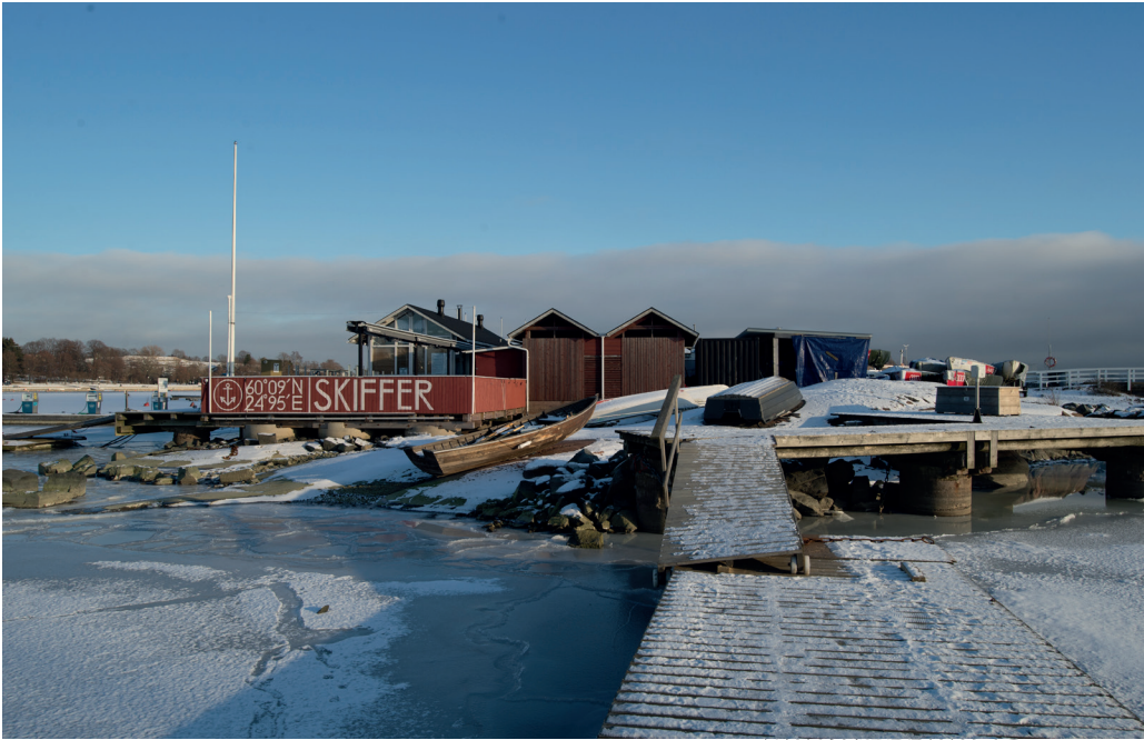
2. Liuskaluodon nykyistä rakennuskantaa.
