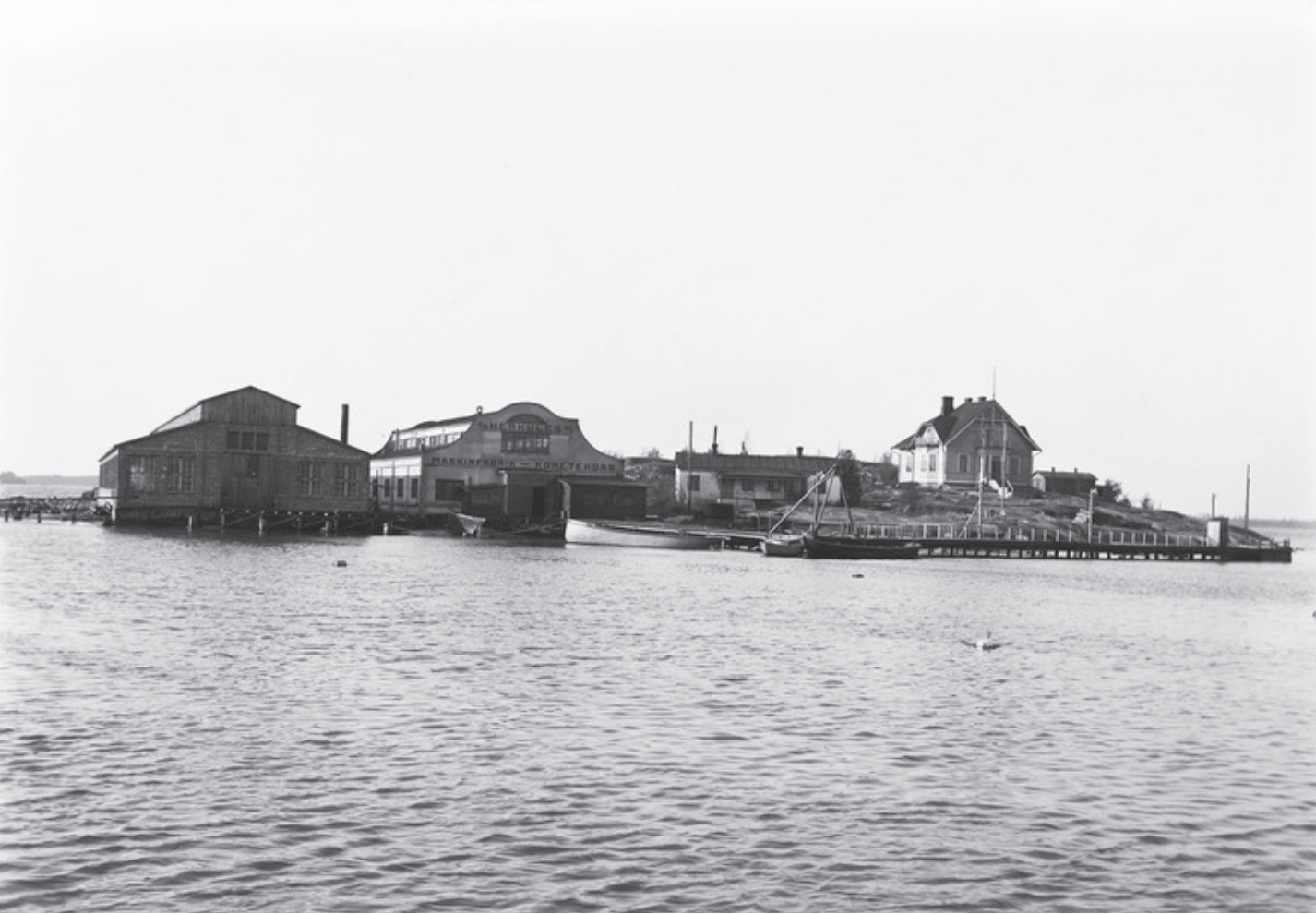
Konepaja Herkuleen tehdasrakennukset 1910-luvulla, kuva: P. Torniainen, HKM
