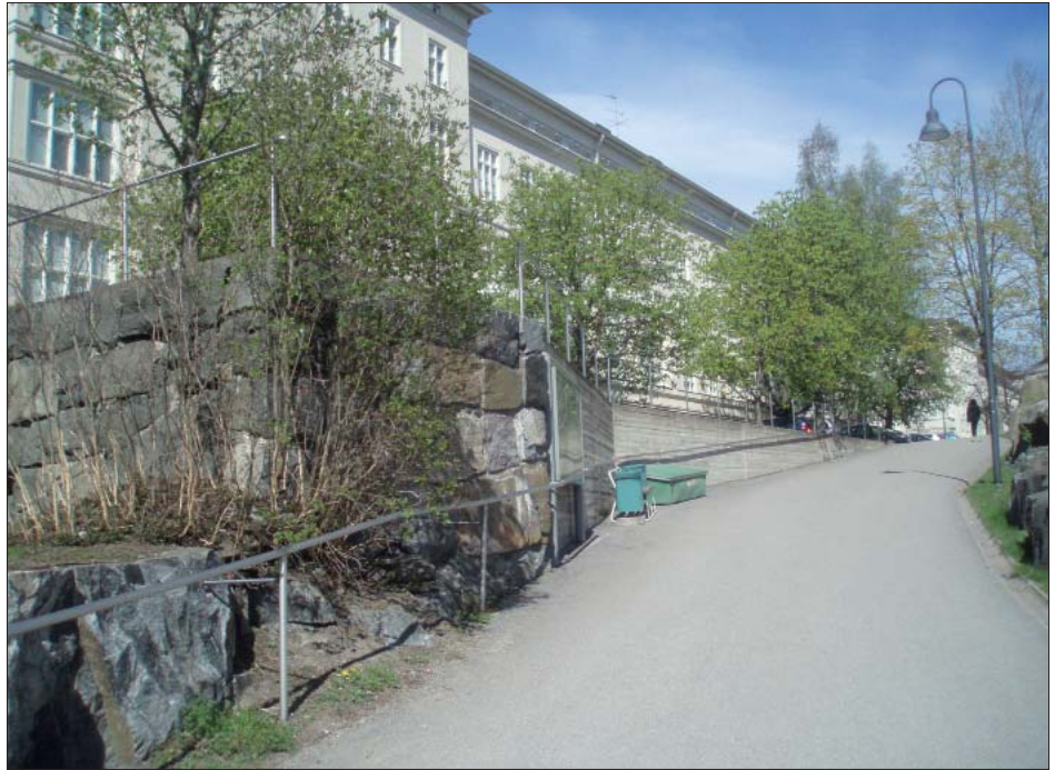
Kuva 16. Nykyinen pelastus- ja huoltotie. Rakennuksen 2 päädyssä olevan tukimuurin pää on vasemmalla.
