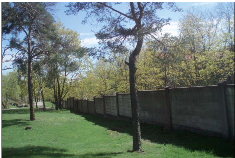
Kuva 14. Betoniaita on piha-alueen kokoava elementti.
