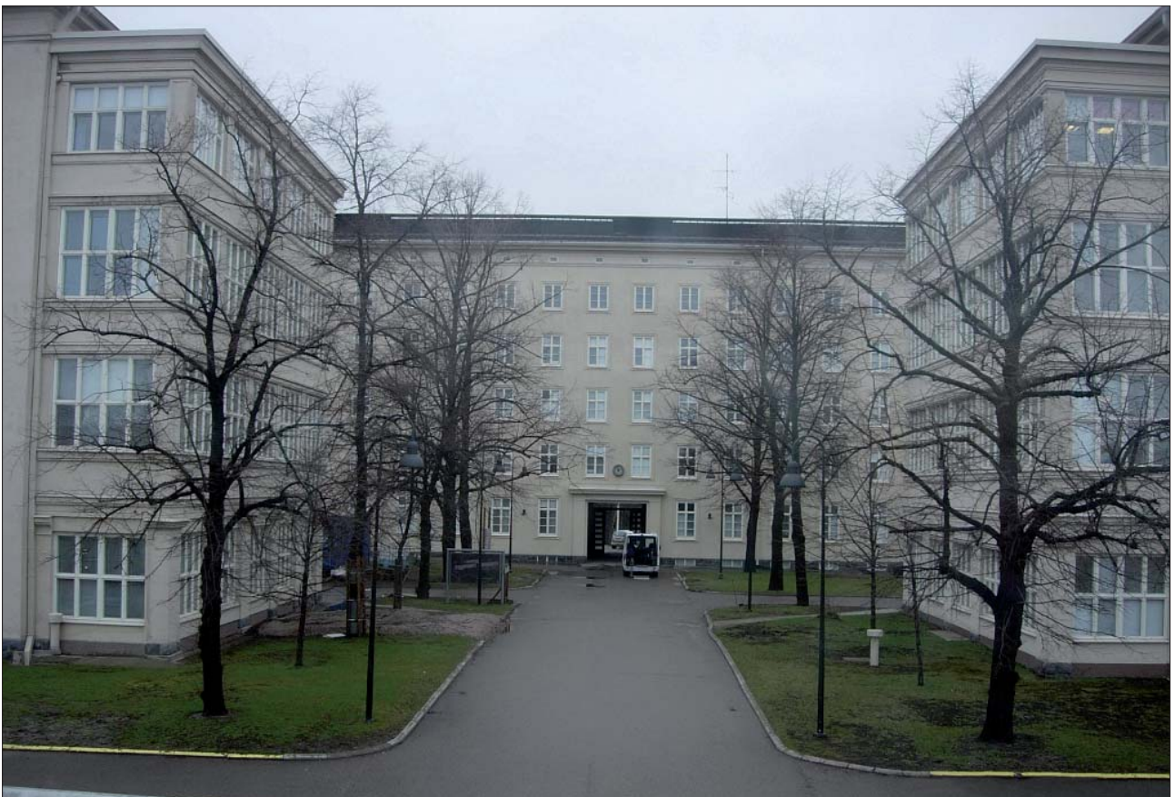
Kuva 19. Sama kuva 80 vuotta myöhemmin. Kuvasta näkyy myös, miten alkuperäiset potilasparvekkeet on aikanaan rakennettu umpeen.
