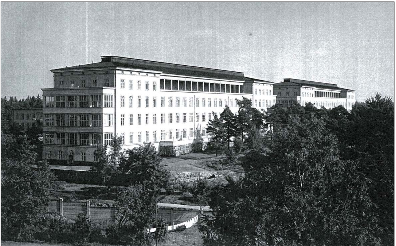
Kuva 15. Läntisen potilaspaviljongin (rakennus 2) päädyssä oleva tukimuuri ulottui alkuperäisessä laajuudessaan kalliorinteelle asti. Lähde: Kaupunginmuseon arkisto.
