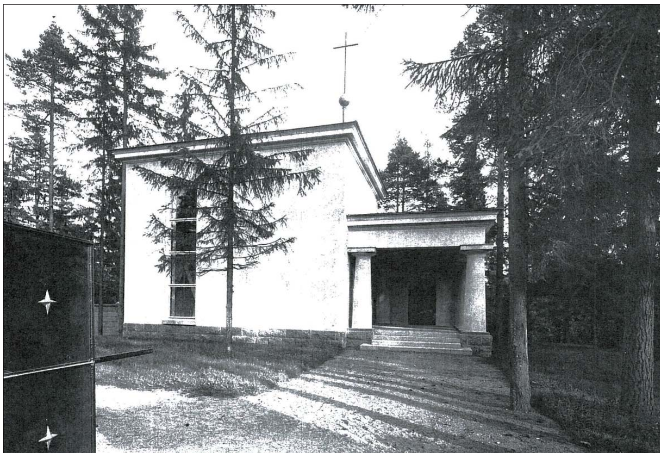
Kuva 2. Siunauskappelin alkuperäinen käyntiportti oli vastapäätä sisäänkäyntikatosta. Vasemmalla näkyy tähtikoristeisen portin kulma. Lähde: Kaupunginmuseon arkisto.
