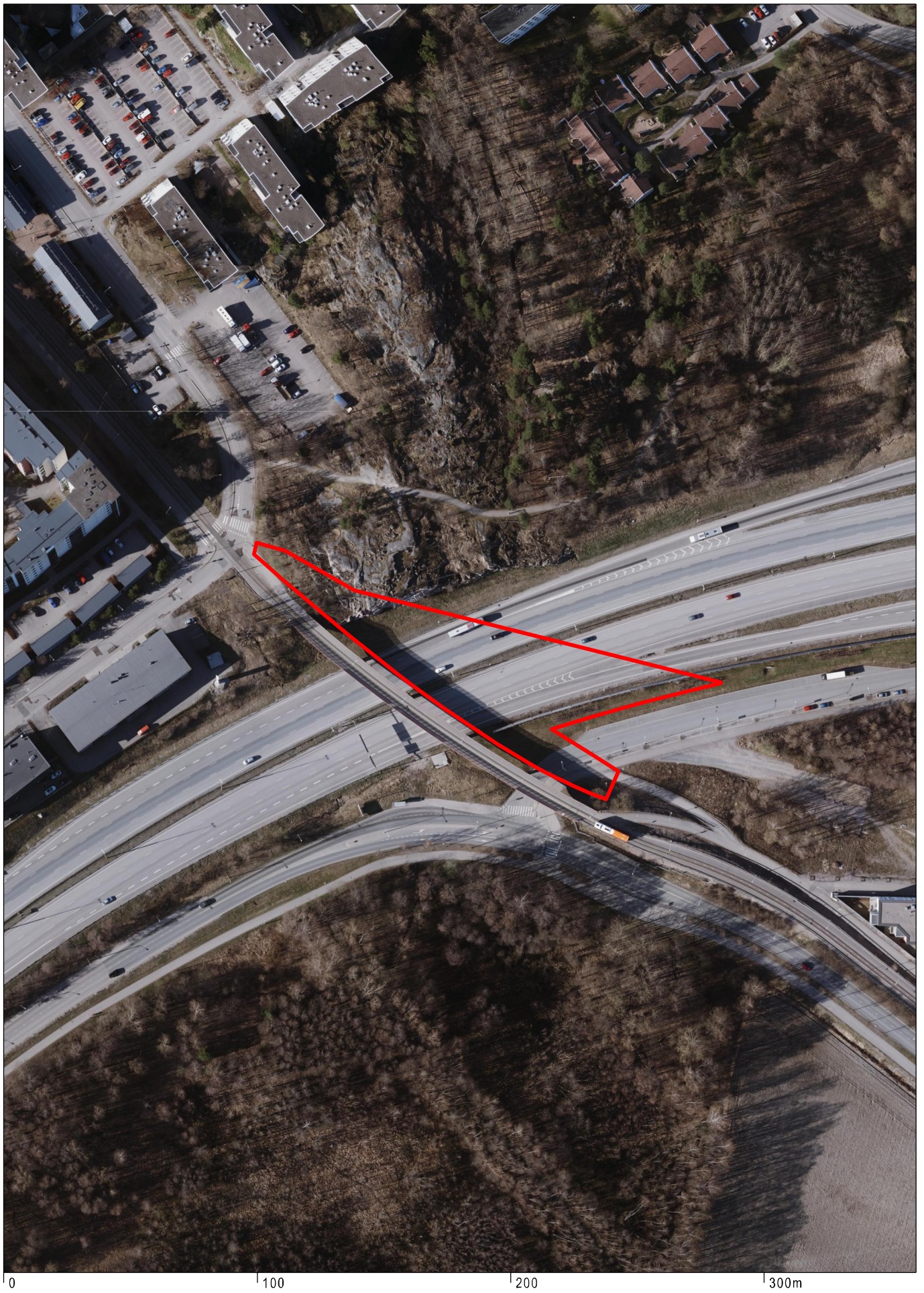
Ilmakuva 5. Lahdenväylän silta
