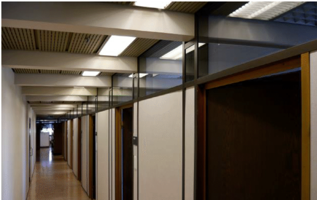
Toimistotilojen sekundääripalkkirakenteet
