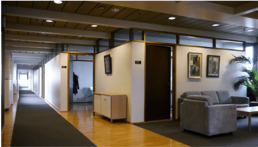
Alkuperäisiä lasiseinäisiä väliseinärakenteita
